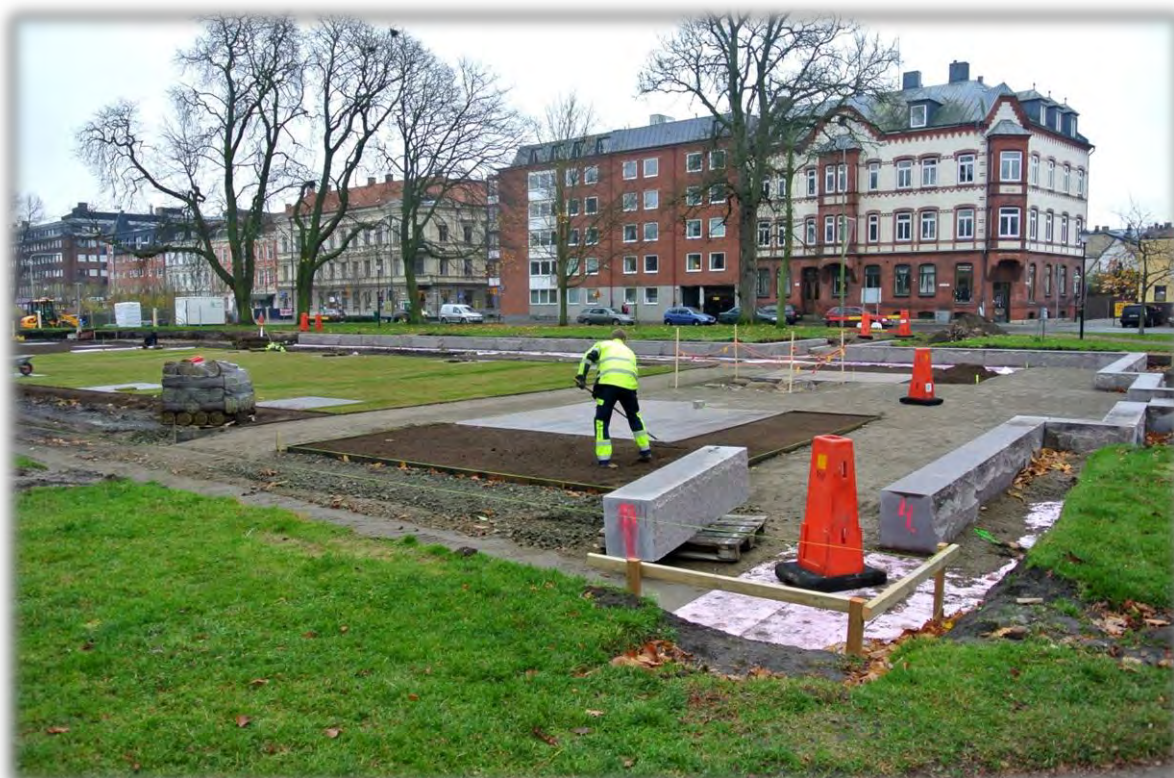
Bild 46. Gräsmattorna, levererade i rullar, läggs på plats efterhand som arbetet fortskrider.
