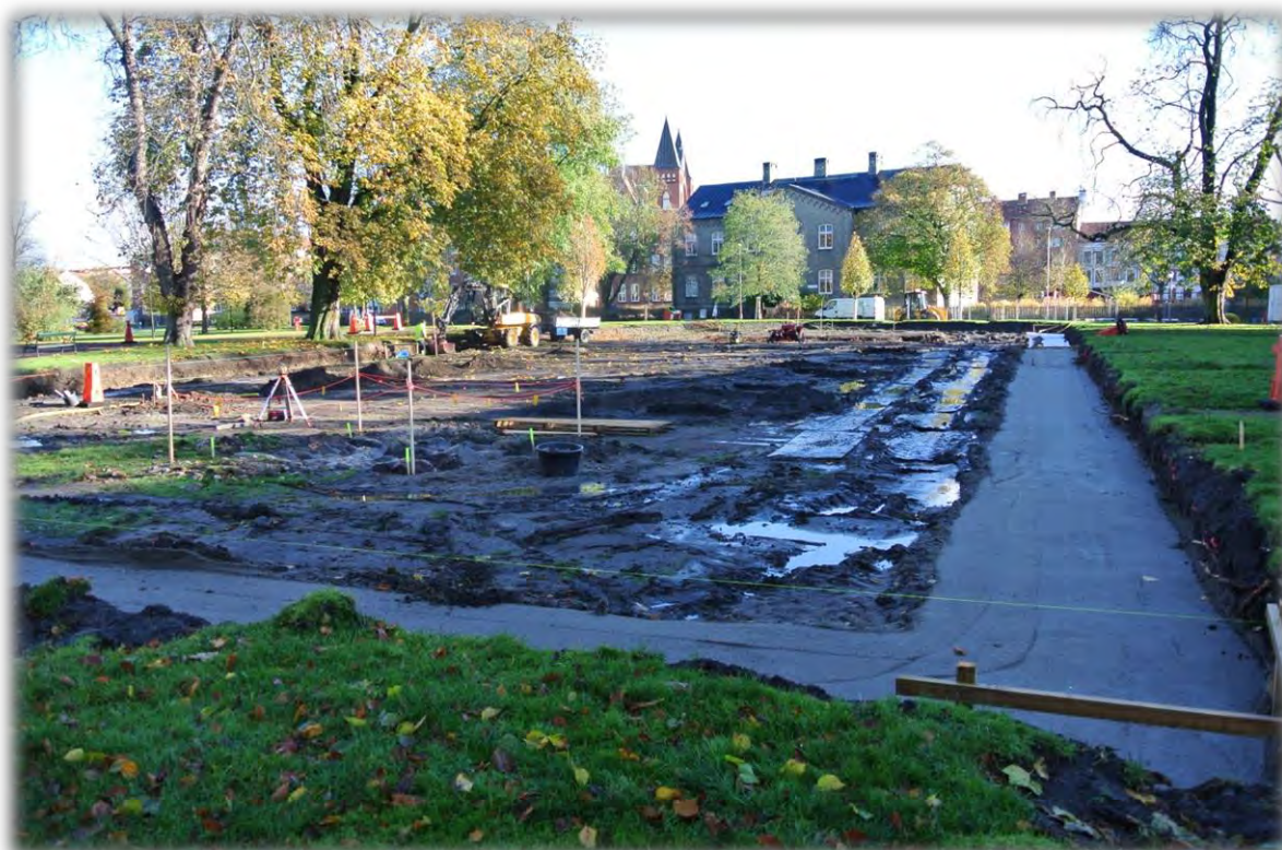
Bild 44. Den andra fasen har inletts och marken jämnas till inför stenläggningen. Förutom regn kom senare även ymniga snöfall vilket försenade arbetet.
