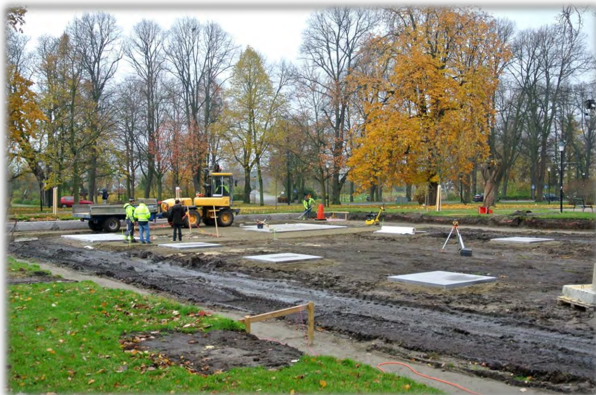
Bild 45. Stenläggningen är igång. Hällstenarna som markerar tornet och mittskeppspelarna placeras ut och i bakgrunden syns den påbörjade yttermuren.
