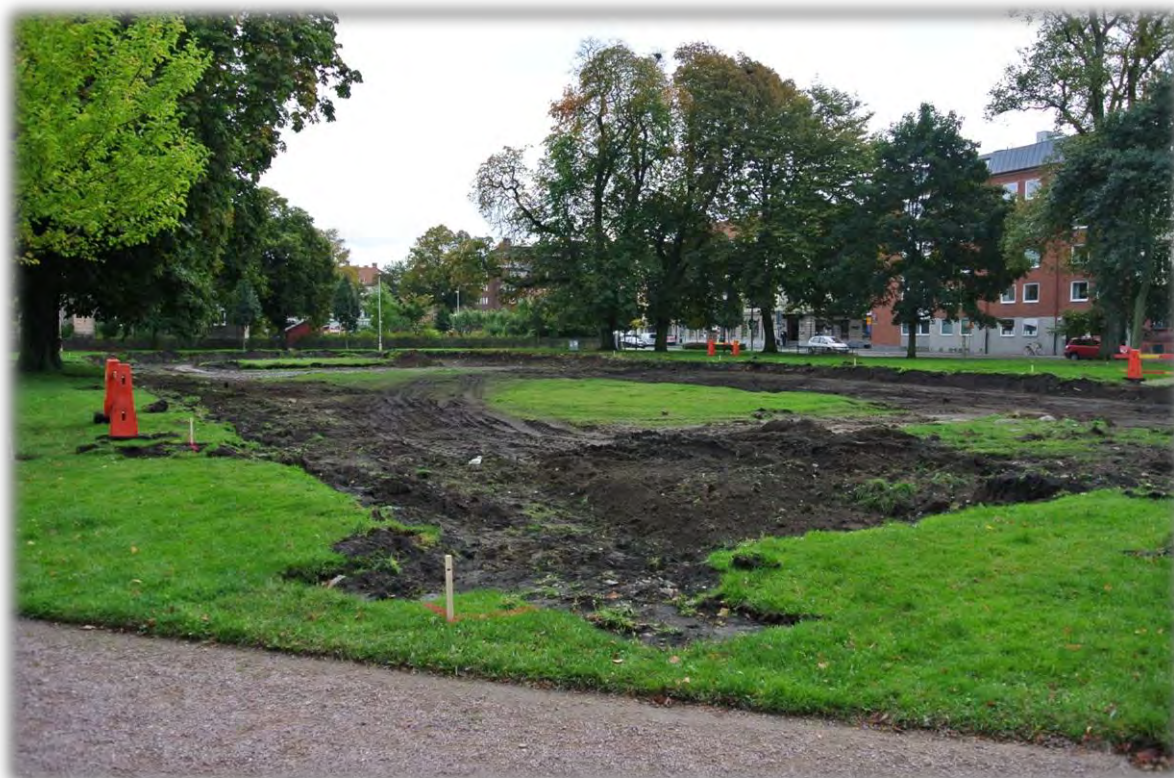
Bild 43. Första fasen har avslutats. Kallmur, stenhällar m.m. har tagits bort.
