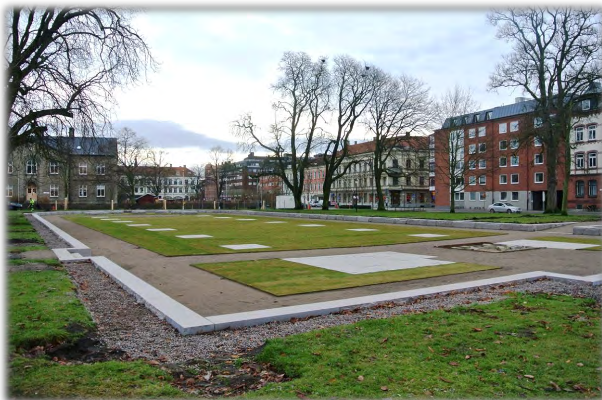
Bild 47. Färdigt, med undantag för lite städning. Arbetet slutfördes i januari 2013.
