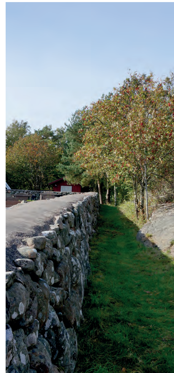
Figur 52. Bilden visar den norra sträckningen av muren runt Vrångö nya kyrkogård. Muren är utförd av fältsten vilket ger muren en förhållandevis ålderdomlig karaktär.
