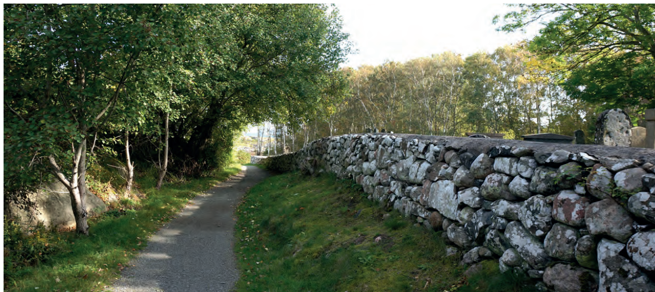
Figur 47. Runt den gamla kyrkogården löper en äldre naturstensmur som är kallmurad. Stenmaterialet utgörs främst av fältsten vilket ger muren ett livligt uttryck.
