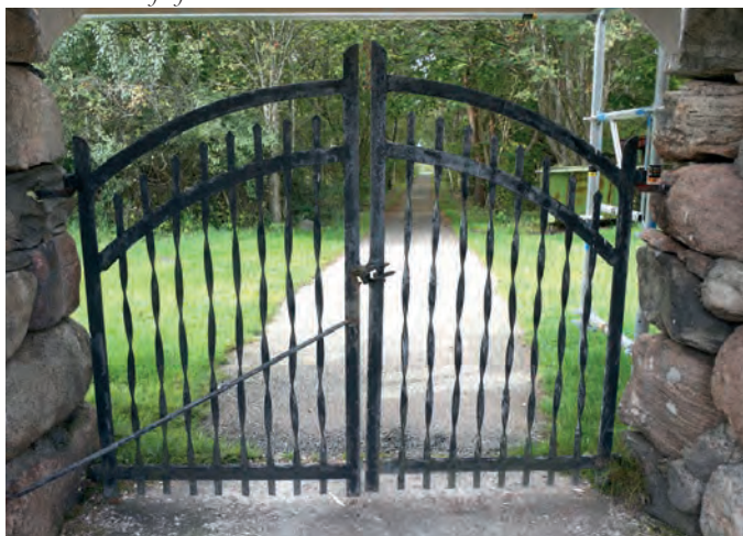
Figur 50. Mellan fundamenten till klockstapeln sitter en järngrind som markerar entrén till Vrångö nya kyrkogård.
