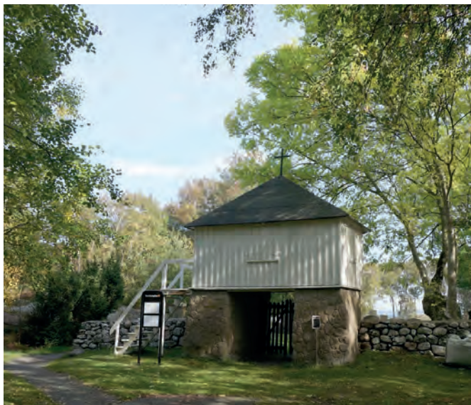
Figur 56. Båda kyrkogårdarna är uppförda på ett liknande sätt. Detta förstärker bilden av en lokal byggnadstradition.
