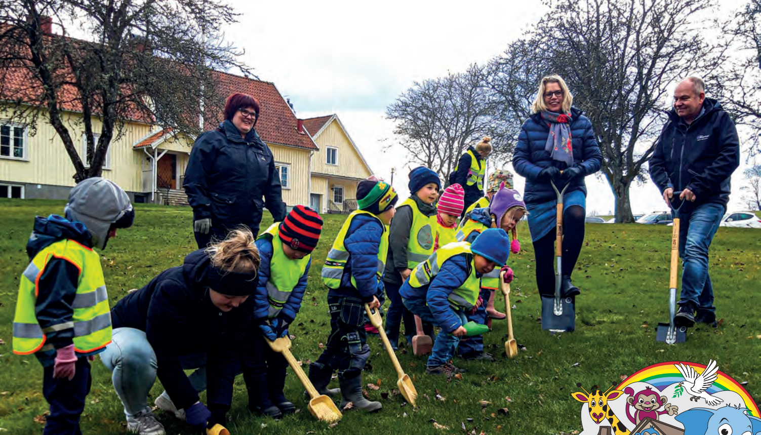
FÖRSTA SPADTAGEN: Förväntansfulla spadtag grävde "Barnens grop" där nya förskolan ska byggas!
