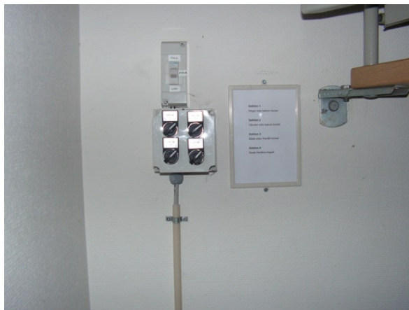
Till följd av det nya vattenburna uppvärmningssystemet kunde vi nu styra värmen till fem olika avdelningar i kyrkan.
