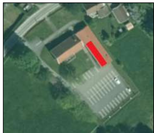
Anläggningens orientering (markerat med rött)
