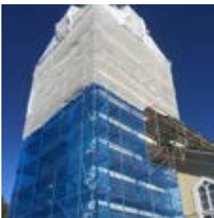
Renoveringsarbete på Stensele kyrka sid. 18 FOTO: TOMMY BERGLUND/IKON
