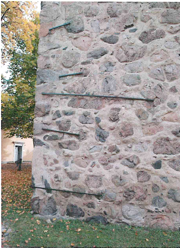
Bild 2-3: luckor och murkramlor efter målning.
