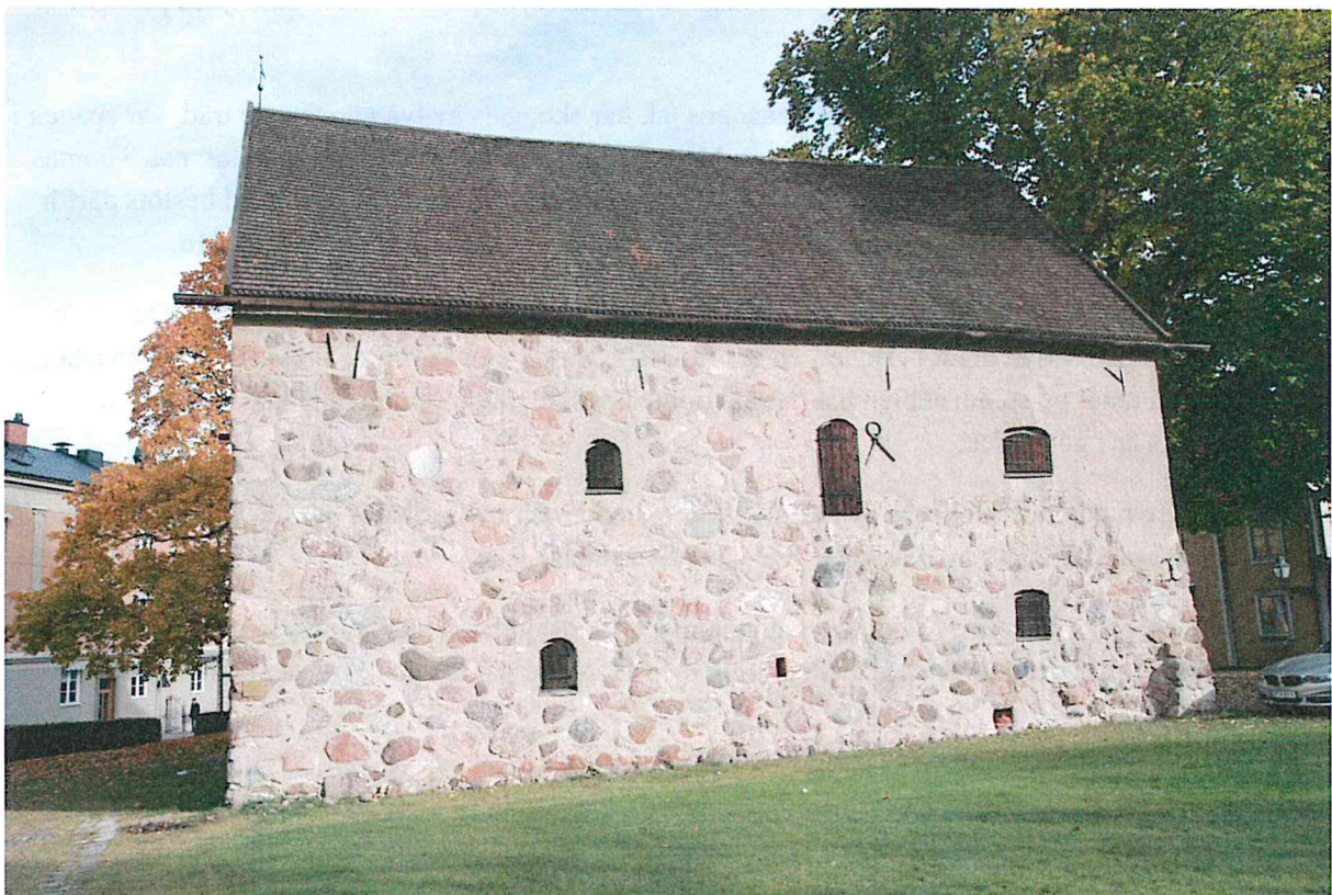
Bild 1: Rhyzeliusgården, västra fasaden med det tjärade takfallet. Ljusare partier är nylagda spånor.
