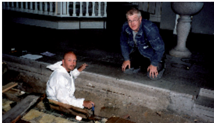
Vid renoveringen av Torbjörntorps kyrka hittades hussvamp i golvet. Mattias Åkerberg har gjort ett omfattande arbete med att ta bort svampen och Tomas Svensson kommer från byggfirman som har byggt om koret.
