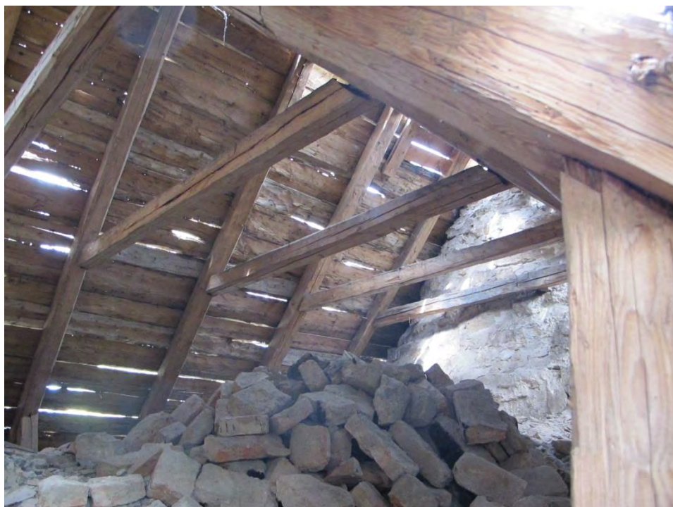
Takstolarna fotograferade vid en takomläggning. Foto Anneli Borg, Ölm.
