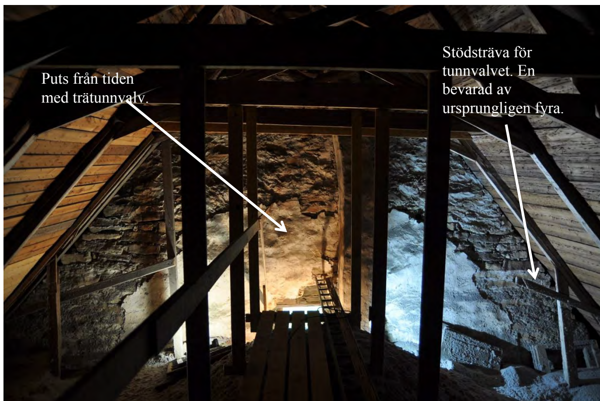
Spår av det gamla trätunnvalvet syns som avtryck på västra gaveln i form av puts, samt en bevarad stödsträva.
