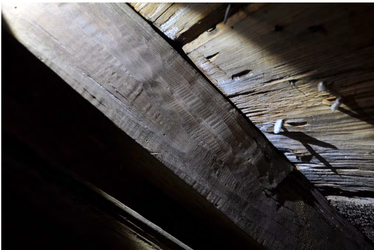
De flesta ytorna på taklagets högben och saxsparrar är hyvlade. I släpljuset syns de vibrationsmärken som lätt uppstår när man hyvlar med skave, en enkel form av hyvel.
