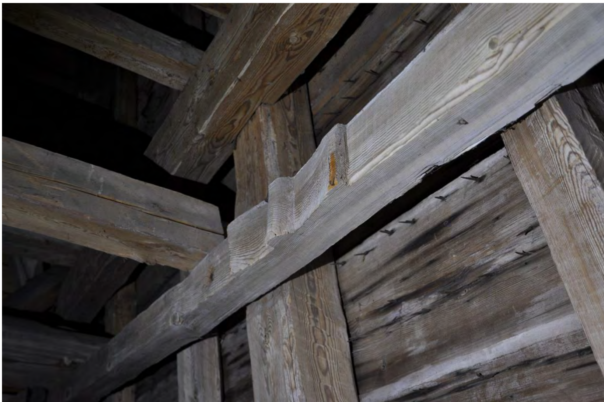
Stolparnas överliggare har en dekorativ vulst likt de på långhusets styrbjälke.
