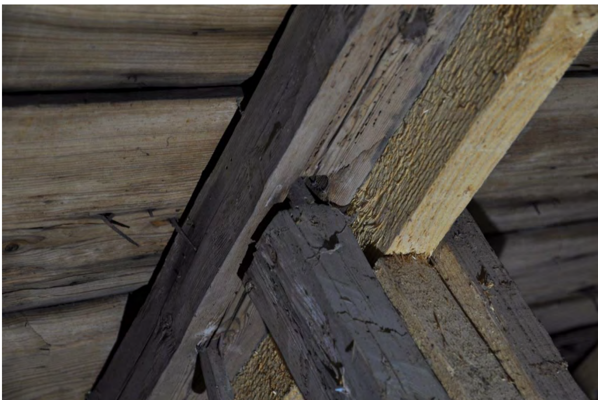
Stödbenens möte med högbenen består av tapp och tapphål, och saknar även de låsning.
