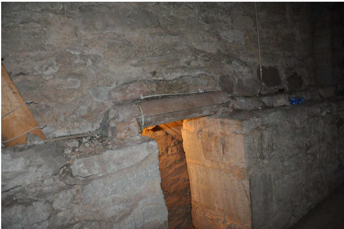
Bilden tagen från sakristians vind och visar öppningen till trappan som leder ned till långhuset. Ovanför öppningen finns ett fint utformat överstycke.
