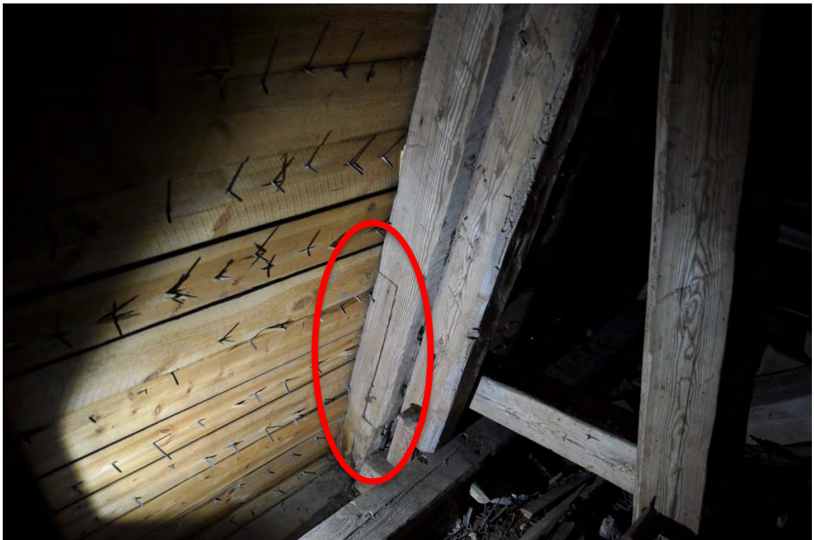
Sparren är skarvad med en mycket kort bit i form av en enkel bladning.
