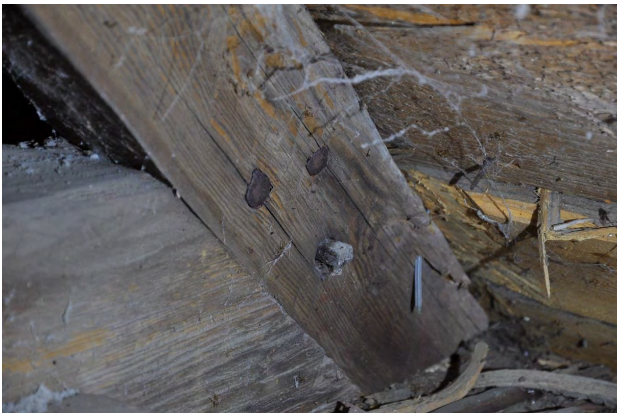
Möte mellan bindbjälke och högben på södra sidan. Två spikar samt en kraftigare järndympling låser knuten.
