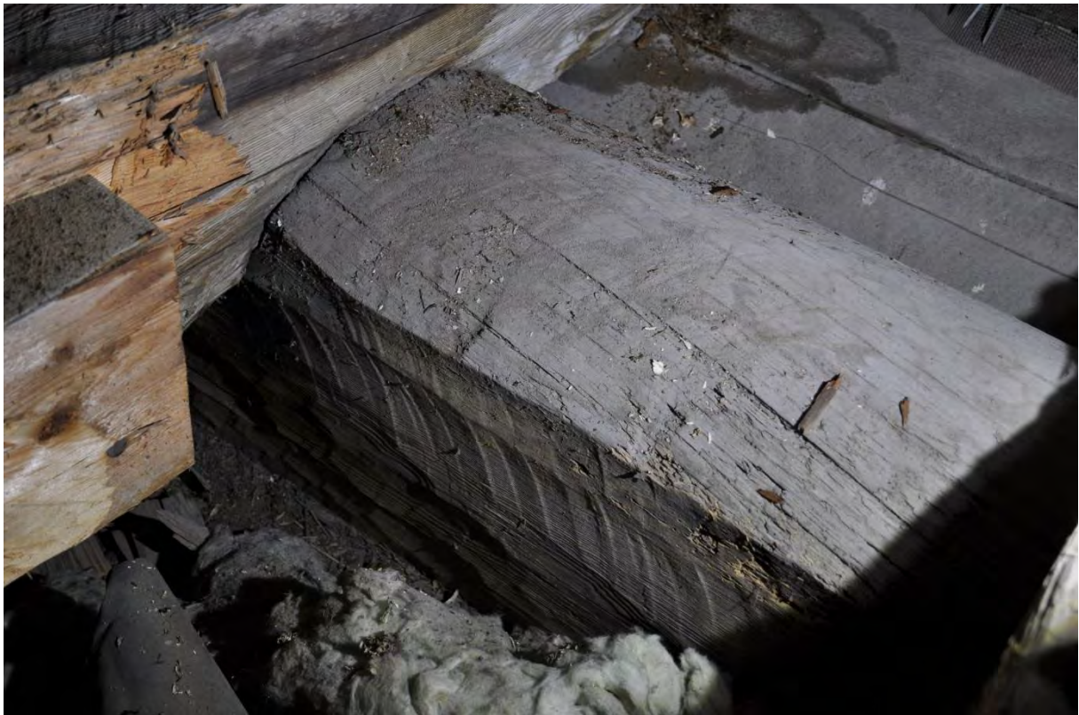
Östra remstycket på norra sidan med obearbetad ovansida.
