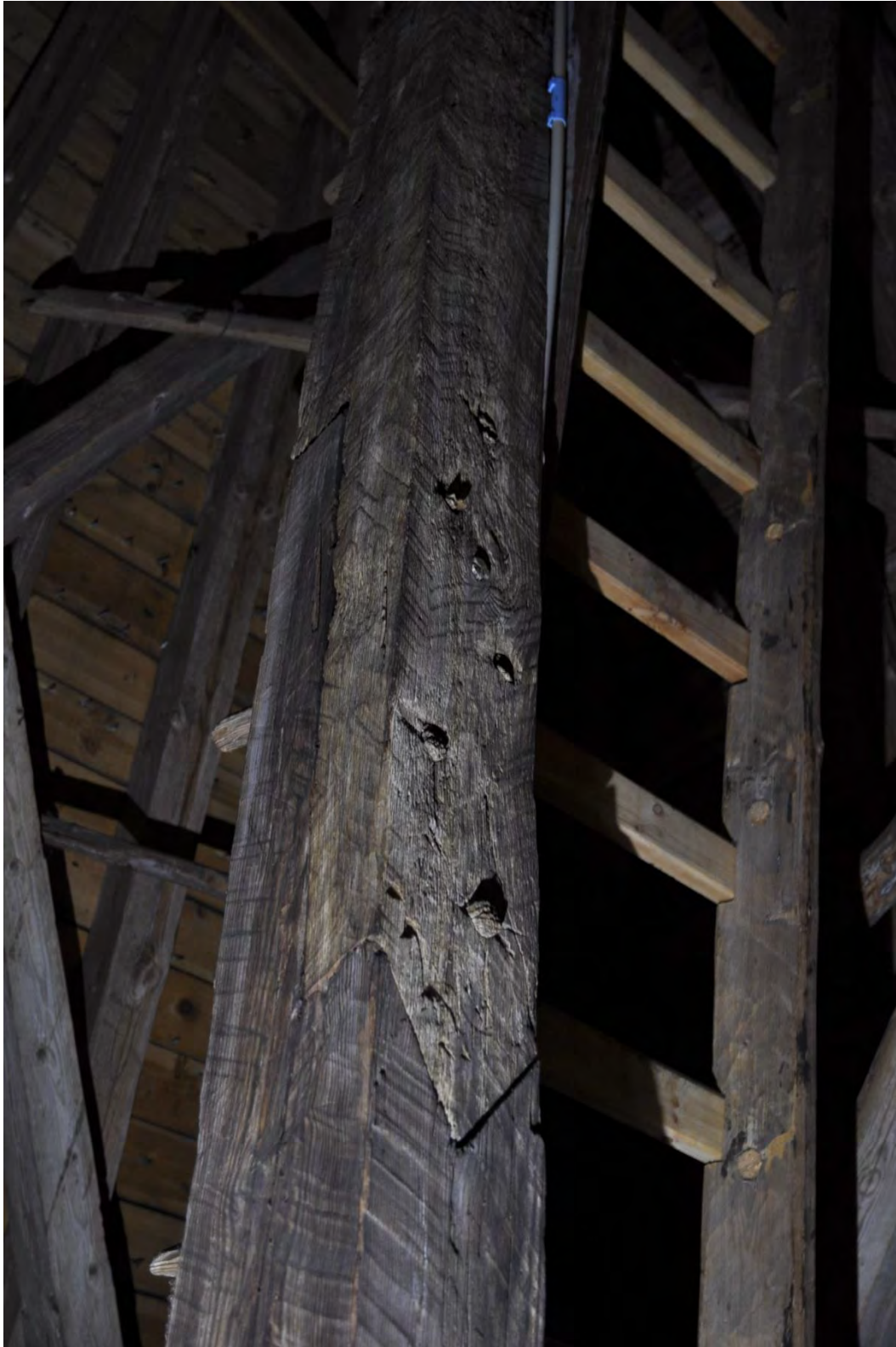
Hjärtstockens skarv är mycket välgjord och konstruktivt starkt utförd. Nedre halvan av furu, övre av ek.
