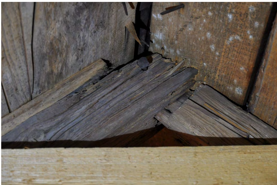
Högbenens sammanfogning i nock består av tapp och slits, fixerat med en spik. Vissa av takstolarna saknar dock låsande spik, högbenen vilar då endast mot varandra.
