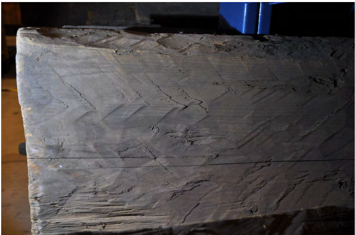
Undersidan är tydligt sprätthuggen, men kanske med mer inriktning på produktion än utseende. Notera även vankanten överst i bild.
