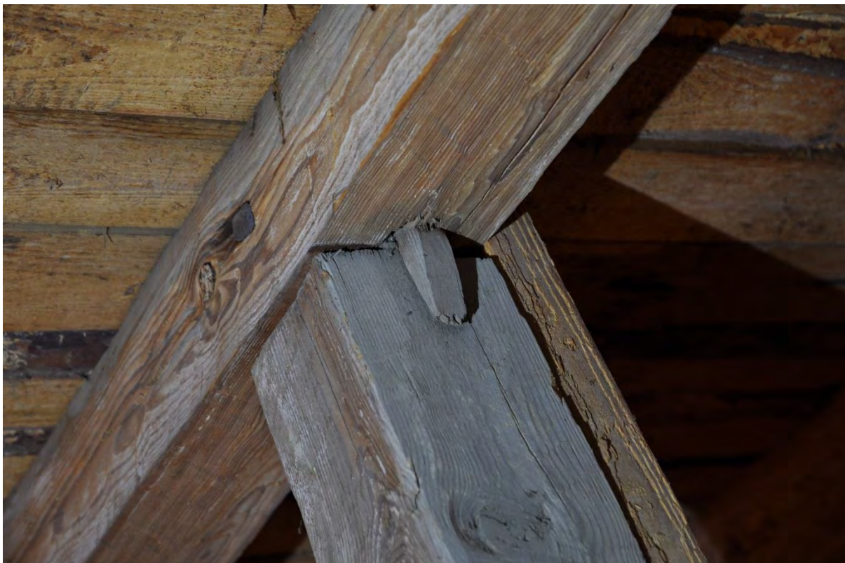
Knutpunkter mellan högben och stödben. På övre bilden syns tydligt att de består av tapp och tapphål. På nedre bilden exempel på en kil islagen från utsidan, för att fylla ut det för stora tapphållet. Kanske är tapphålerna med avsikt gjorda för stora, för att möjliggöra en enkel montering och ett mycket tätt förband.
