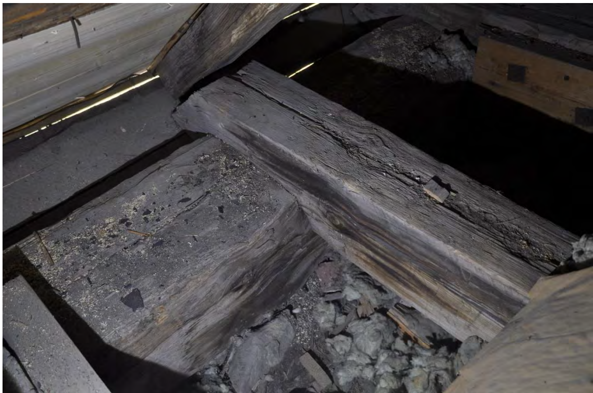
Fotot visar samma detalj som skissen ovan. Virket är bearbetat i sprätthuggningsteknik, men remstycket är något mer slarvigt bearbetat.
