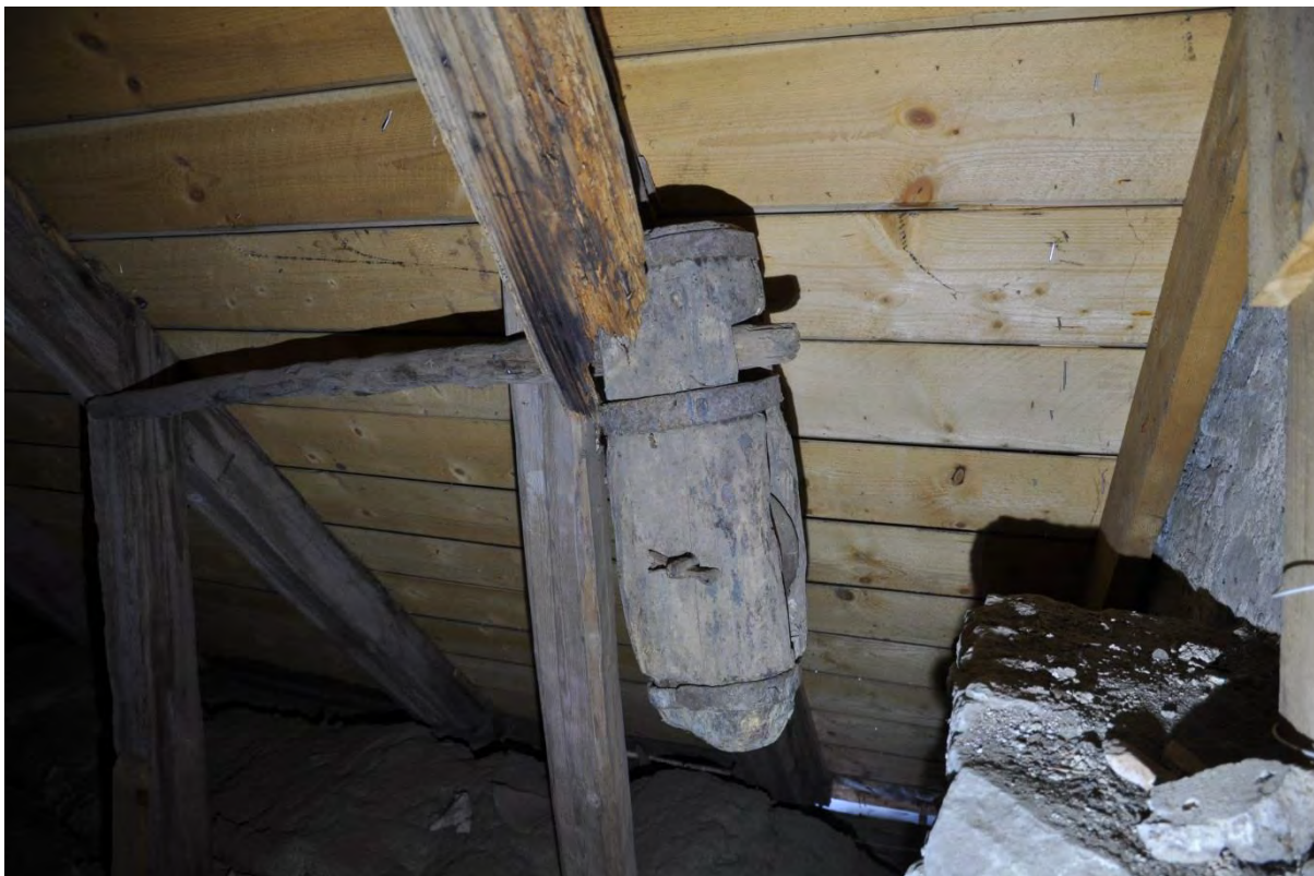
Ett gammalt block finns bevarat, med ett hjul av järn. Svårbedömd ålder.
