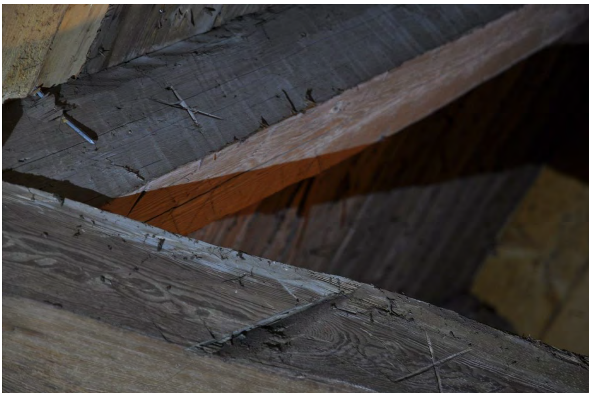
Exempel på timmermansmärkning i sakristian, "X".
