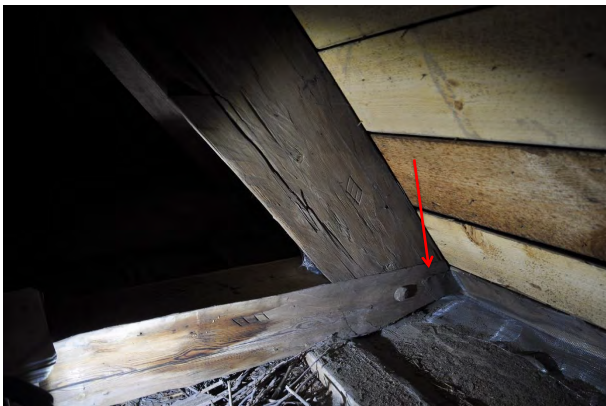
Undersidan av stickbjälkens avslut är uppvinklad. Sköllersta kyrka har alltså haft uppvinklade takfotsbrädor, vilket är vanligt förekommande på kyrkor från 1100-talet och 1200-talet. Lägg märke till timmermansmärkningarna på stickbjälken och högbenet.
