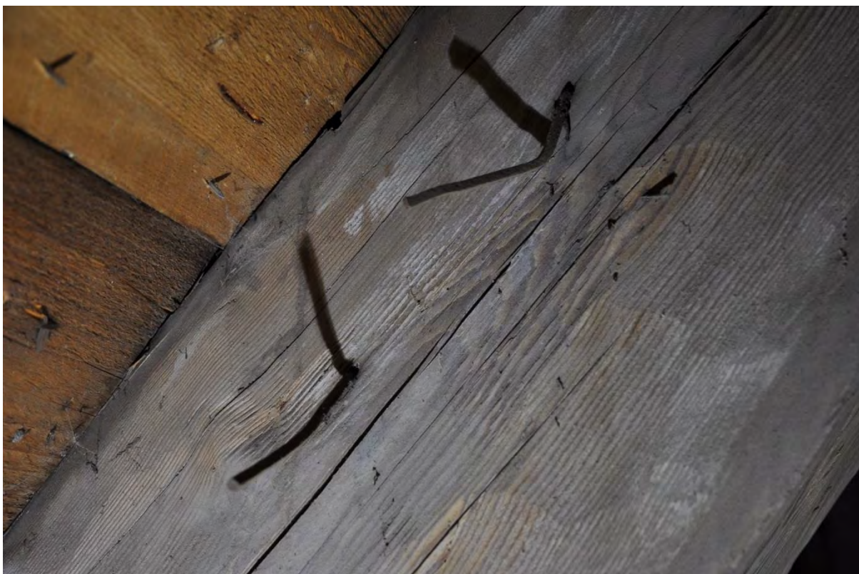
På några ställen sitter fyrkantsjärn utan skalle.
