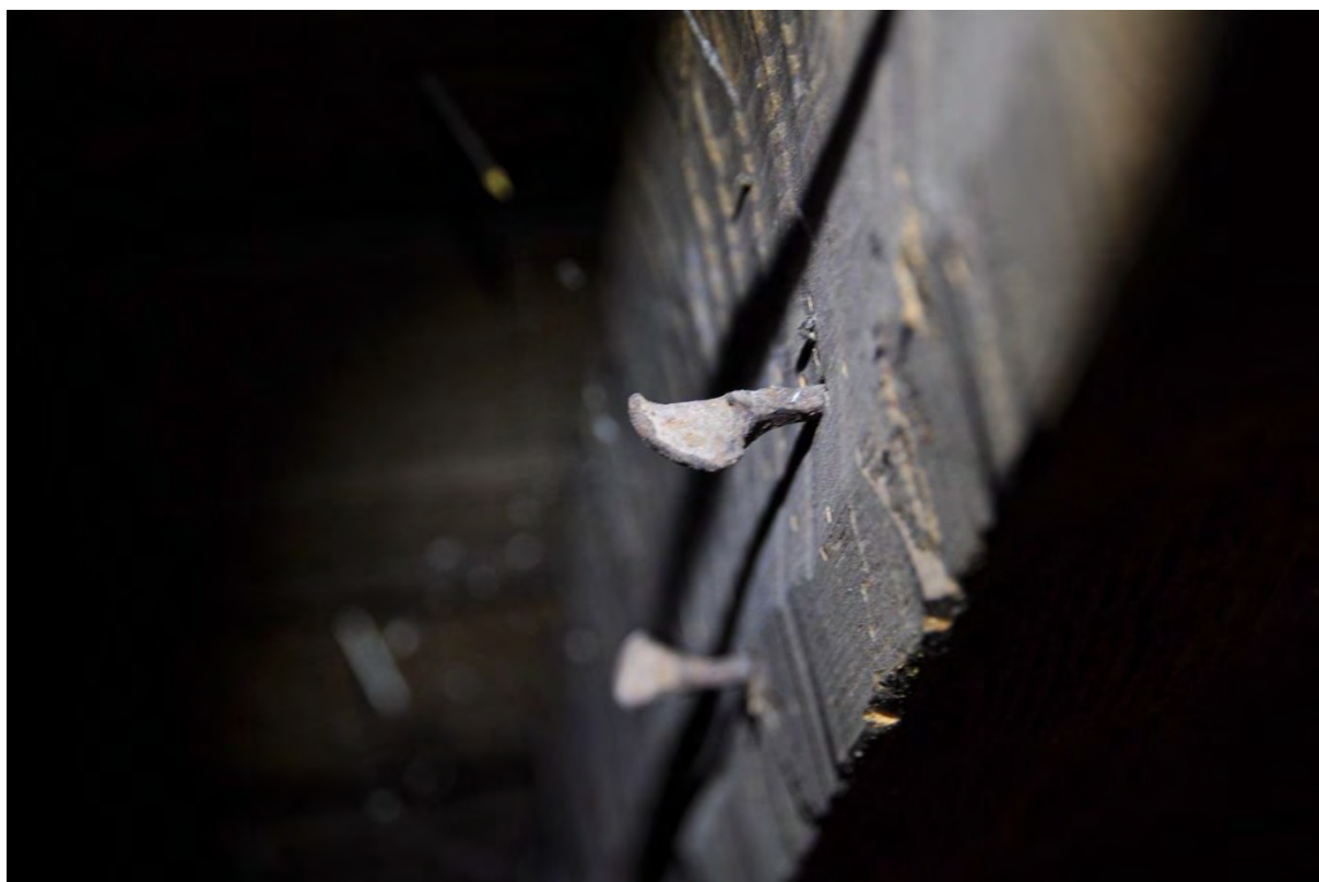
Hästkosöm i ett medeltida högben i Knista kyrka. Skallens form varierar mellan de olika sömmarna.
