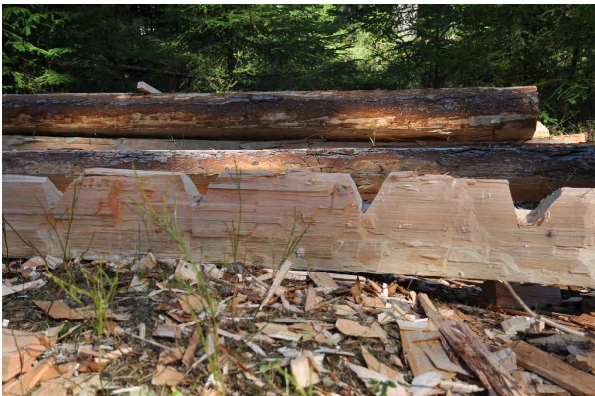
Vid grovhuggningen av åttondelsklovorna gjordes inhugg för att underlätta borthuggning av kärnveden.
