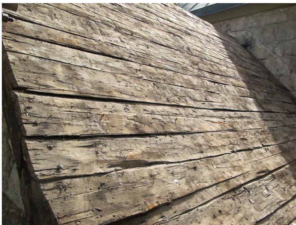
Undertaksbrädorna är ålderdomliga, och framställda genom klyvning och bearbetning med yxa. Troligen är de ursprungliga. Foto Anneli Borg, Ölm.
