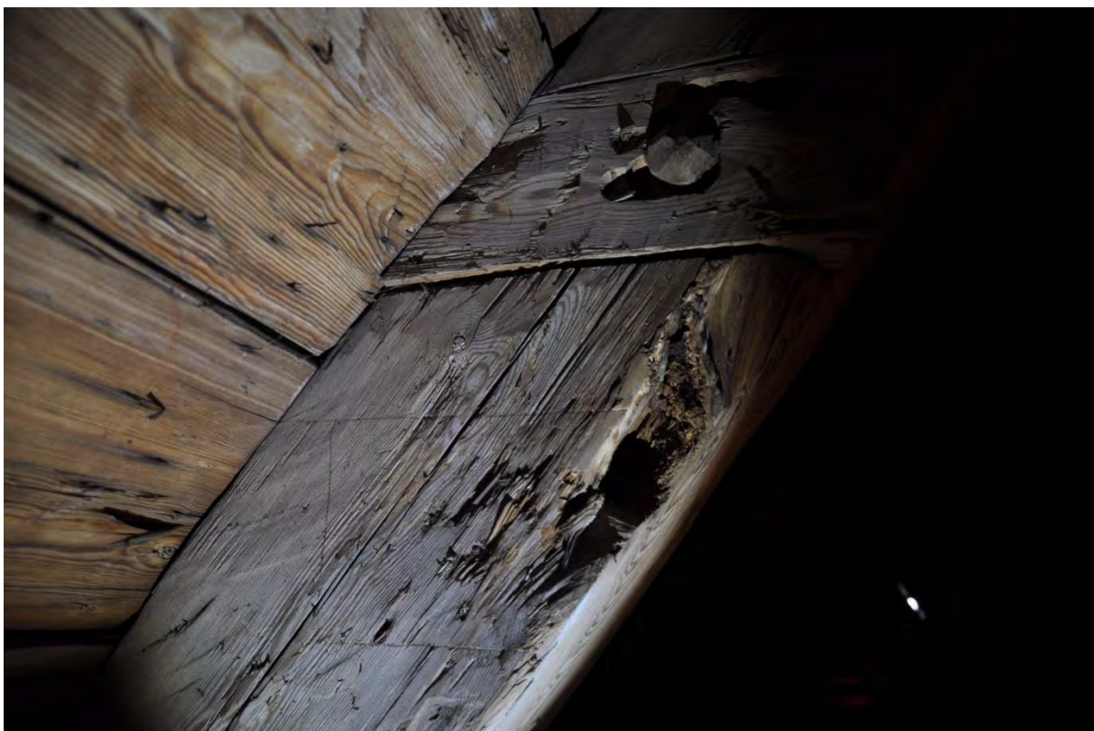
De flesta av knutpunkterna är utförda som raka genomgående blad, men några av dem är "husade". Bilden visar en genomgående knut, men strax under kan man se att timmermannen ritsat för att göra en "husad" knut.
