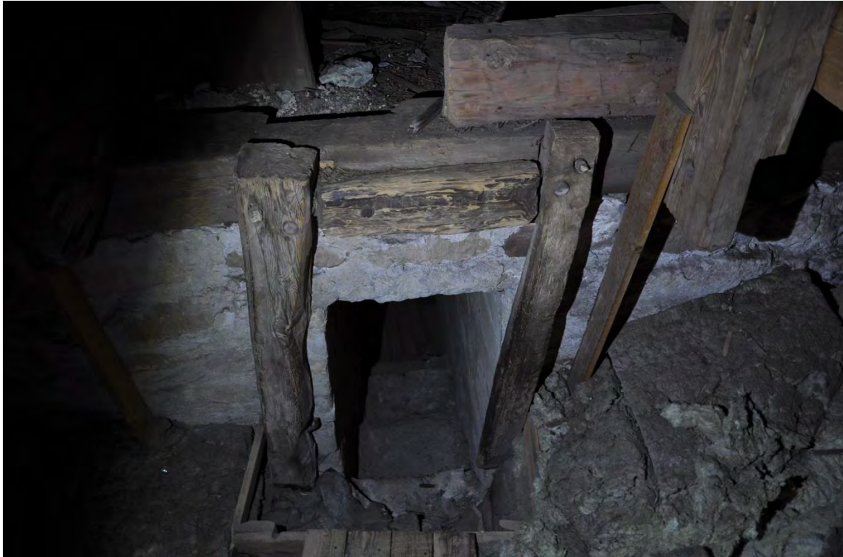
Dörromfattning där trappan mynnar på långhusvinden.
