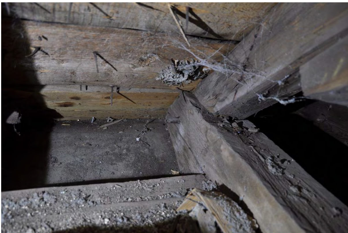
Knista kyrka har uppvinklade takfotsbrädor, vilket är vanligt på tidigmedeltida taklag. Notera också järndymlingen. Södra sidan.
