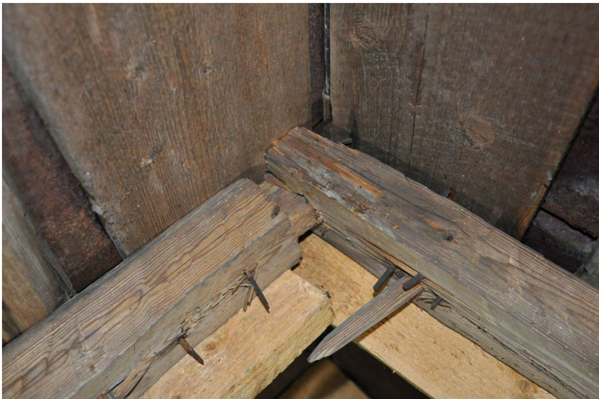
Högbenens sammanfogning i nock består av tapp och slits, utan låsande spik eller dymling.
