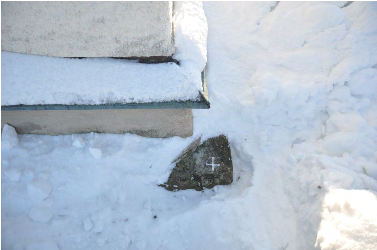
Korset i stenfoten vid tornets nordvästra hörn.
