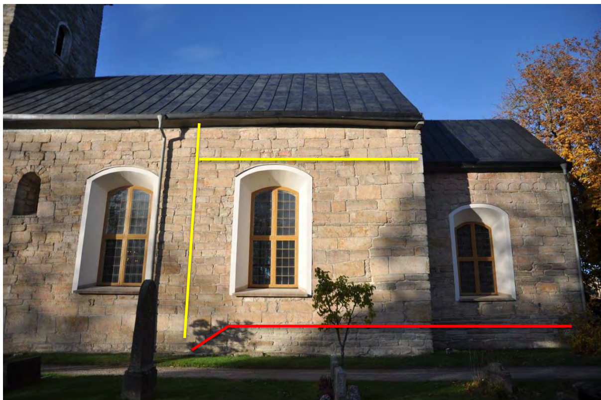
Under den röda linjen består murverket av kalksten. De gula linjerna visar avsatserna i murverket invändigt.
