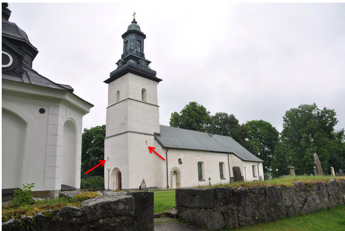
Tornvåningen har ett ursprungligt fönster i södra väggen. Även i östra väggen finns ett ursprungligt fönster, som är placerat i skalmurens trappa.
