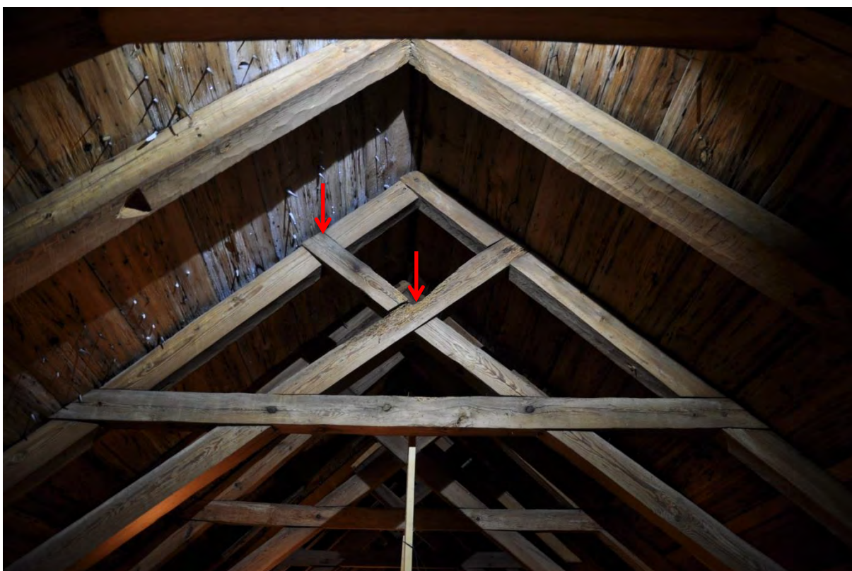
Takstolens övre del med högben, saxsparrar och en hanbjälke. Den högra saxsparren, som är den först monterade, saknar spik eller dymling i sina knutpunkter. Den vänstra saxsparren samt hanbjälken hindrar den från att falla ur.
