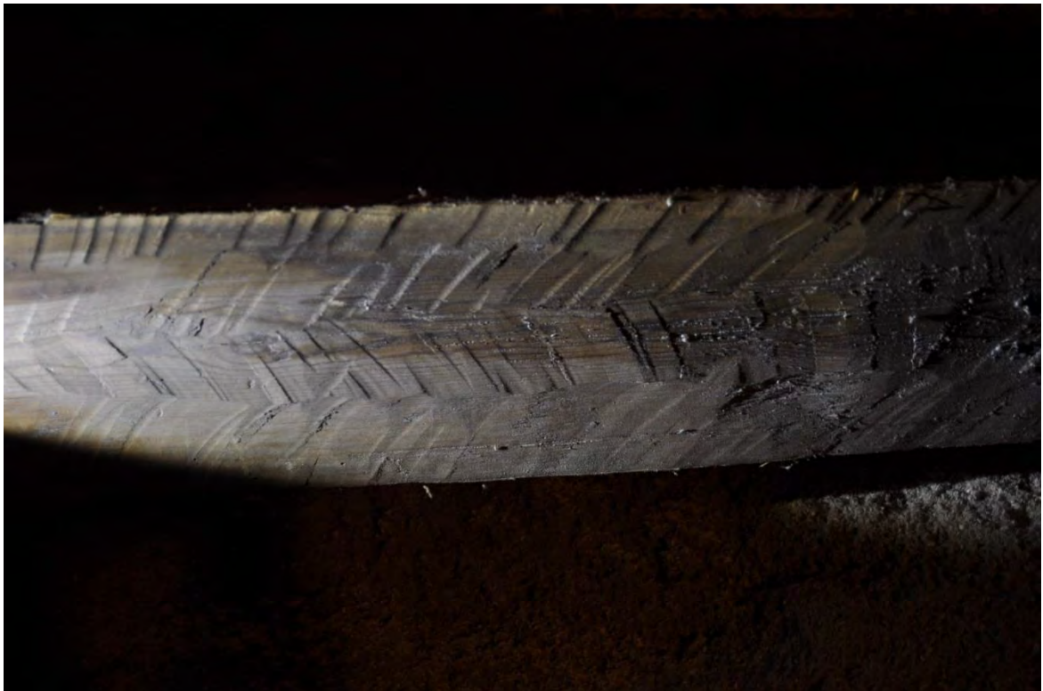
Jämför med behuggningen i Knista kyrka, på bilden. En tidigmedeltida utpräglad sprätthuggning där huggspåren går i markant bandformation i vedens längdriktning, ofta i fiskbensliknande mönster.
