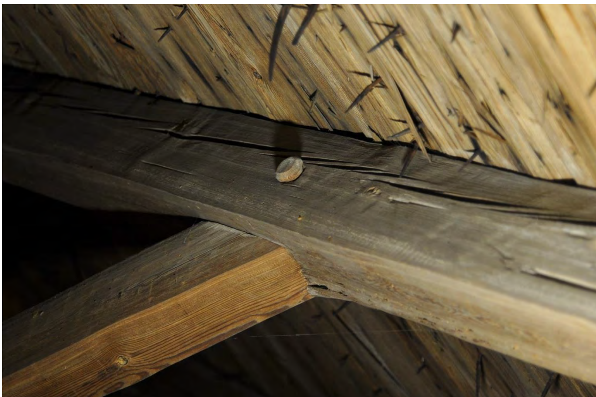
Bilden visar ett möte mellan hanbjälke och högben, och illustrerar på ett bra sätt den noggrannhet och omsorg som kännetecknar det tidigmedeltida hantverket. Delarna är bearbetade till skarpa hörn utan vankant. Ytorna är skavda (hyvlade), och dymlingen har en fint utformad skalle.
