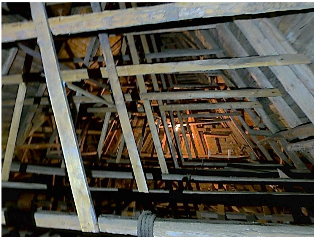
Taklagen över Sorunda kyrkas långhus blev sannolikt helt nybyggda efter brand 1689, med medeltida förlaga. Bildnummer LP_2015_00070. Foto Bengt Bygdén
