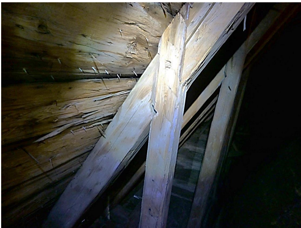
Grödinge kyrkas långhus har bitvis en taktro av kluvna och med yxa bearbetade bräder. Bildnummer LP_2015_00061. Foto Bengt Bygdén
