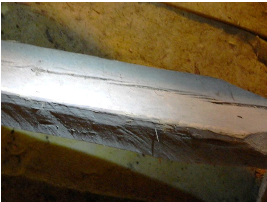
Sprätthuggen bindbjälke på Överjärna kyrkvind. Bildnummer LP_2015_00098. Foto Bengt Bygdén
