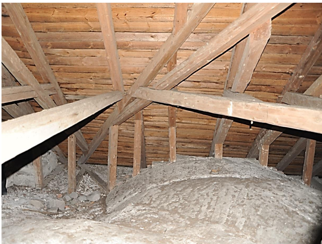
Översiktsbild av valvkupor och taklag i Ytterenbörna kyrka. Foto Rolf Hammarskiöld
