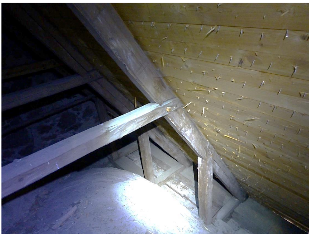
Bilden ovan visar takstolar i Grödinge kyrkas vapenhus, med dubbla remstycken, tass, stödben och hanbjälke. Bildnummer LP_2015_00059. Foto Bengt Bygdén
