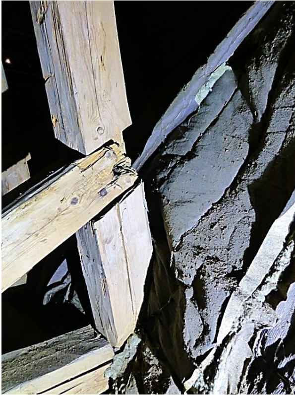
Bilden till vänster, från Salems kyrkvind, visar sträva som kapats vid stickhjälken, för att få plats för valvkupa. Bildnummer LP_2015_00075. Foto Bengt Bygdén
