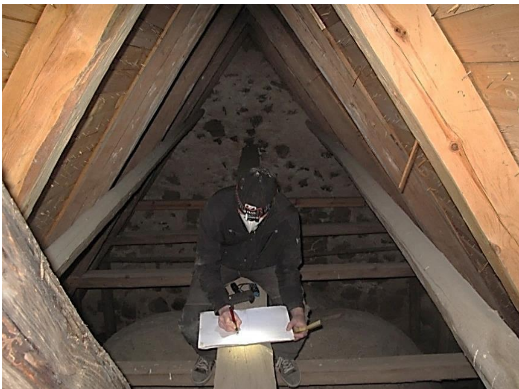
Bilden ovan visar taklag och gavelmur på Grödinge kyrkas vapenhus, samt Bengt Bygdén som dokumenterar. Bildnummer LP_2015_00062. Foto Hedvig Bellberg
