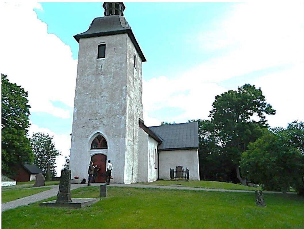
Då Ytterjärna kyrkas västra sida fotograferades 2013-06-25 hade fasadfärgen lakats ur. En yttre renovering genomfördes sommarhalvåret 2014. Bildnummer LP_2015_00094. Foto Bengt Bygdén 2013-06-25.
