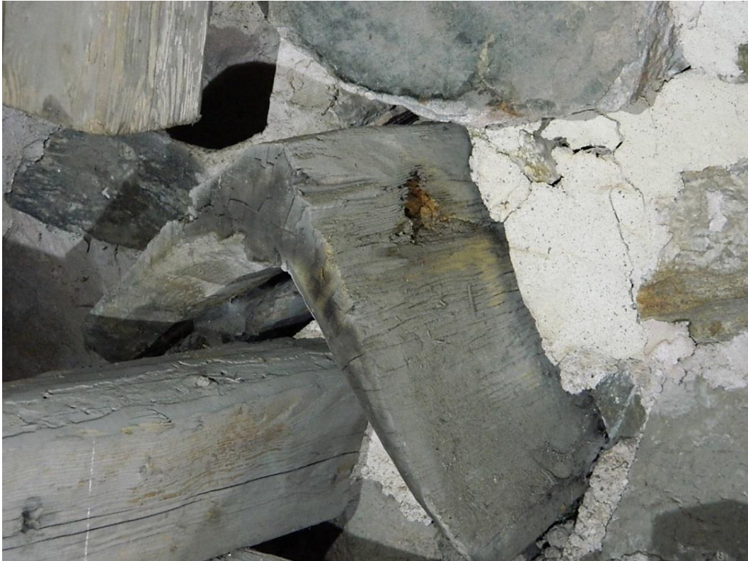
I Överjärna kyrkas tornmur finns nockhuv med trobräder "konserverade". Bildnummer LP_2015_00097. Foto Bengt Bygdén
