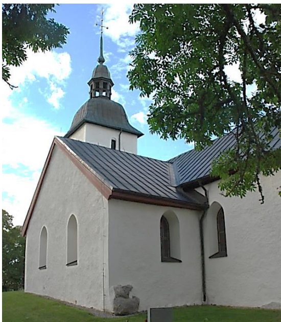
Ytterjärna kyrkas södra sida, med den så kallade Dåderökyrkan i förgrunden.
