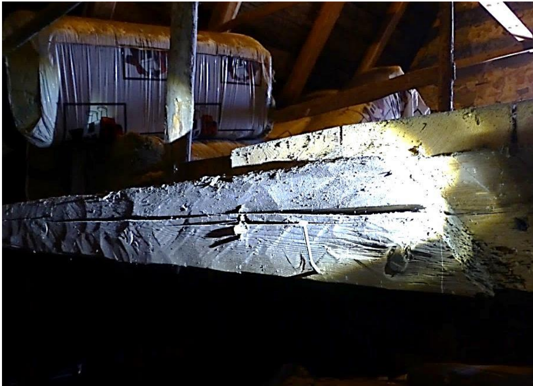
I sakristians vind på Ösmo kyrka finns ett medeltida böghen, med sprätthuggen yta, återanvänt som hanbjälke. Inbuggningar visar att nuvarande taklag, troligen från 1600-talet, tillverkades med föregående som förlaga. Bildnummer LP_2015_00072. Foto Bengt Bygdén
