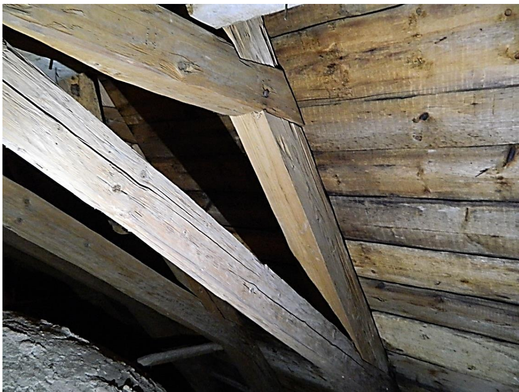
Bilden ovan visar vinden över Överenhörna kyrkas långhus, knutpunkter i södra taklaget. Taktrön består av ramsågade bräder. Bildnummer LP_2015_00091. Foto Bengt Bygdén
