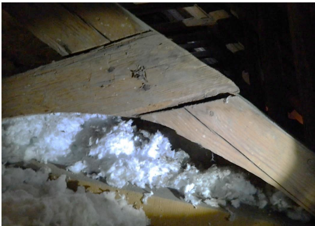
På Turinge kyrkas inre taklag går att avläsa formen av ett tidigare befintligt treklövervalv. Bildnummer LP_2015_00065. Foto Bengt Bygdén
