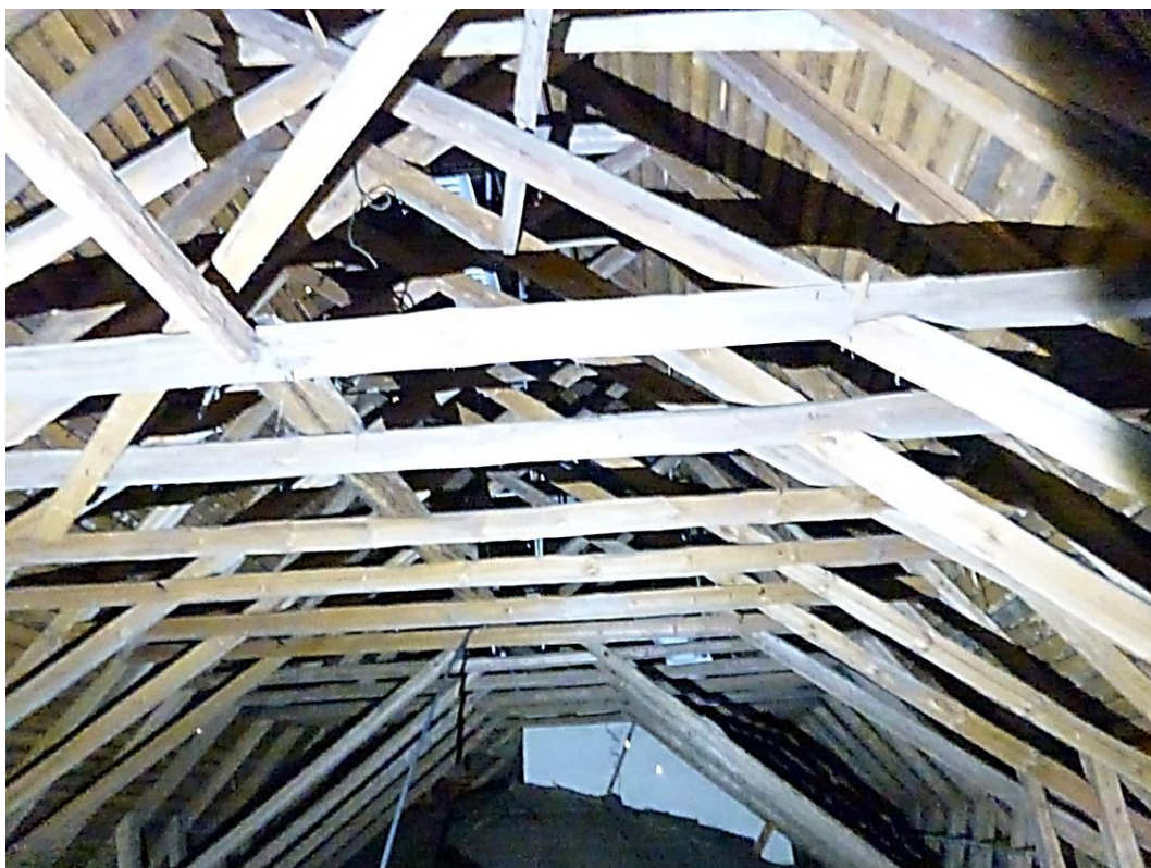
Ovanstående bild av Salems kyrkvind visar takstolar med strävor från 1600-talet. Bortom dessa följer ett senmedeltida taklag. Strävorna går ned mot högben respektive stickbjälke. Bildnummer LP_2015_00079. Foto Bengt Bygdén
