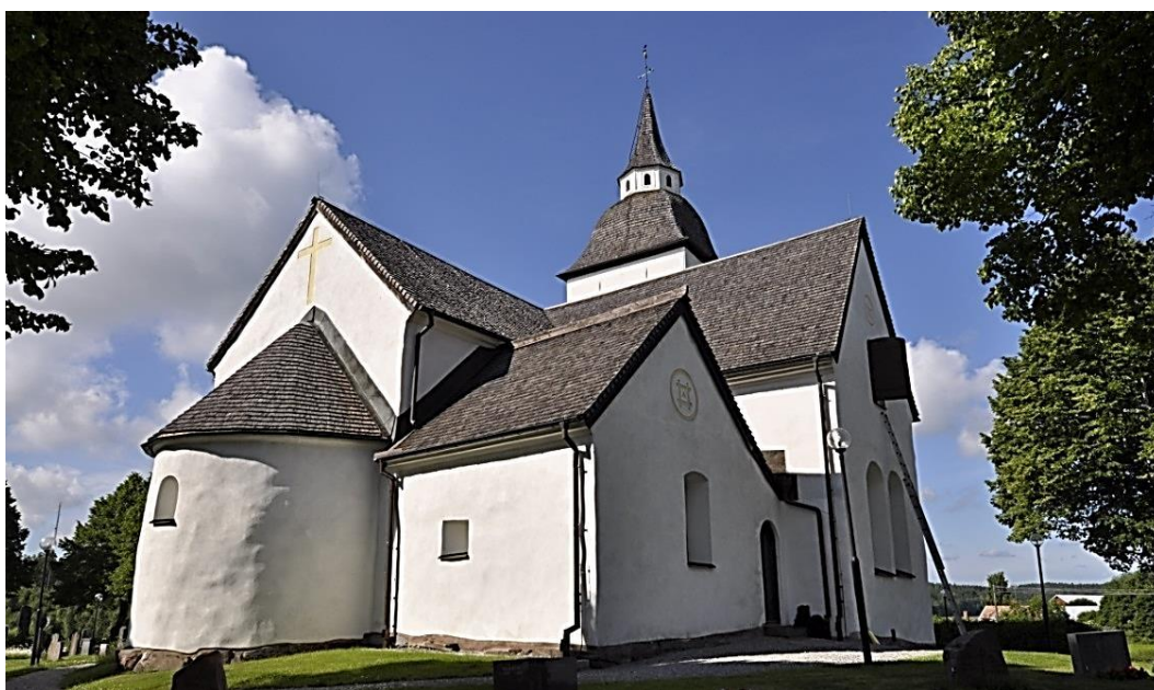
Ytterenhörna kyrkas östra sida. Senaste fasadrenoveringen skedde 1994. Bildnummer LP_2015_00089. Foto Albin Uller
