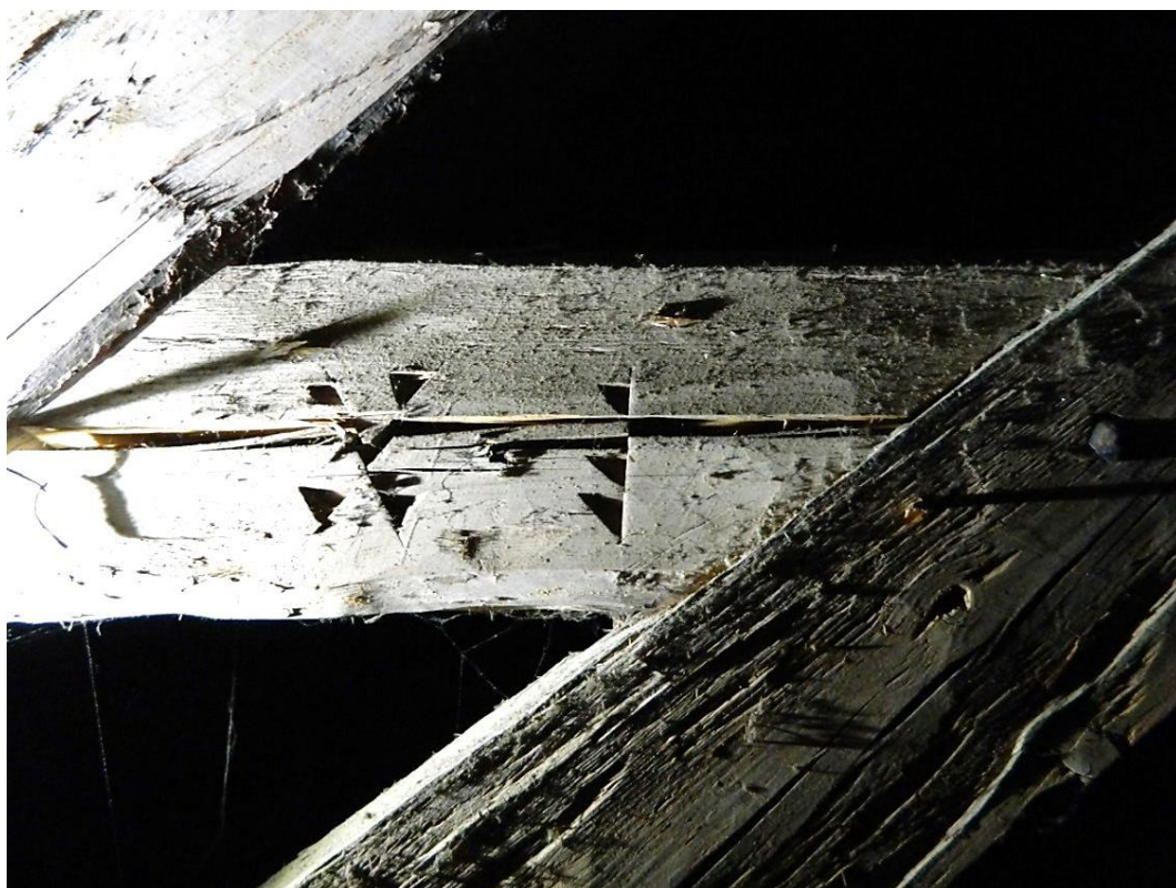
På Ytterenbörna kyrkas taklag förekommer timmermansmärkning och tvärsbilat virke. Bildnummer LP_2015_00090. Foto Bengt Bygdén
