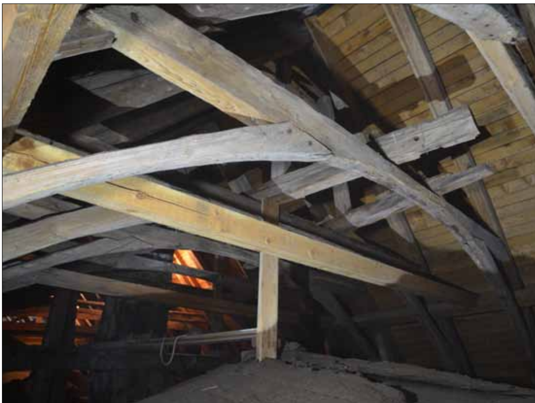
Tunnvalvstakstolen sedd mot öster (SLM D2015-1492).
