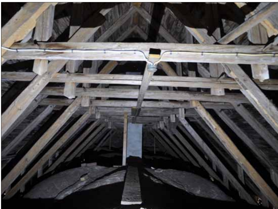
De övre stödbenen går förbi hanbjälkarna och är ändkapade med yxa på ett liknande sätt som de nedre stödbenen (SLM D2015-1518). Foto: Daniel Eriksson.
