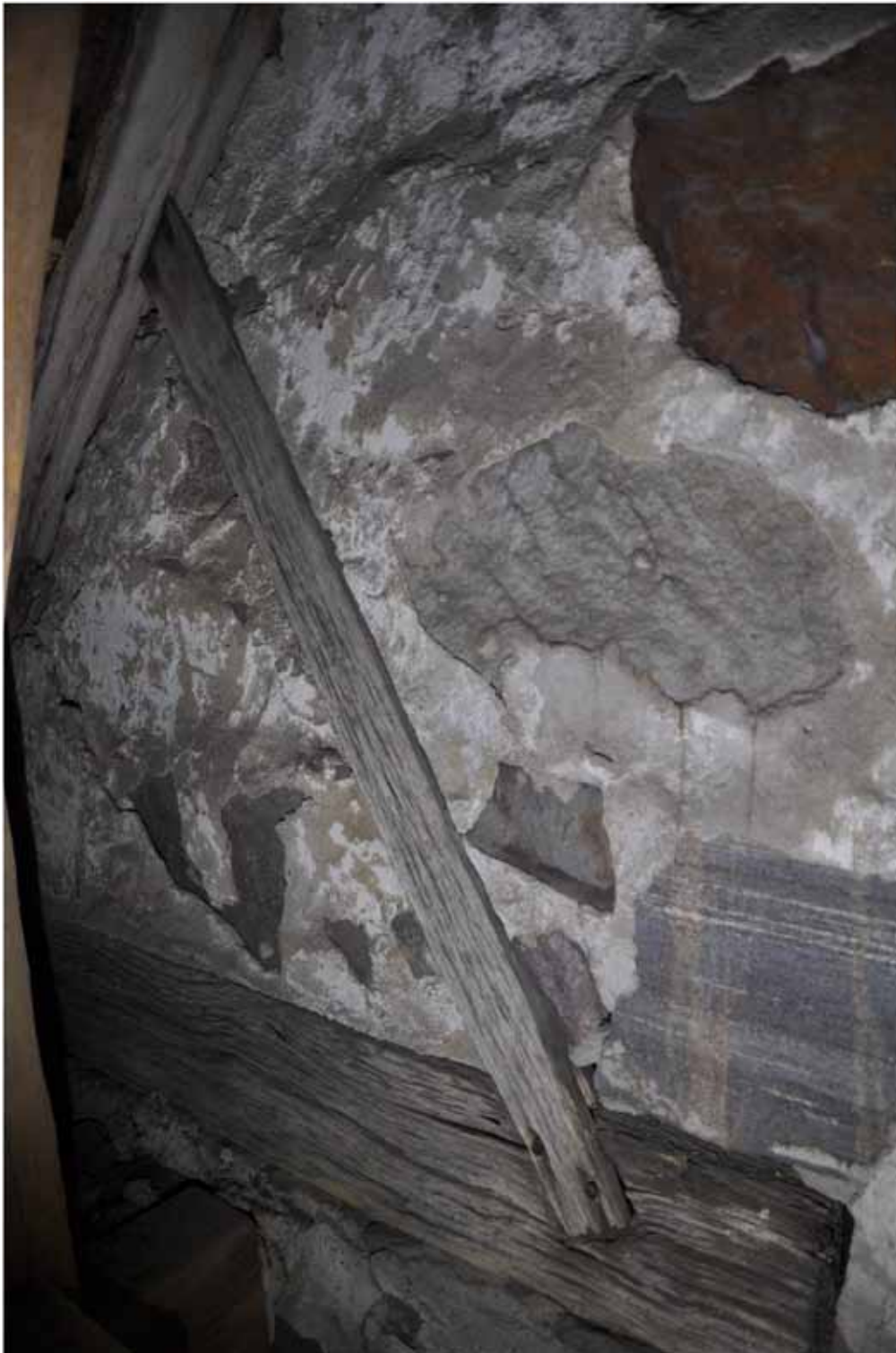
Stödbenen sitter förankrade med spik i båda ändar. Stickbjälkar och stödben är i ek, medan takutsprängsbrädan troligen är i furu. Stickbjälken sitter i sin inre ände förankrad i innanförliggande bindbjälke genom en bjälke som löper tvärs genom muren. Fotografi: Daniel Eriksson
