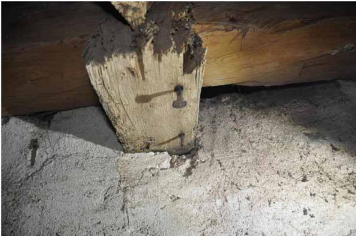
Undersidan av en kapad bindbjälke med spikar kvar från det platta innertaket. Putsen går ända upp till murkrönet. Ovanför ligger ett sekundärt remstycke som hör till det nya taklaget. Fotografi: Daniel Eriksson
