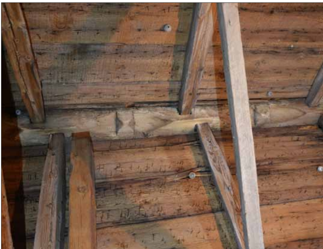
Över långhuset och koret står 22 takstolar. De första 11 takstolarna från väster är romanska med sprätthuggna högben som är infällda i en profilhuggennockås (SLM D2015-1427).
