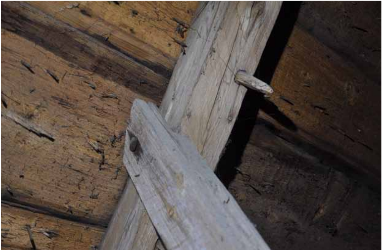
Stödbenen har ett blad, men är sedan spikade utanpå högbenen. Detta är troligen ovanligt för ett romanskt taklag. Den genomsnittliga dimensionen på stödbenen är B: 63mm, H: 80mm. Fotografi: Daniel Eriksson
