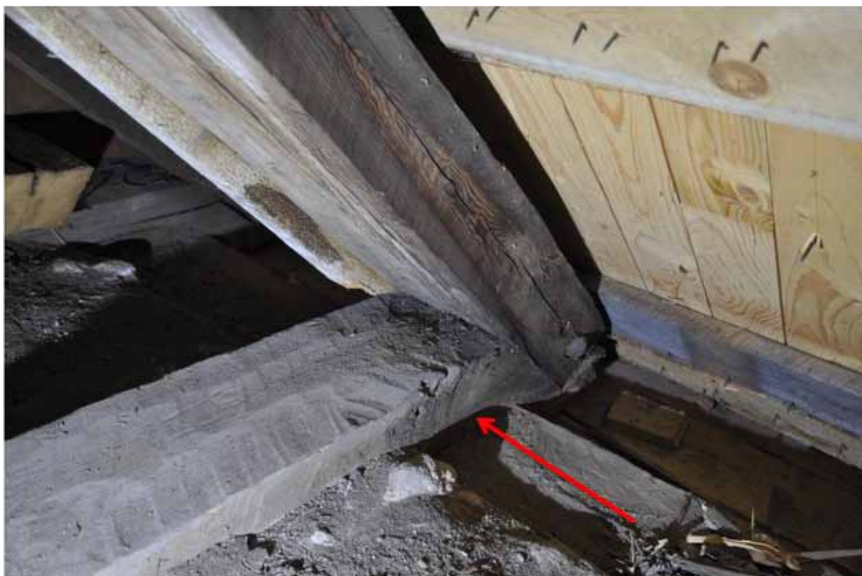
Det är förhållandevis rejäla högben. Detta mäter ca 130x130mm, ett annat B:155mm, H:120mm, vilket betyder att virket är lagt på fel håll, d.v.s. "på flasken". Bindbjälkarnas sidor är "halsade" för att passa ned i remstyckets hak. Fotografier: Daniel Eriksson
