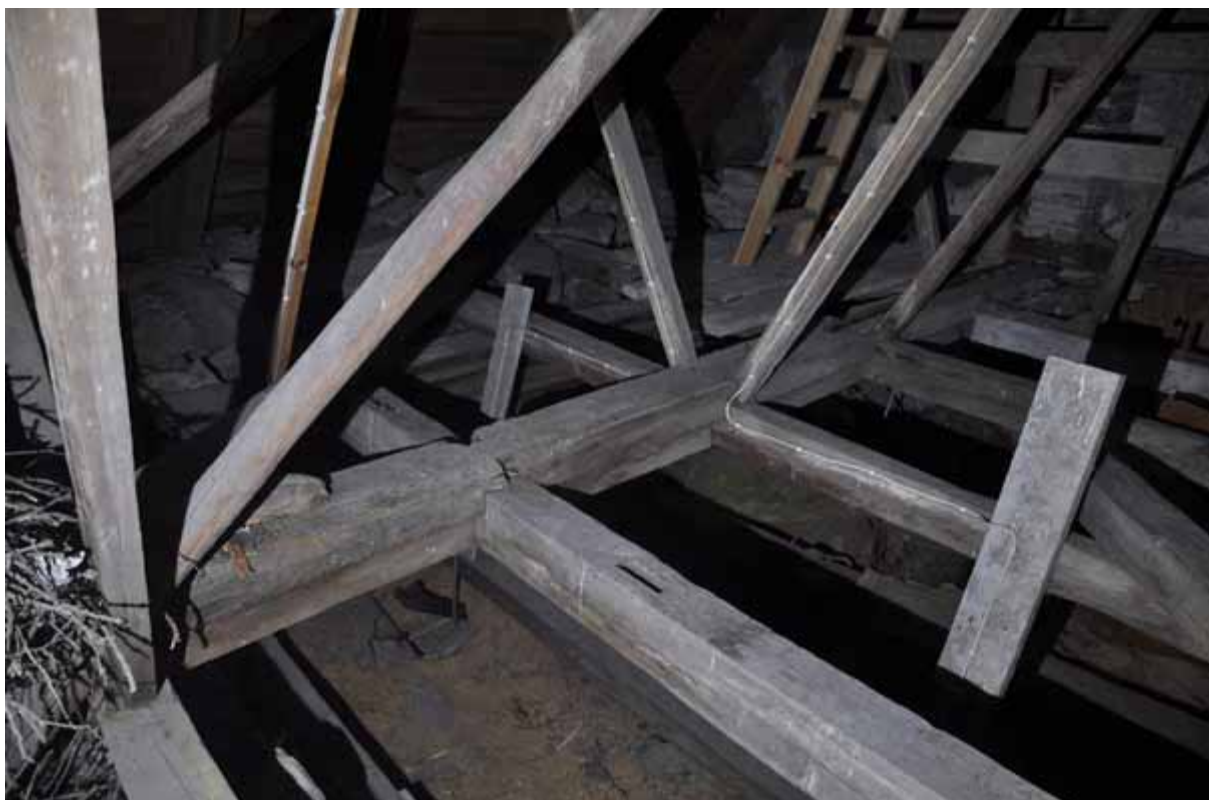
Takstolarna över tornet har ett par snedställda stödben som ej korsar varandra. Denna konstruktion tror jag brukar räknas till de allra äldsta (kolla upp). Vissa stödben består av helstock medan några är av kluvet virke (halvklovor), vilket inte är helt ovanligt i äldre romanska taklag. Nr 5 är den enda kompletta takstolen, även om ett av stödbenen flyttats något. Fotografi: Daniel Eriksson
