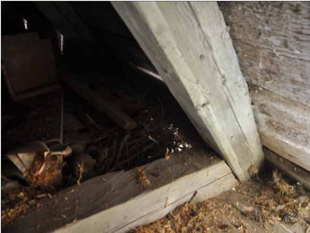
Tass/högben sammanfogade med bladning halvt-i-halvt och dymling (SLM D2015-1369). Fotografi: Daniel Eriksson.
