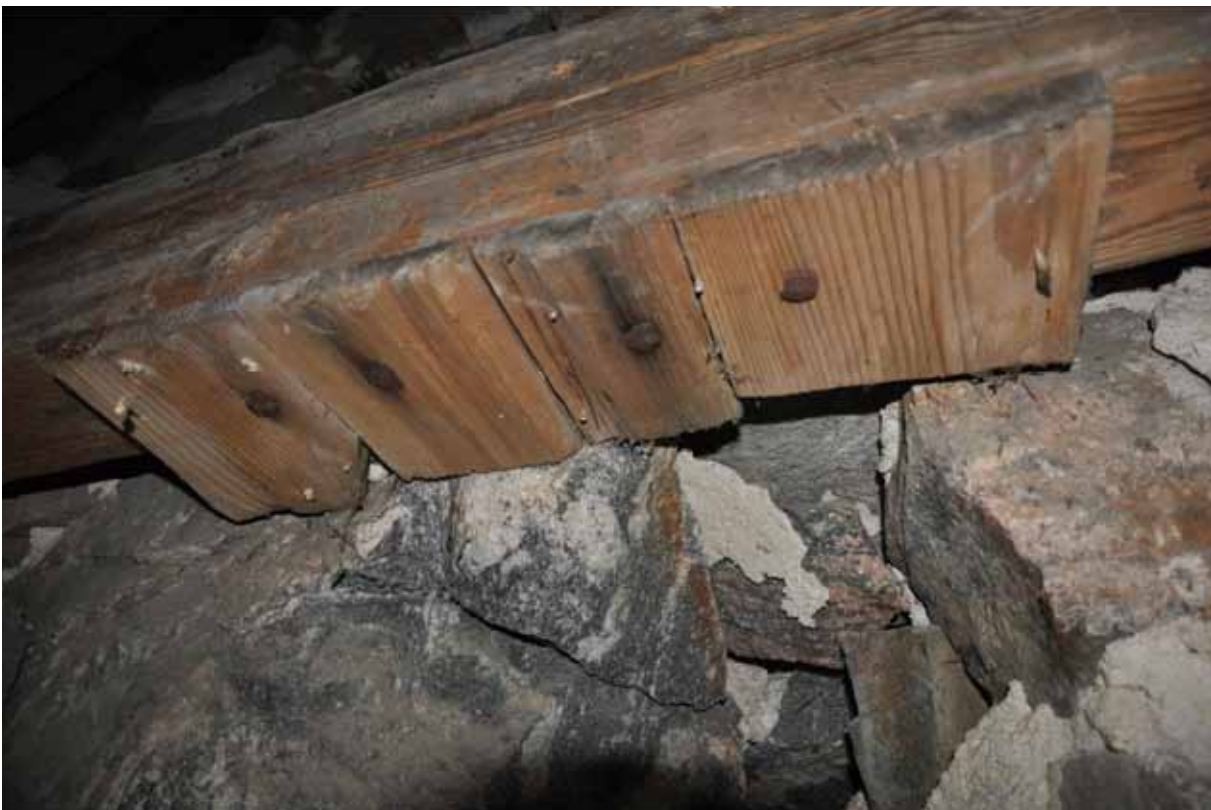
Västra bindbjälken är ej kapad för valven. Där finns rester av ett platt innertak som sitter med kärnsidan ned. De stöter bara mot varann sidledes, utan spont eller fasning. Fotografier: Daniel Eriksson
