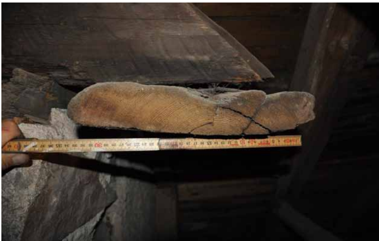
Takfotsbrädan håller förhållandevis grova dimensioner, 350x60mm, och är gjord i furu. I detta fall finns ingen fals i remstycket som inre upplag för brädan. Fotografi: Daniel Eriksson
