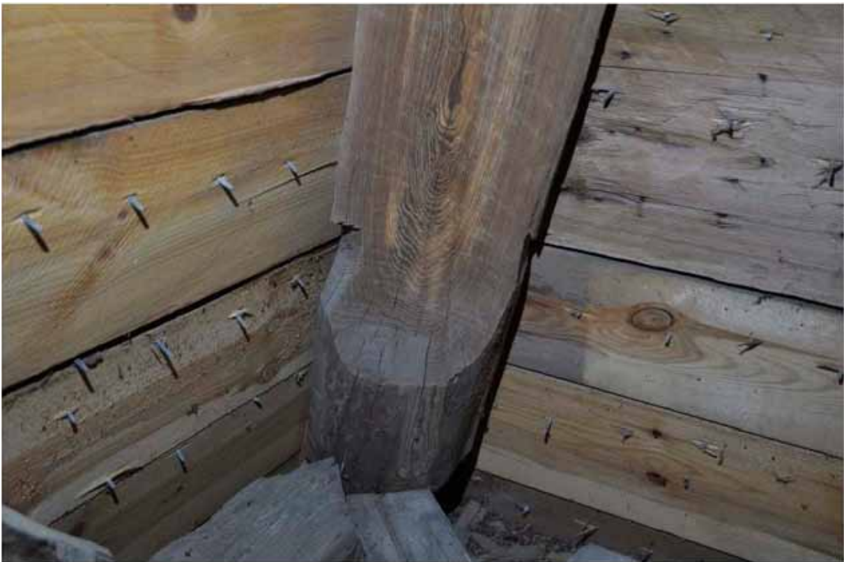
Hörnens högben är huggna trekantiga, även de med en svulst nedtill. Observera jacken i vardera kanten, kanske för att förhindra ett rep att glida vid resningen. Det finns mycket vankant på högbenen, lämpligt för dendro. Fotografi: Daniel Eriksson
