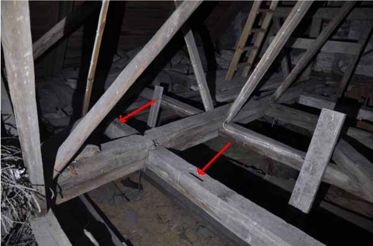
Bindbjälkarna mäter ca B: 145mm, H: 150mm. De saknar spikhål för platt innertak på undersidan. De saknar vankant, utom möjligen bindbjälke nr 4. Bindbjälke nr 2 och 6 har rektangulära tapphål som syns på bilden. Dess funktion är oklar. Samtliga bindbjälkar finns kvar, men en bit av nr 6 är bortkapad och ligger löst på vinden. Fotografier: Daniel Eriksson
