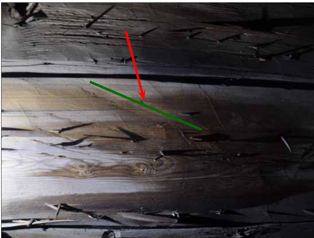
Taktrö med spår av samma behuggningsteknik men spegelvänt. Taktrö är med största sannolikhet samtida med taklaget. Det har alltså varit en vänster-och en högerhänt timmerman med samma typ av yxa eller en dubbelhänt timmerman (SLM D2015-1522). Foto: Daniel Eriksson.
