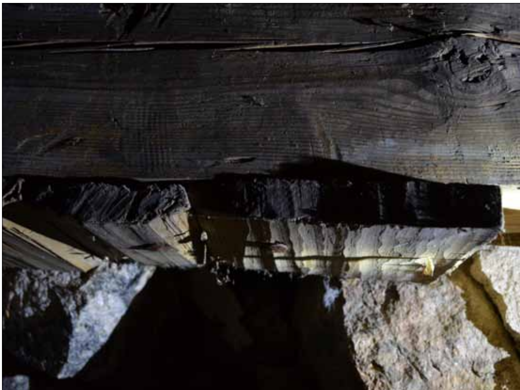
På takstolen längst i väster är större delen av bindbjälken kvar och på dess undersida finns det fortfarande kvar små rester av ett äldre platt innertak. Takbrädornas synliga yta är bearbetad med skave (SLM D2015-1447).
