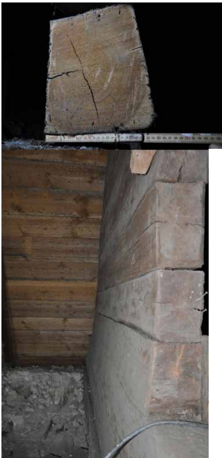
Röstet är trapetsformat, men bara på ena sidan. Östra sidan är lodrät, västra sidan lutar. Röstet är alltså bredast i basen (i tvärsnittet) och smalnar av uppåt. Fotografi: Daniel Eriksson
