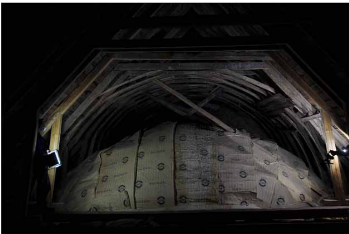
Valvet är asymmetriskt med en förskjutning åt norr. Kan det bero på att långhusets förlängda del har en förskjutning åt norr, nere i kyrkorummet? Fotografi: Daniel Eriksson
