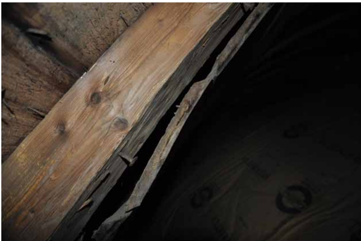
Trätunnvalvets brädor är 15-20mm tjocka och ca 560 cm långa som längst. De är fästa med spik och sitter konsekvent med kärnsidan uppåt. De verkar aldrig varit bemålade. Fotografi: Daniel Eriksson
