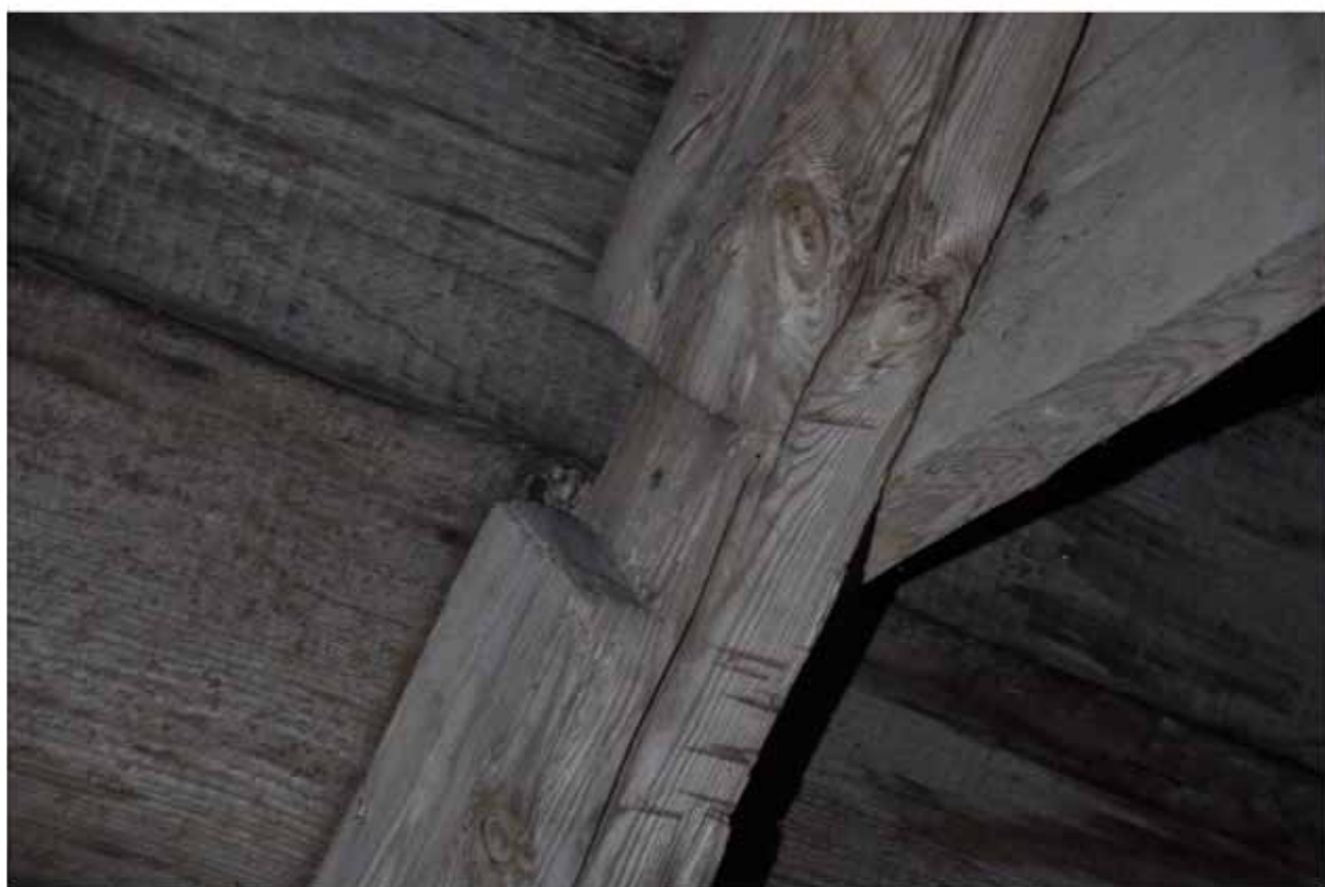
Knutpunkten stödben/högben har varit utformade som bladningar med spik. Ett högben har en husad knut (överst), medan de andra har genomgående bladningar. Flera stödben finns återanvända. Den genomsnittliga dimensionen på dessa är B: 88mm, H: 93mm. Fotografi: Daniel Eriksson
