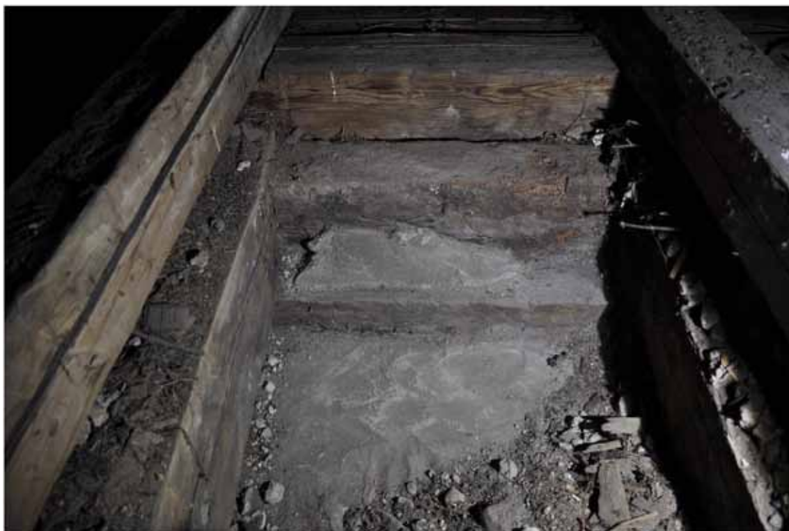
Murkrönets ovansida är mycket fint putsat mellan bindbjälkarna. Dessutom verkar man ha putsat en snedfasning i remstyckets inre fals! Detta bör vara högst ovanligt. Fotografi: Daniel Eriksson
