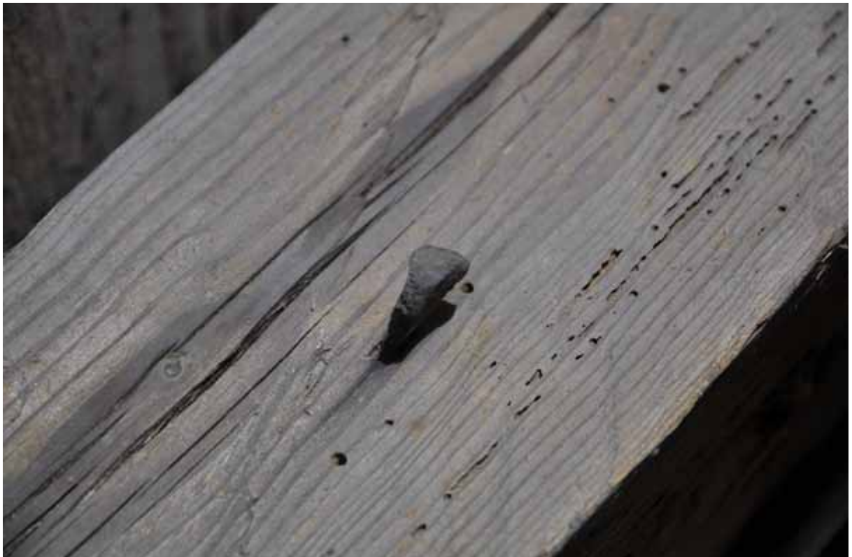
På norra högbenet i takstol 2 sitter en spik som har mycket speciell form. En likande typ av spik finns i ganska stort antal i taklaget på Knista kyrka, Örebro län, dendrodaterad till ca 1123. Om de inte har tillkommit i samband med resningen av taklaget så är det ändå möjligt att de spikats dit under den romanska tiden. Fotografier: Daniel Eriksson
