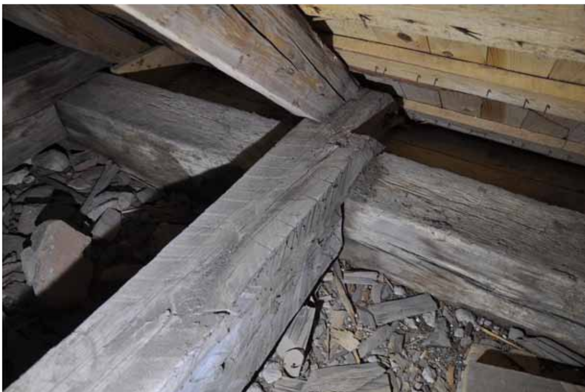
Här en bild från koret där märkning finns på bindbjälkens ovansida. Nummer 7. Fotografi: Daniel Eriksson
