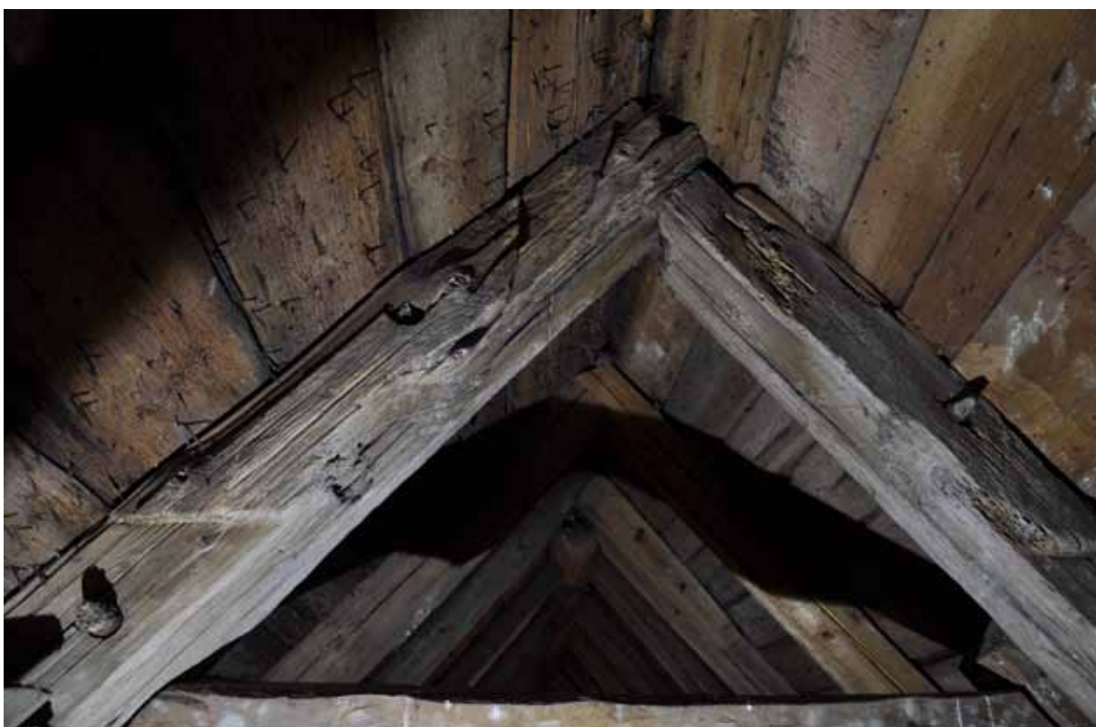
Östra takstolen sedd från öster, alltså "utifrån". I de båda nedre hörnen på bilden ser man urtag för hanbjälke. Strax ovanför, rundade urtag i kanterna, sedan en dymling/dymlingshål i vardera högbenet. Det finns fyra sådana dymlingar i varje högben, jämnt fördelade över hela längden (troligen i alla fall, det ena högbenet är kapat). Uppe i nock syns ett grunt vertikalt urtag. Se skiss nedan. Fotografi: Daniel Eriksson
