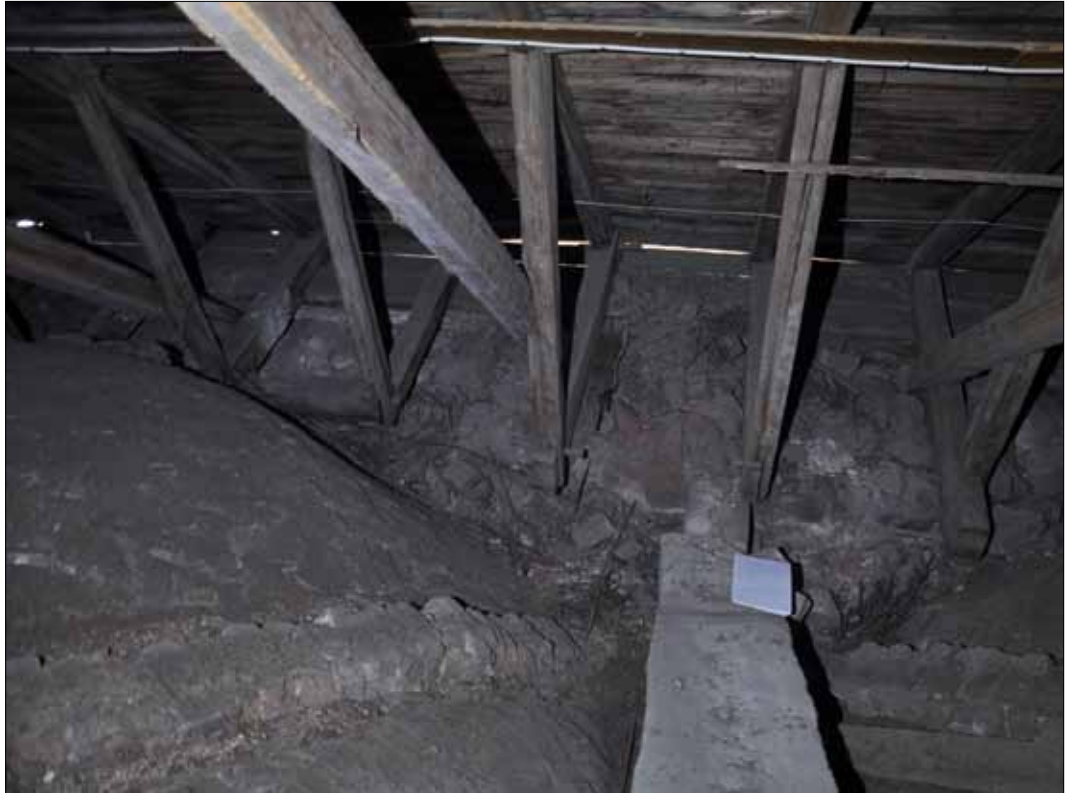
I murverket mellan takstol nr 11 och 12 syns tydligt skarven som uppstod då kyrkan förlängdes österut på 1300-talet. Den nyare muren är betydligt tjockare än den äldre. På murkrönen ligger en hel del byggskräp och annat som kan ge mycket information om byggprocesser och andra företeelser. Detta kan lätt försvinna vid städning. (SLM D2015-1523). Foto: Daniel Eriksson.
