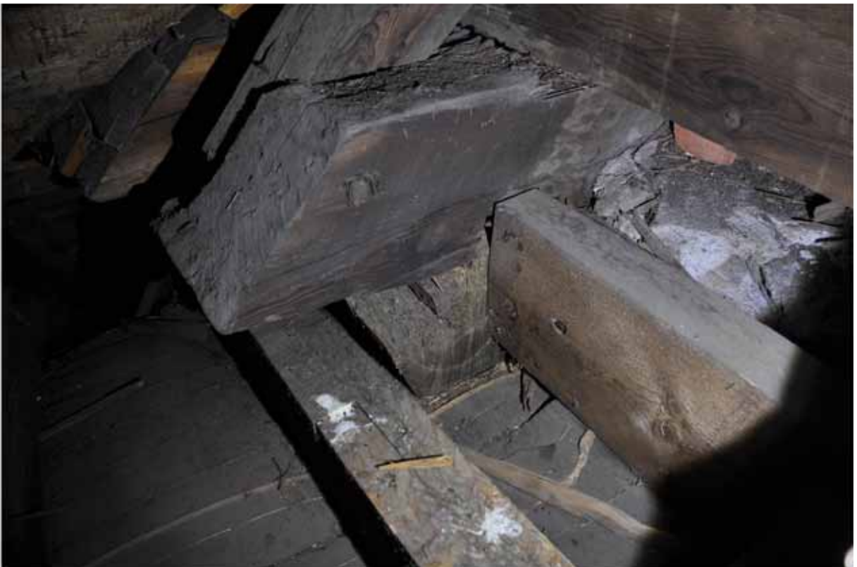
Här syns remstycket i ek med en fals för takfotsbrädan. Den sidan av remstycket som varit synlig utåt har en lutande sida. Fotografier: Daniel Eriksson
