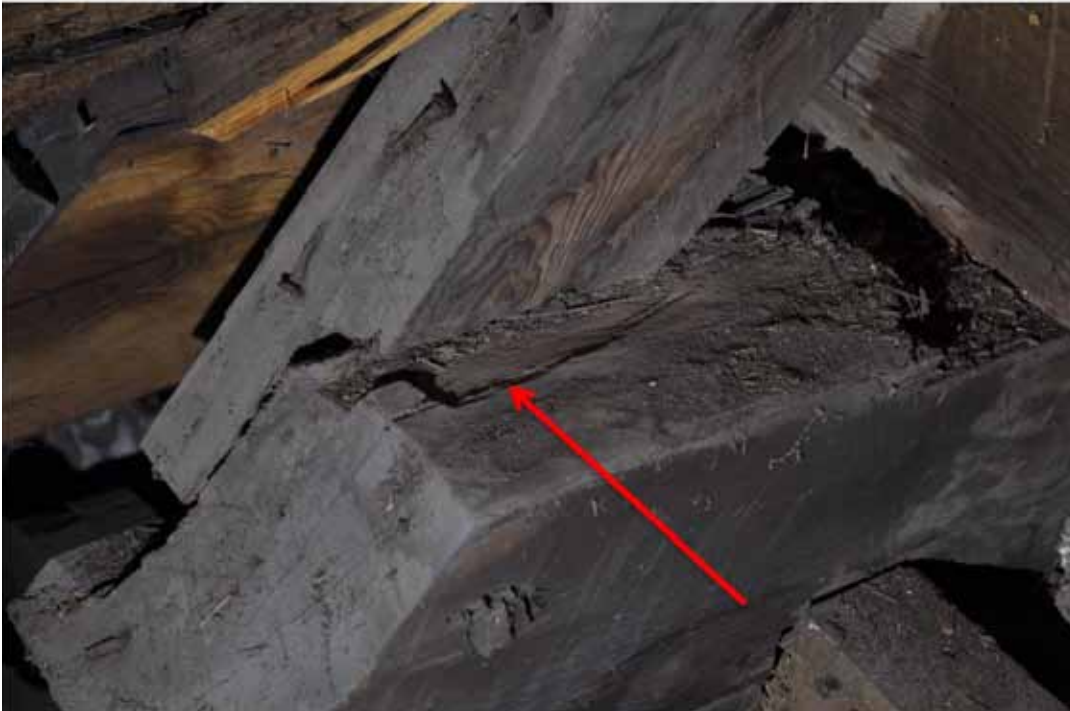
Man har huggit en fördjupning i bindbjälken där högbenet stöter emot. Troligen en justering som gjorts på plats i samband med att takstolarna rests.
