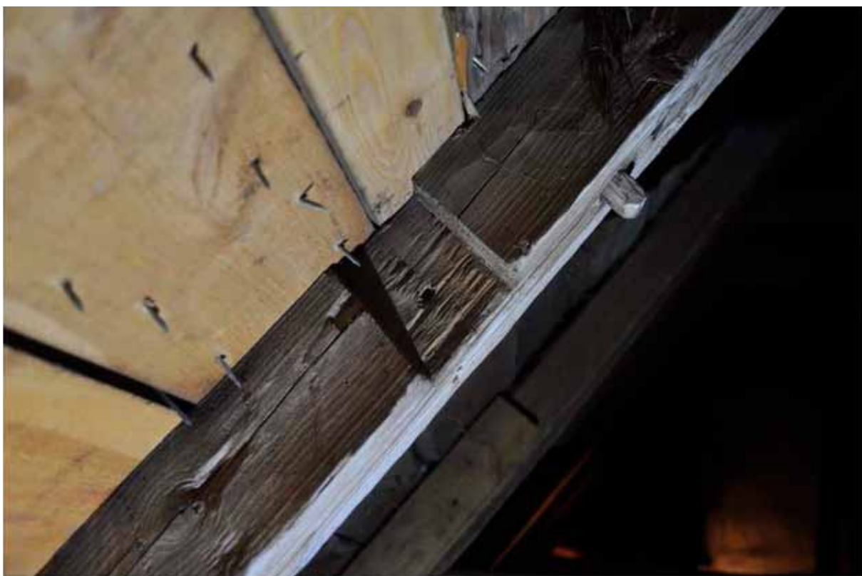
Högbenens urtag för stödbenen är ej husade. Stödbenen har varit fästa med spik. Högbenens möte inock är utförd som bladning med dymling. Fotografi: Daniel Eriksson
