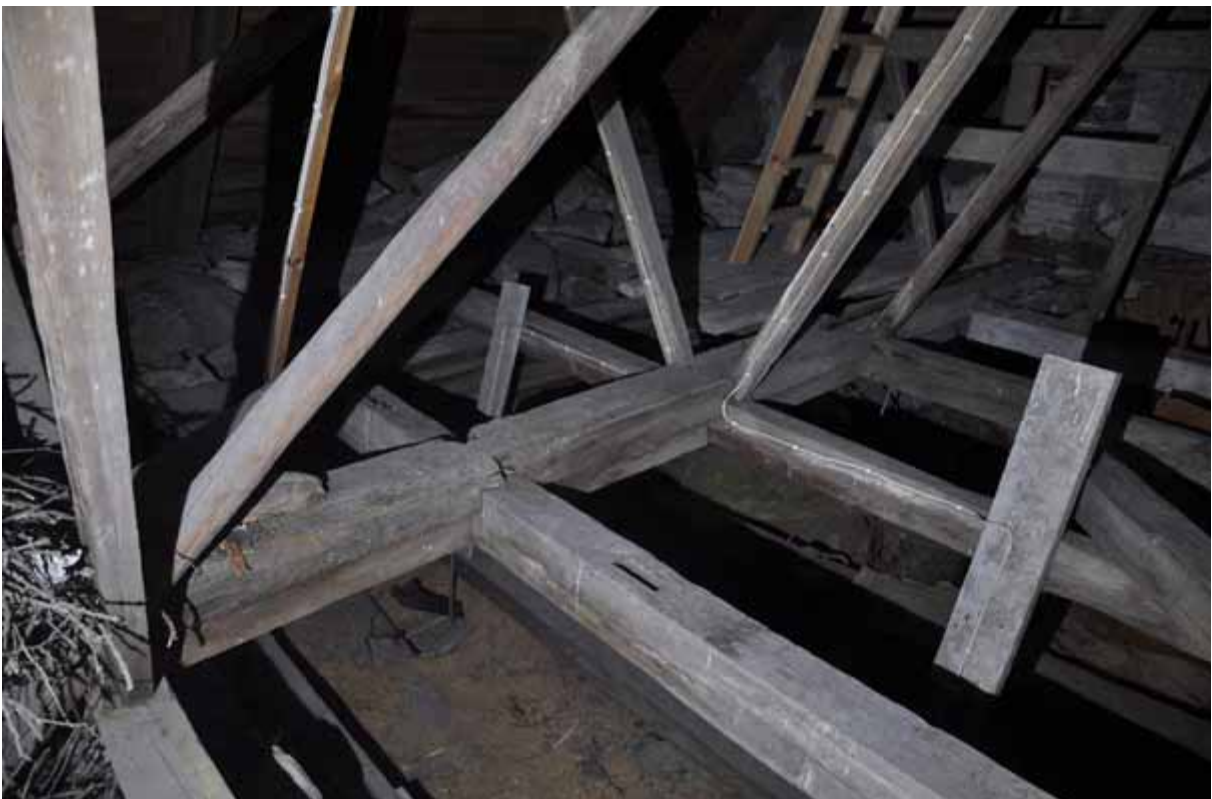
Tvårs bindbjälkarna i rummets mitt ligger en styrbjälke. Den utgör stöd för stödbenen. Fotografi: Daniel Eriksson
