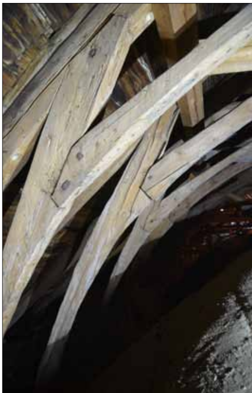
Mötena mellan takstolsdelarna har mycket varierande utförande, med och utan nacke mm (SLM D2015-1493).
