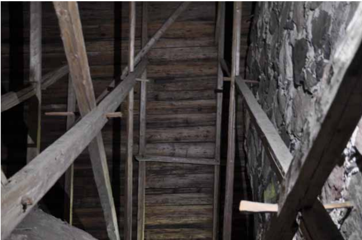
Mycket långa dymlingar. Den längst ned till höger stöter mot muren. Fotografi: Daniel Eriksson
