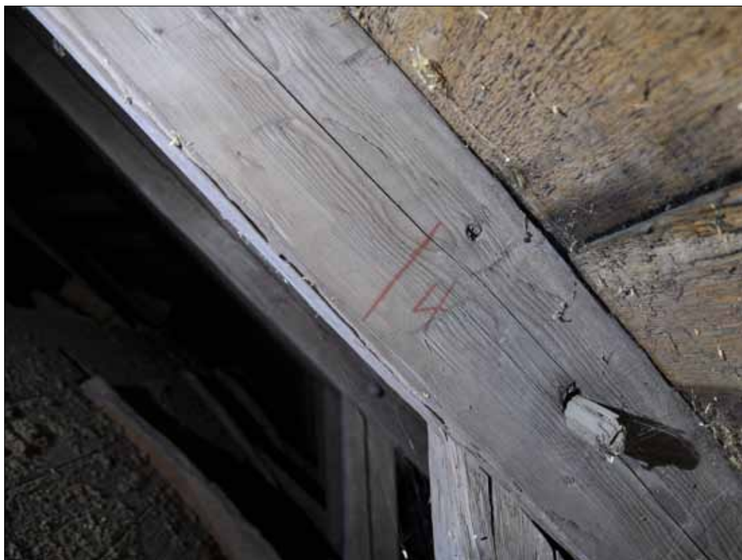
Siffrorna med rödkrita i mötet hanbjälke/högben kan möjligen härröra från den nya valvslagningen på 1700-talet (SLM D2015-1375). Fotografi: Daniel Eriksson.
