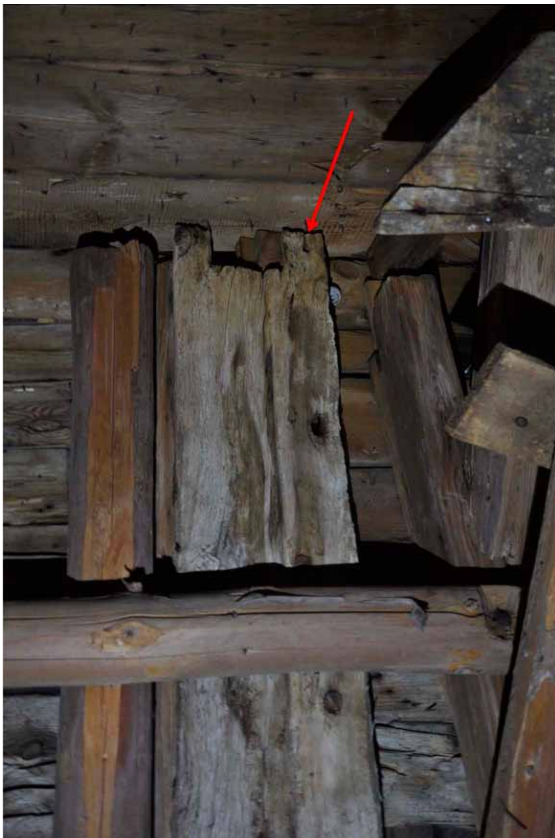
Inock har den en gaffel/slits. Mötande plankor från norra sidan har troligtvis haft motsvarande tapp. Längst upp till höger finns ett litet hål, troligen efter spik eller dymling som gått ned i ändträet på mötande plankor. Fotografi: Daniel Eriksson
