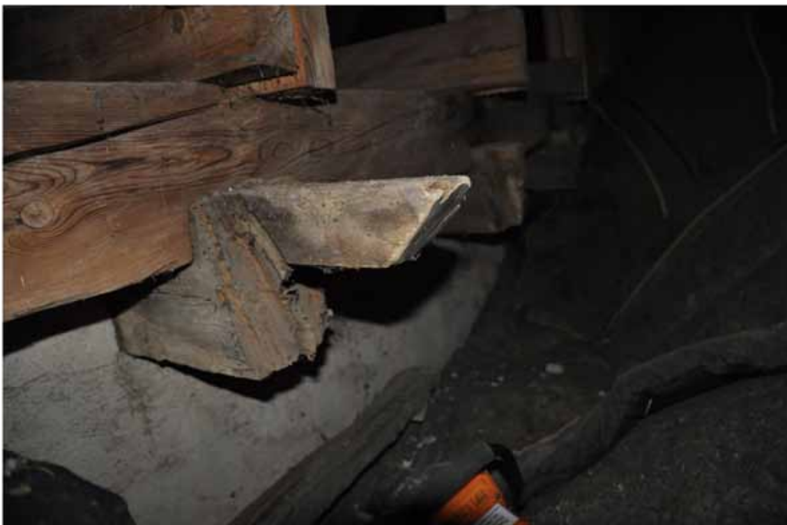
På denna bindbjälke finns något som kan vara en rest av en knutpunkt för ett stödben. Denna del är en viktig bit vid ett försök till rekonstruktion av det romanska taklaget. Fotografi: Daniel Eriksson
