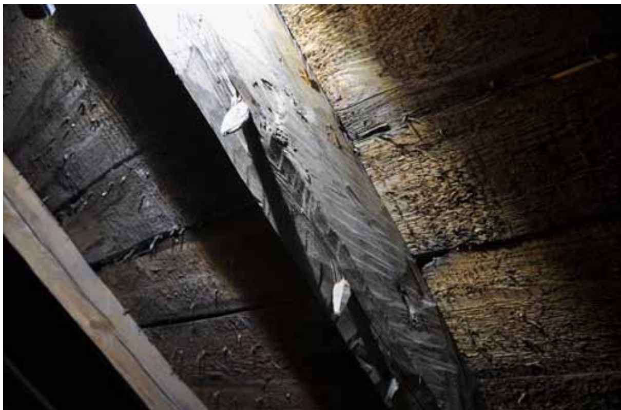
Högbenen håller ca B: 85mm, H: 100mm, och är uttagna som helstock. De har ekdymlingar för taktro. I nock är de sammanfogade med bladning halvt-i-halvt och dymling. Utom takstol 6 längst mot öster, som har två spikar.
