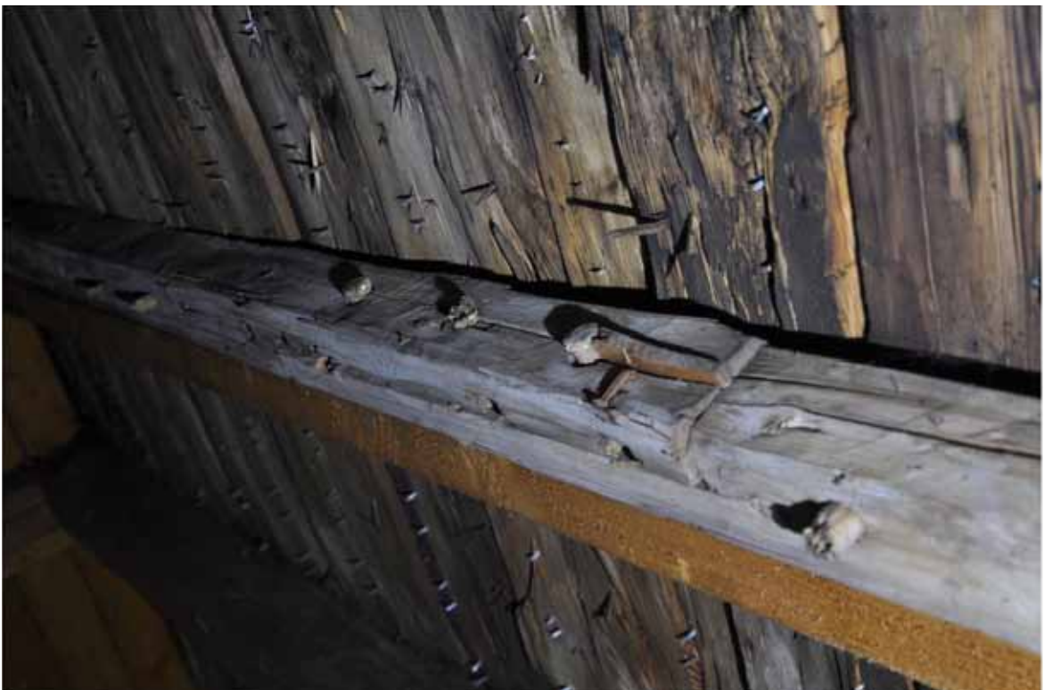
Ett av stödbenen har en ursprunglig skarv i form av en lång bladning, låst med tre "spikskalledymningar". Notera att skarven är genomborrad av hål för taktron. Troligen har man haft ont om virke eftersom man valt att göra denna skarv i ett öppet taklag. En likadan skarv finns i Suntaks kyrka, Skara stift, från 1100-talet. Se bild nedan. Fotografi: Daniel Eriksson
