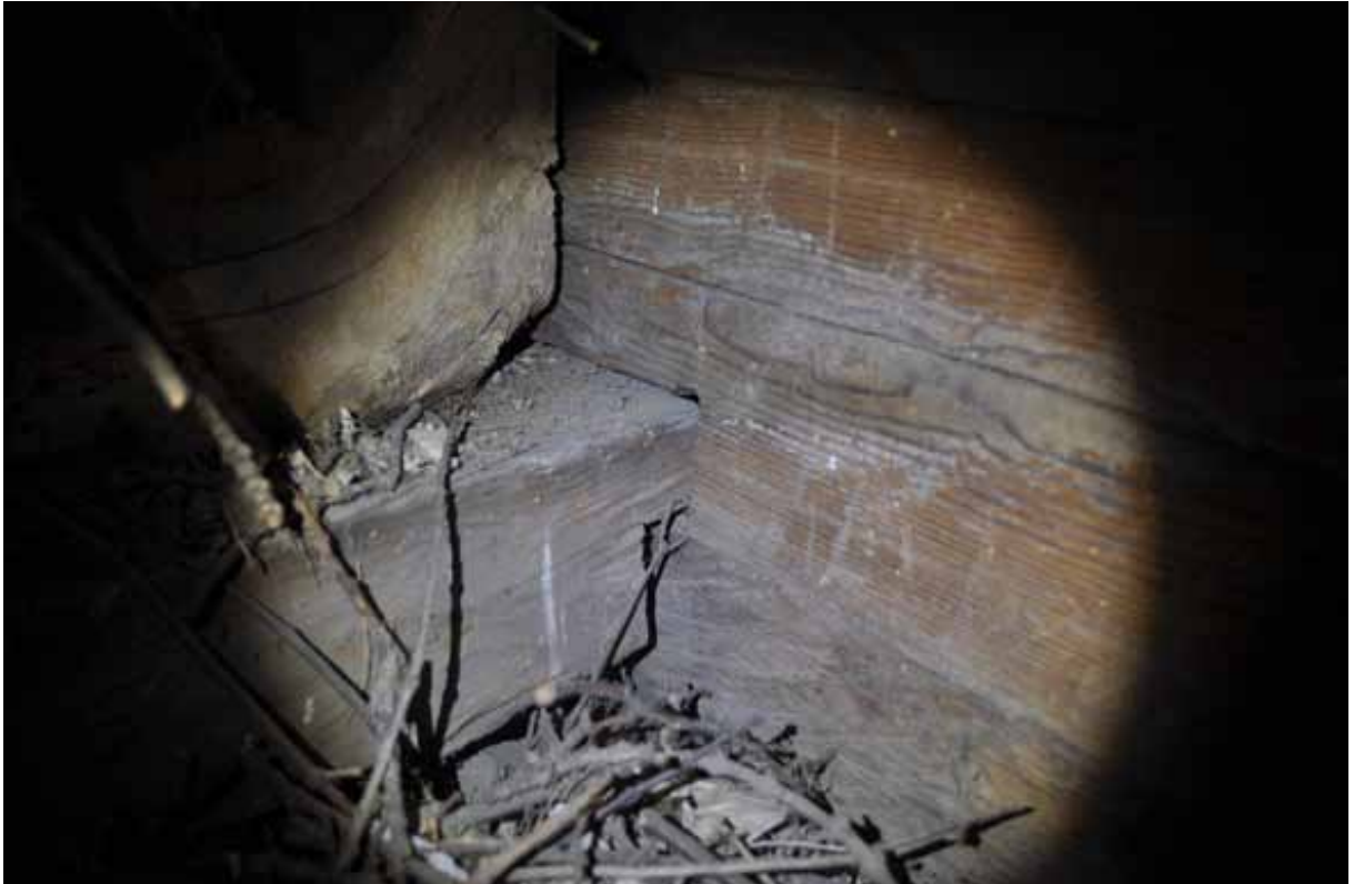
I den västra änden har den en enkel intappning i det timrade gavelröset. Fotografi: Daniel Eriksson
