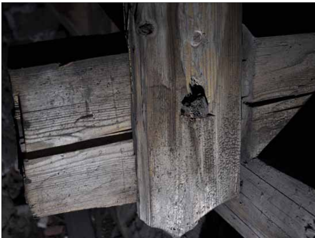
Nedre stödbenet löper genom och förbi knuten i tassan. Den slarviga ändkapningen är gjord innan montering. Notera ritsen för knuthaket till vänster om stödbenet (SLM D2015-1514). Foto: Daniel Eriksson.
