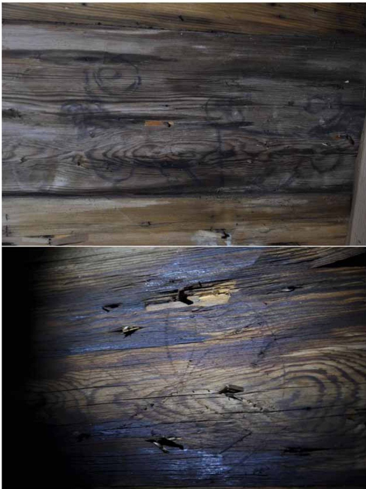
Korets taklag är av senare datum och undersöktes inte närmare. Där finns dock en återanvänd bräda i taket med cirkelrosetter och kolteckningar. Fotografier: Daniel Eriksson
