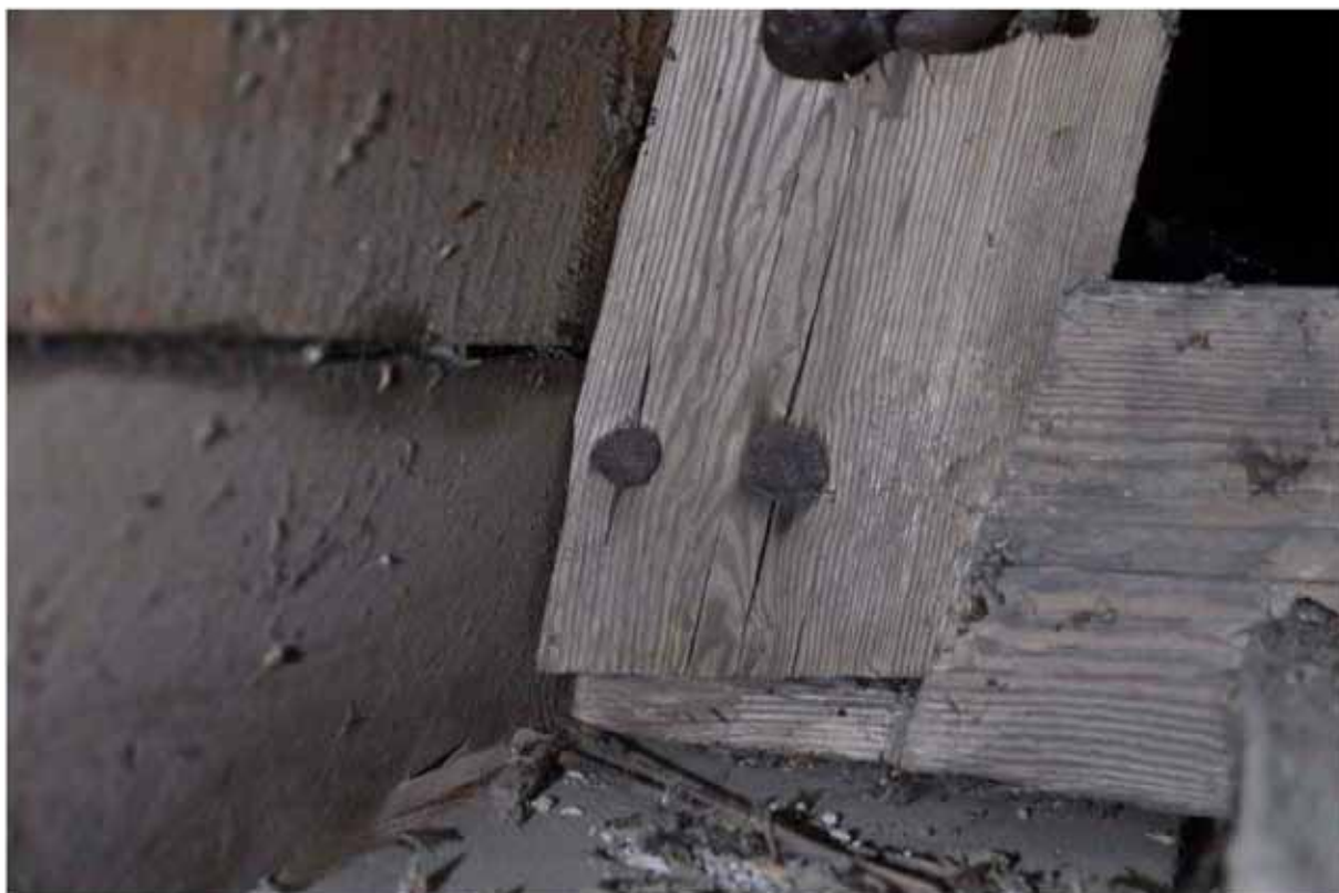
Högbenen möter bindbjälkarna med en bladning och två spik av olika storlek. Ej undersökt om det är konsekvent så. Fotografi: Daniel Eriksson
