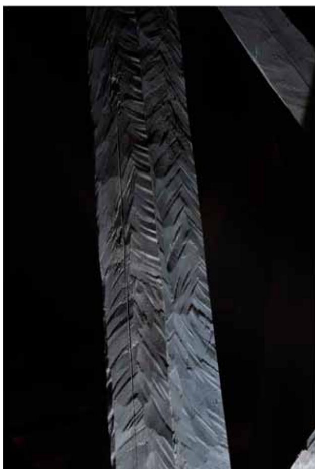
Exempel på sprätthuggning på en diagonalsträva. Fotografi: Daniel Eriksson
