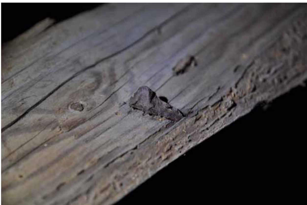
I södra högbenet på takstol 6 från öster, sitter en löst islagen spik, av samma typ som återfinns i Härad och Knista (Närke) kyrkor. Fotografi: Daniel Eriksson
