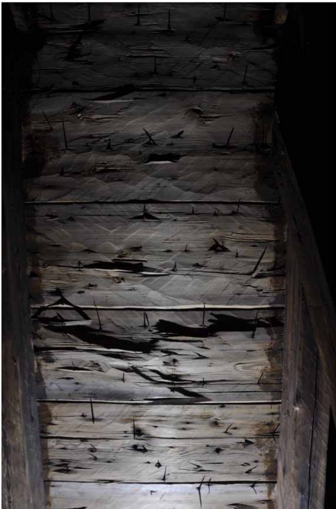
Stora delar av den ursprungliga taktron finns bevarad. Fotografi: Daniel Eriksson
