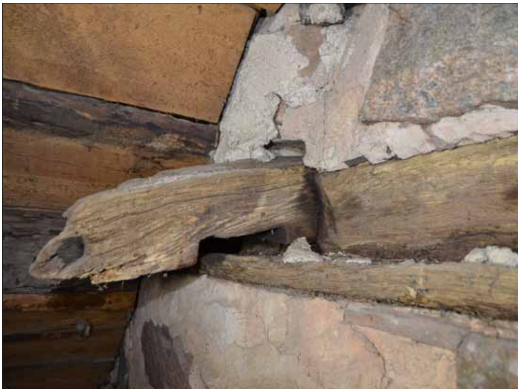
Utstickande taktass och yttre remstykke av ek med hylla tillhörande korets romanska takkonstruktion sedd från vinden över sakristian (SLM D2015-1479).
