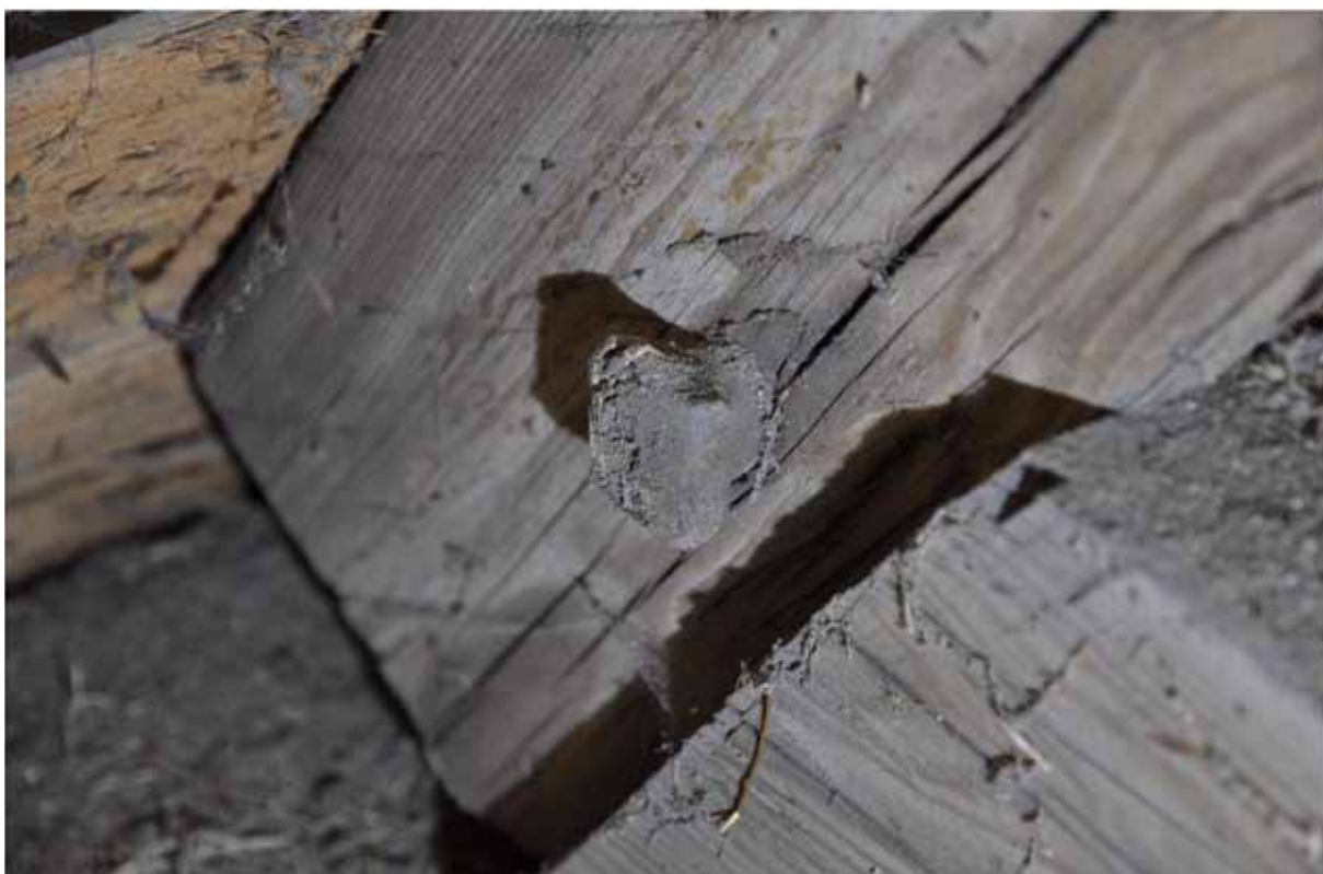
Ibland med spikskalleformad dymling.
