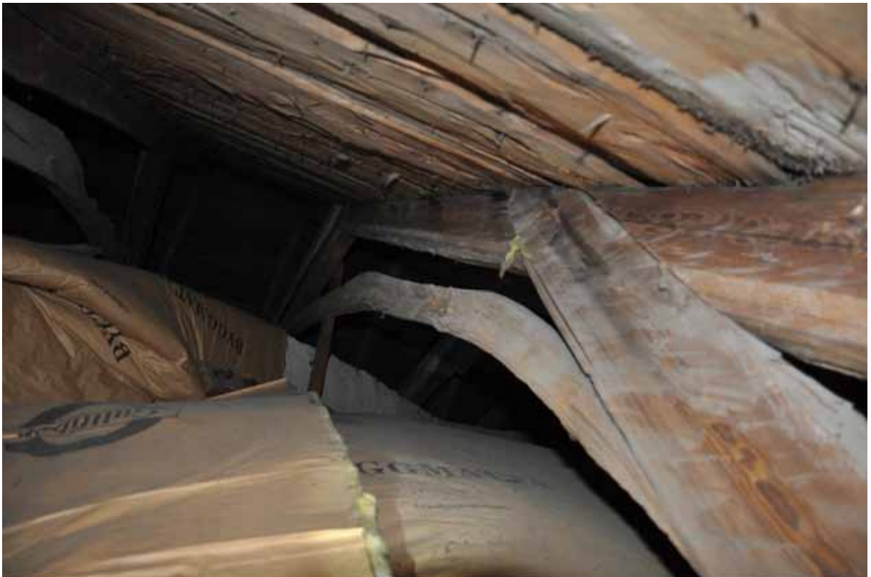
Det är inte alltid som krumvirkena håller den önskvärda radien. Detta virke har ett "platt" parti som synes. Fotografi: Daniel Eriksson
