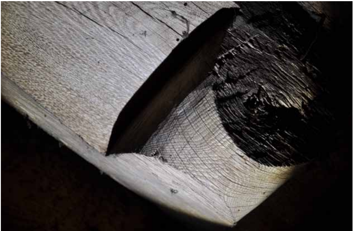
Detaljbilder på nockåsens dekoration visar att de är mycket omsorgsfullt bearbetade med yxa. Fotografi: Daniel Eriksson
