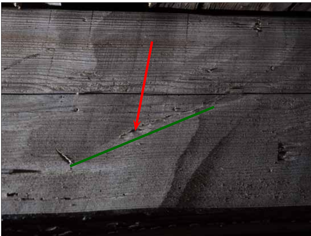
Exempel på huggspår från ett högben. Grön=yxans rörelseriktning i veden. Röd=eggens vinkel i förhållande till rörelseriktningen. Det ser ut som att timmermannen haft en yxa med överställt skaft och arbetat sig framåt (SLM D2015-1521). Foto: Daniel Eriksson.
