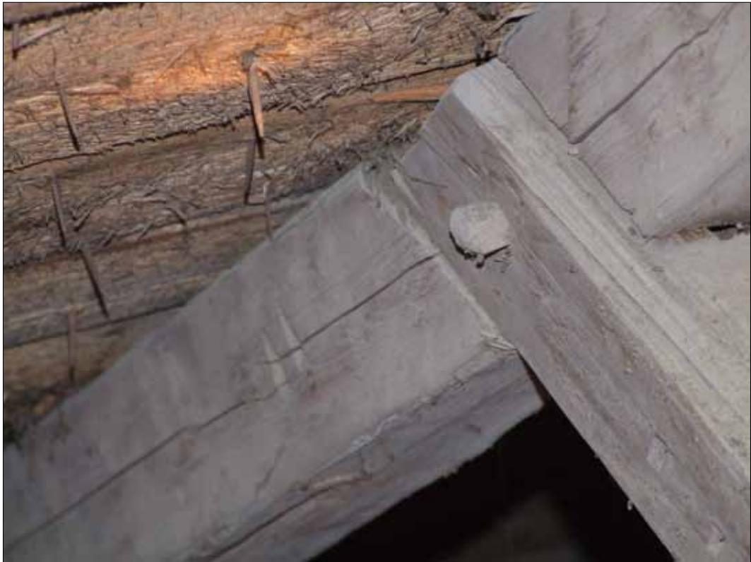
Takstolsdelarna är bilade och alla knutpunkter bladade halvt i halvt och dymlade samt har en enkel märkning (SLM D2015-1370).
