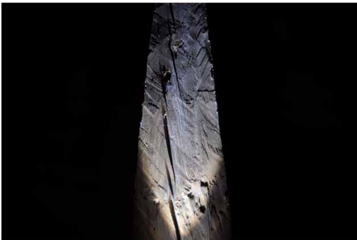
På ett av högbenen finns en märkning i form av sex ritsar. Är det en del i ett märksystem? Fotografi: Daniel Eriksson
