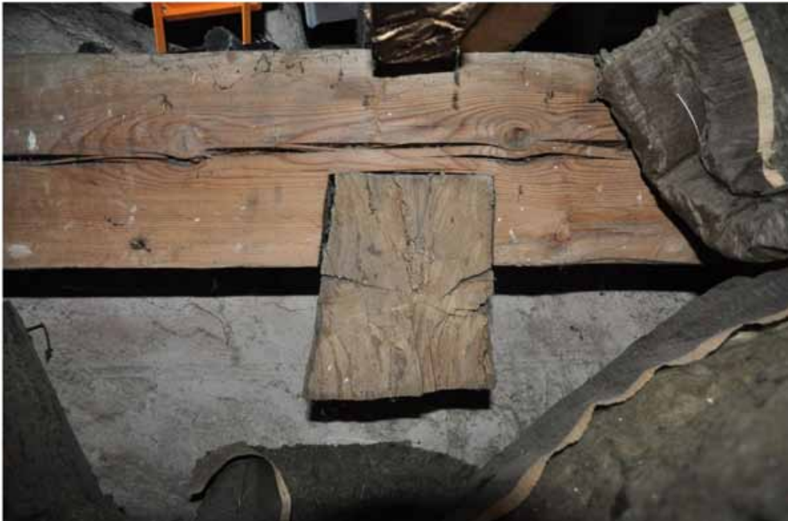
Här syns trapetsformen på en av bindbjälkarna. Bredden i den övre kanten är 130mm, och i den nedre 170mmHöjden är 190mm. Fotografi: Daniel Eriksson
