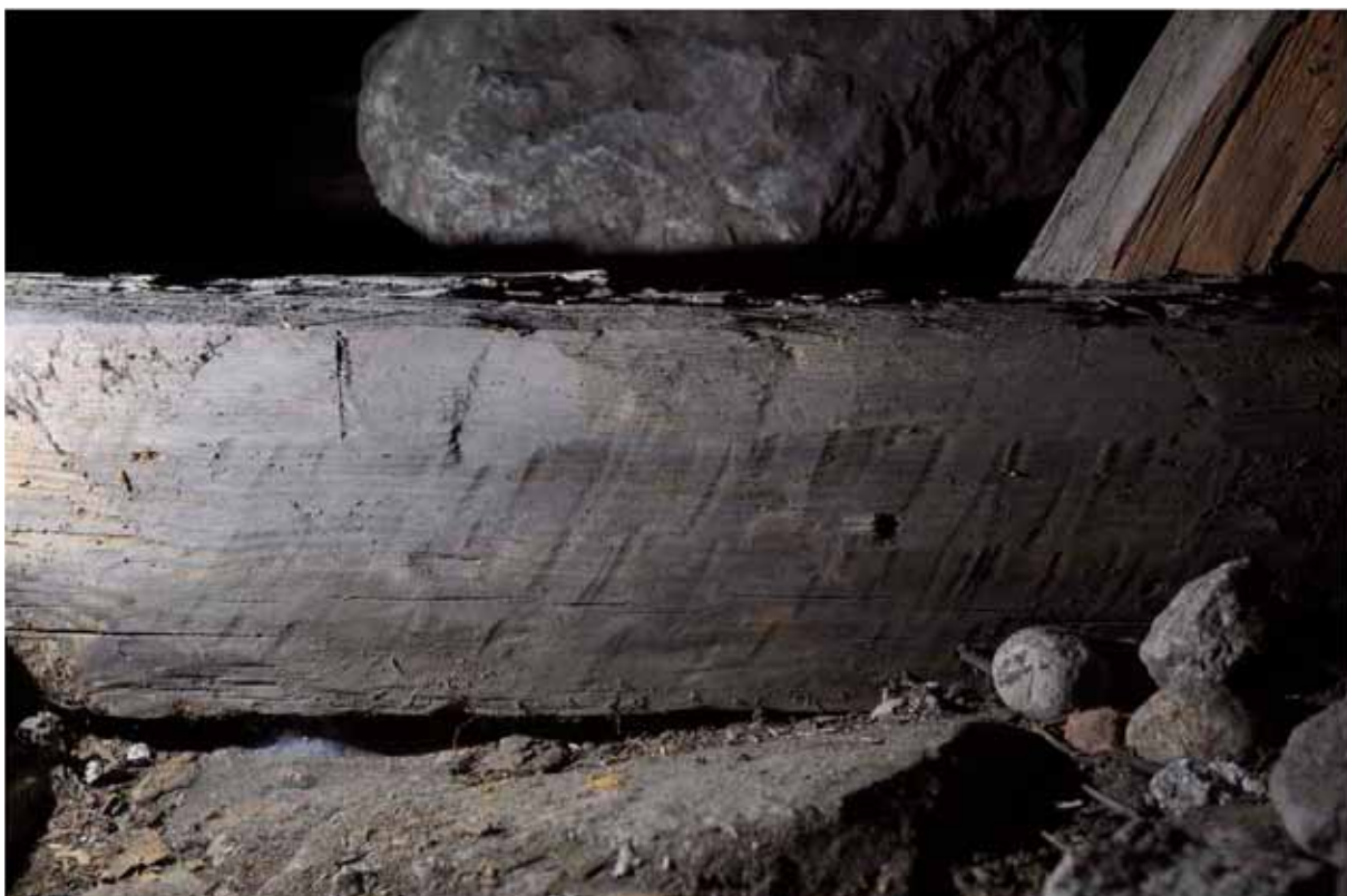
Exempel på sprätthuggning på en bindbjälke. Bindbjälkarna mäter ca B:150mm H:180mm. Fotografi: Daniel Eriksson
