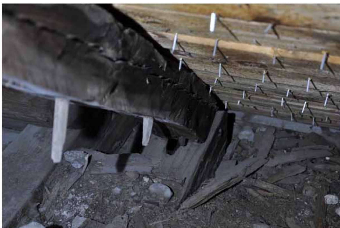
Högbenens höjdmått i tvärsnittet, blir större vid mötet med bindbjälken. Notera dymlingarna för taktron, gjorda av furuämnen. Knutpunkten är utformad som tapp och slits. I detta fall kan man se att högbenet glidit ur sitt läge och en del av slitsen blivit synlig. I nock är högbenen sammanfogade med varandra genom en bladning med dymling. Högbenens tvärsnitt är ca 85x100mm. Fotografi: Daniel Eriksson
