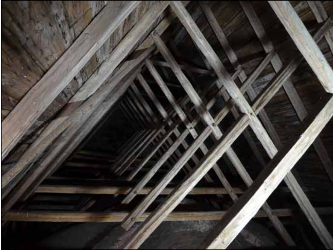
Långhusets takstolar (SLM D2015-1460).
