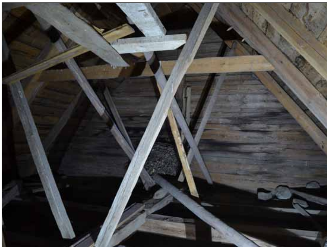
Tornrummets vind sedd mot väster (SLM D2015-1430).
