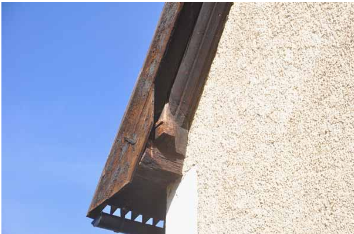
Remstyckena skjuter ut i gavlarna och bär upp en yttre takstol. Fotografi: Daniel Eriksson
