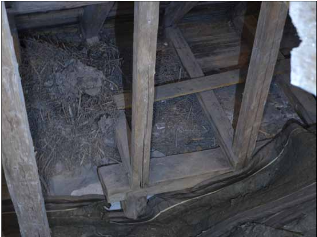
Inre remstyckets avslut mot 1700-talsutbyggnaden i väster (SLM D2015-1424).
