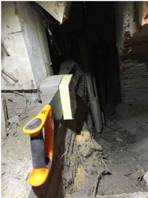
Sågskivor togs från tre olika takstolar. Bilden visar provtagning från en redan tidigare avsågad stickbjälke. Fotografi: Daniel Eriksson
