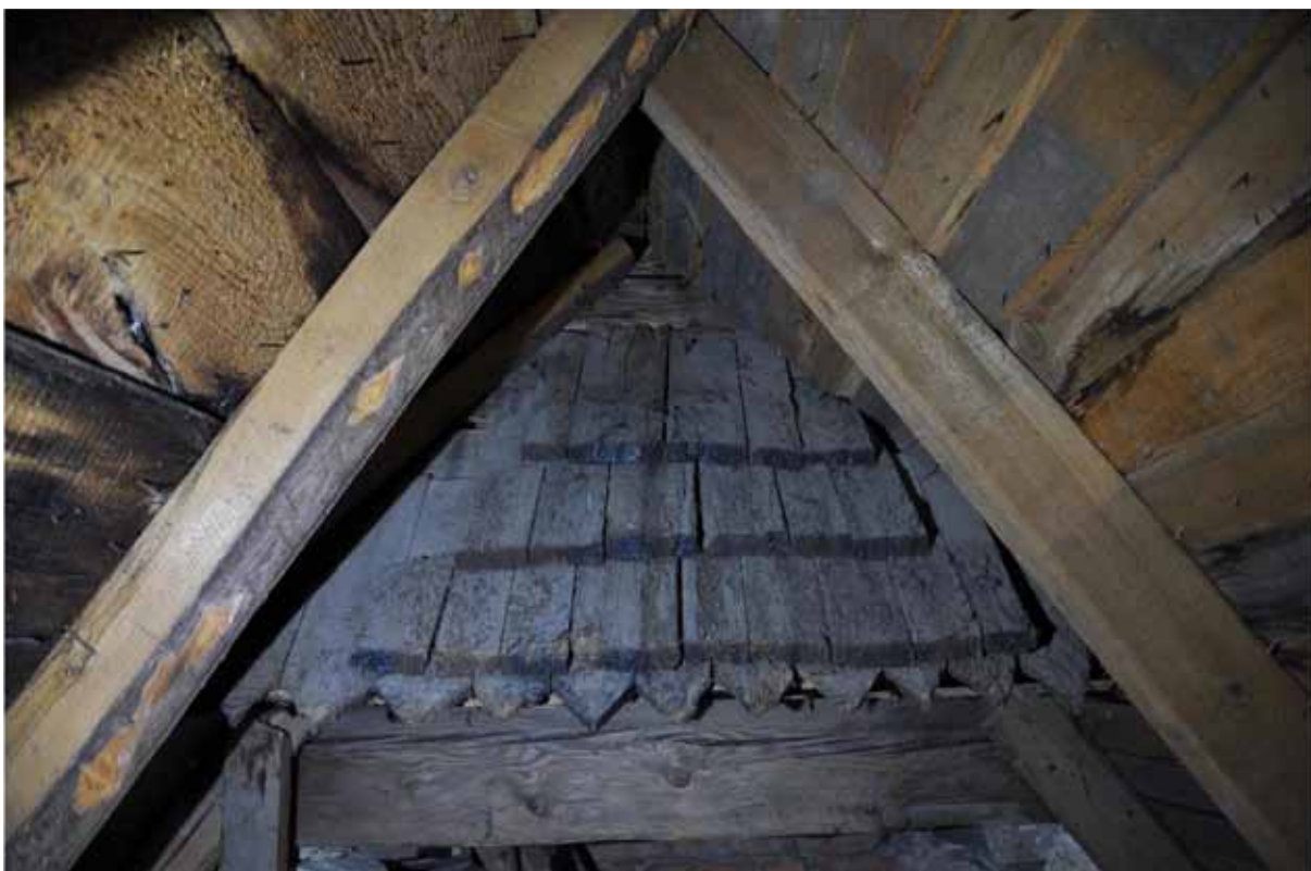
En liten del av korets tak finns inbyggt under sakristietaket. Spånen skulle kunna vara senmedeltida, men det märkliga är att de är spikade på sågade brädor. Fotografi: Daniel Eriksson
