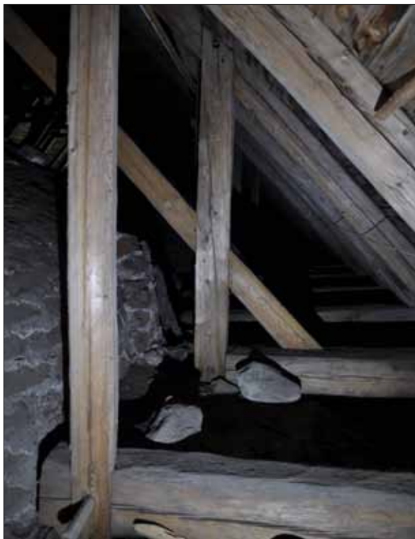
Andra stödbenet är från början utflyttat för att ge plats åt valvet. Taklaget är alltså yngre än valvslagningen (SLM D2015-1510). Daniel Eriksson.
