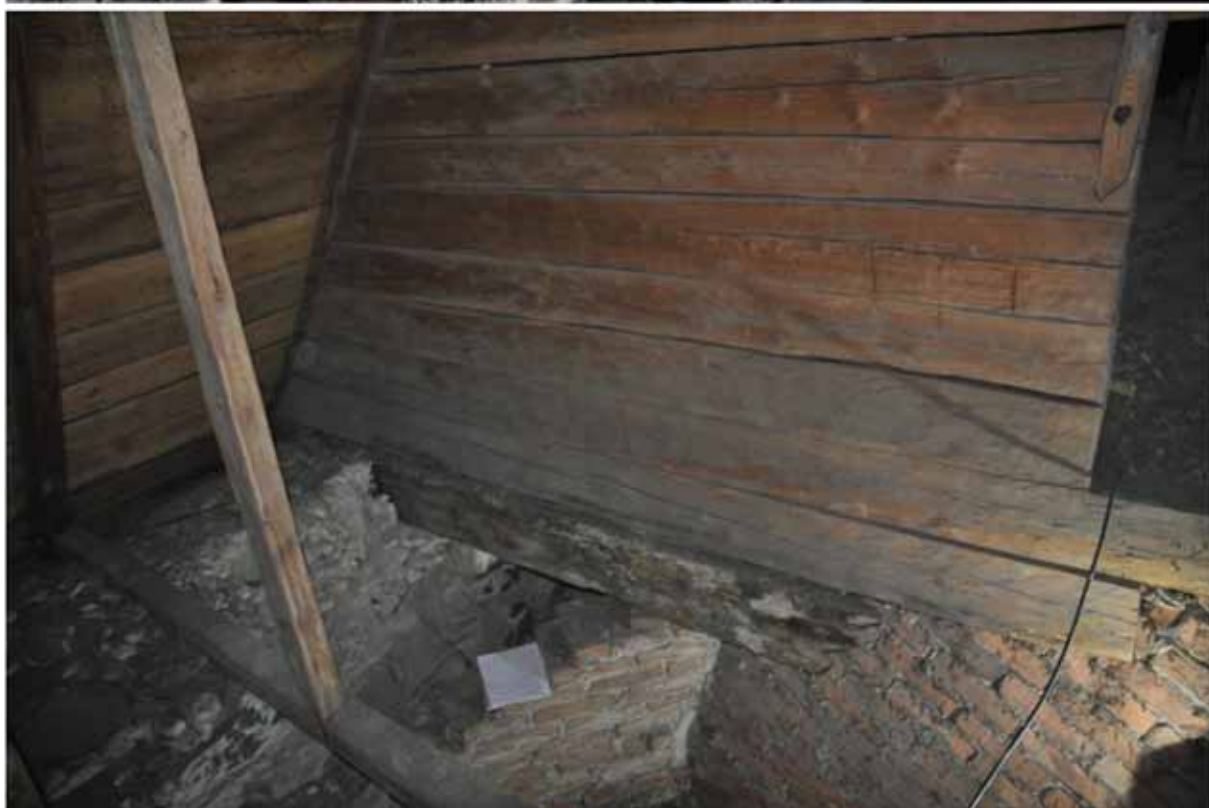
Under röstet på norra sidan finns en brandskadad stock som troligen hör till det ursprungliga röstet. Det är en ek och är sprätthuggen med en ganska stor yxa, minst 150mm eggängd. Dimensionen är B:310mm, H:300mm. Fotografi: Daniel Eriksson
