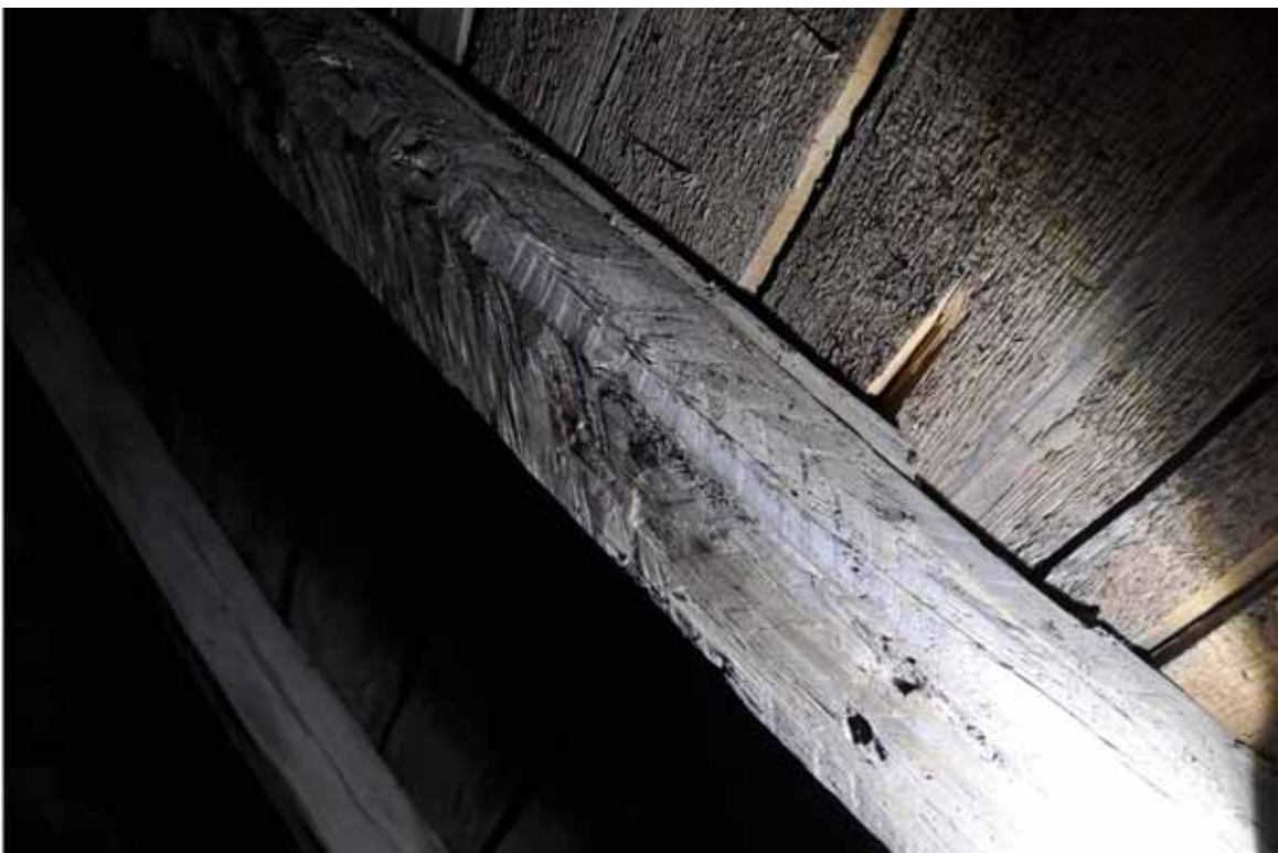
De ursprungliga högbenen är sprätthuggna med furudymplingar för taktro. De är huggna med avsmalning mellan rot och topp. Den genomsnittliga dimensionen är B:122mm, H: 117mm. Det innebär alltså att vissa högben är bredare än vad de är höga i tvärsnittet. Fotografi: Daniel Eriksson
