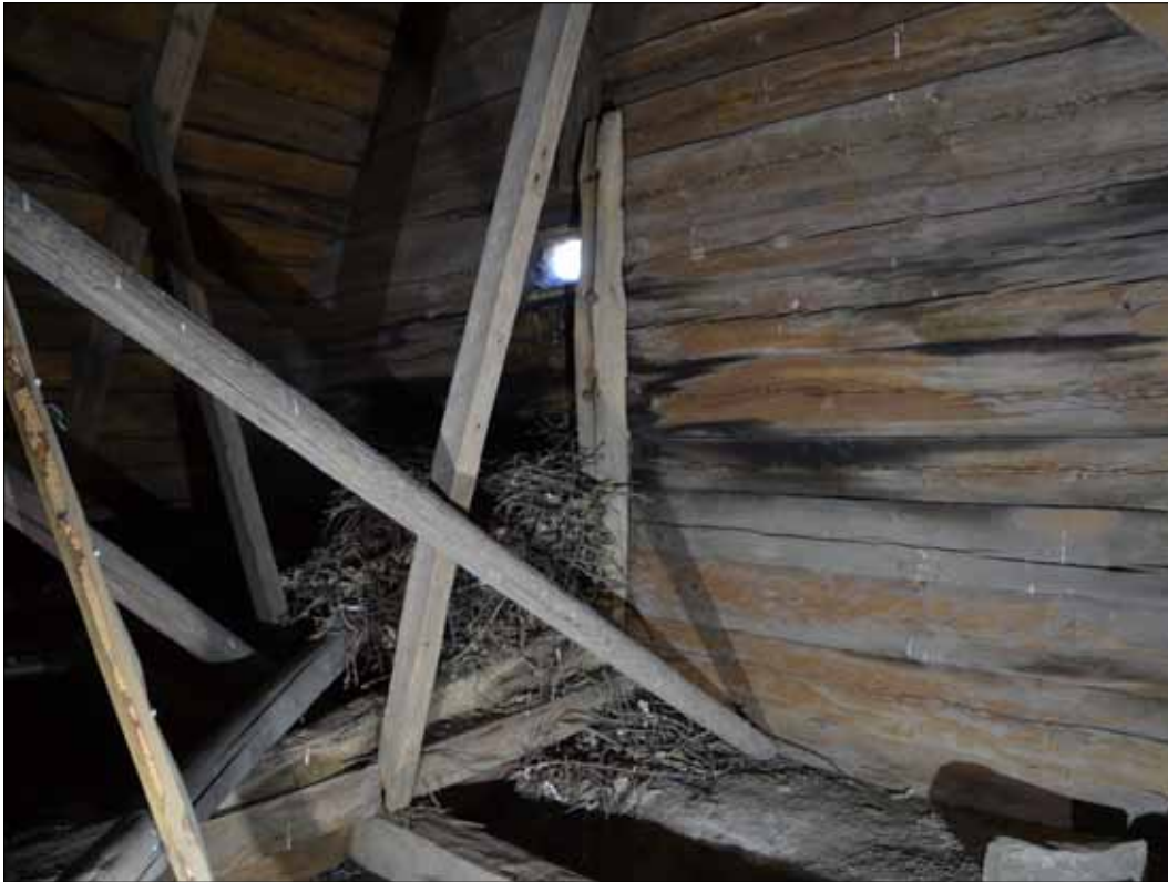
Tornrummets vind. Stort ek-knä är fastdymlat i timmerväggen och den t-formade styrbjälken (SLM D2015-1428).
