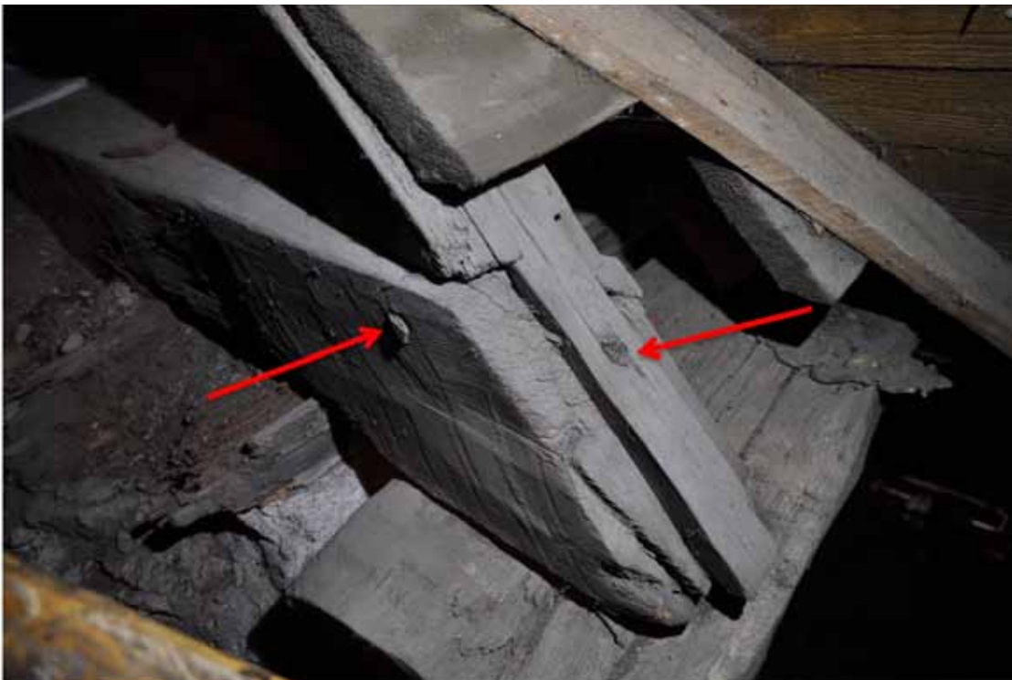
Vapenhusets anslutning mot långhuset gör att konstruktionen blir synlig "utifrån". Här syns tydligt hur knutpunkten är utformad, med tapp och slits. Mycket intressant är att knutpunkten är fixerad med två dymlingar, dels traditionellt från sidan, dels med en dymling utifrån. Observera den ursprungliga takfotsbrädan. Fotografi: Daniel Eriksson
