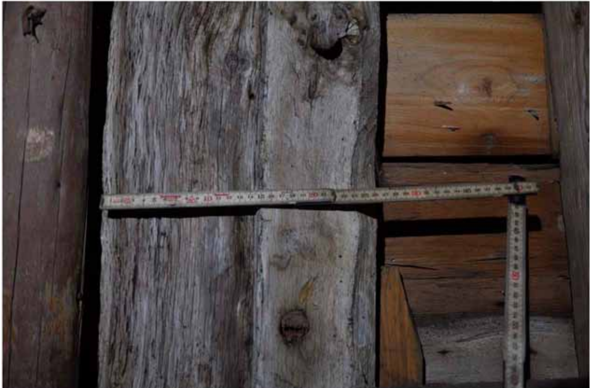
Undersidan har två ytor i olika plan. Planet till vänster är eroderat. Planet till höger är lutande. I högerkanten finns också mycket vankant vilket kan möjliggöra dendrodatering. Fotografi: Daniel Eriksson
