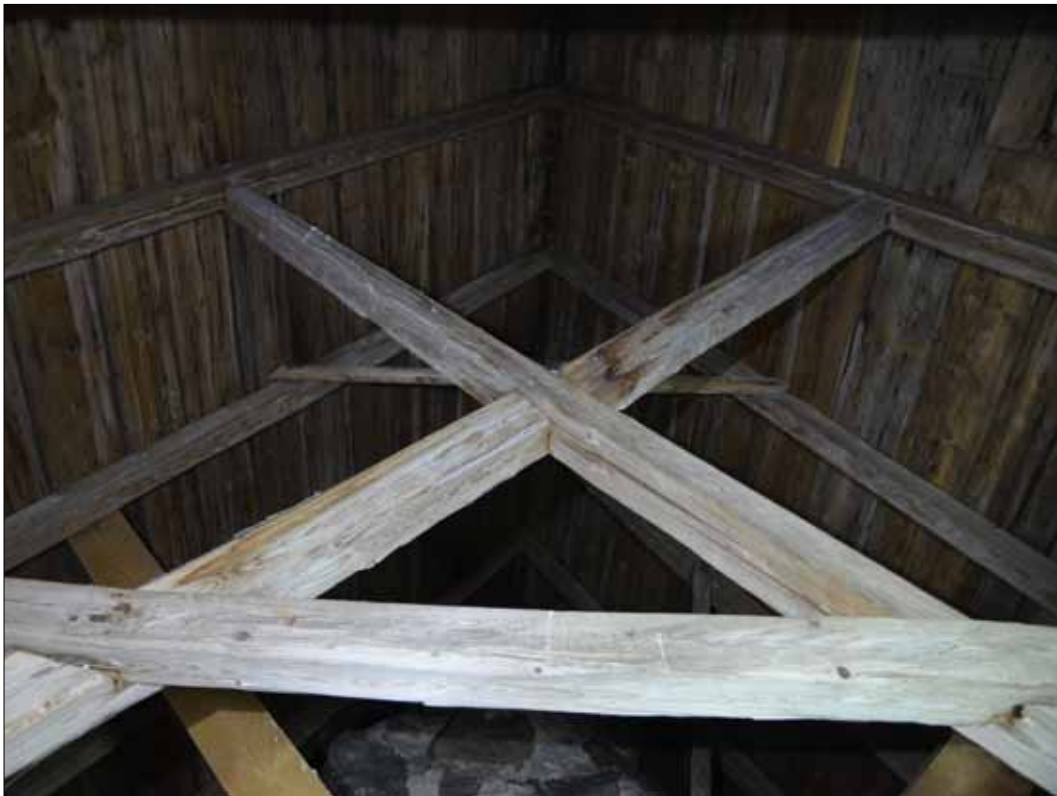
Saxsparrarnas möte med högben och hanbjälke (SLM D2015-1391).
