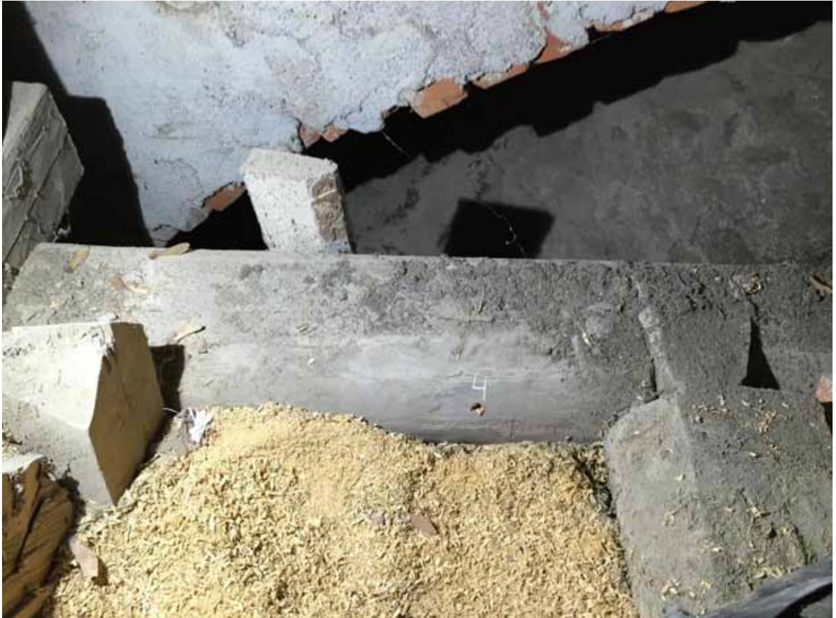
Remstyckena består av mer eller mindre rundvirke och utgör därmed ett bra dendrokronologiskt material. Bilden visar borrhålet för prov nummer fyra. Fotografi: Daniel Eriksson
