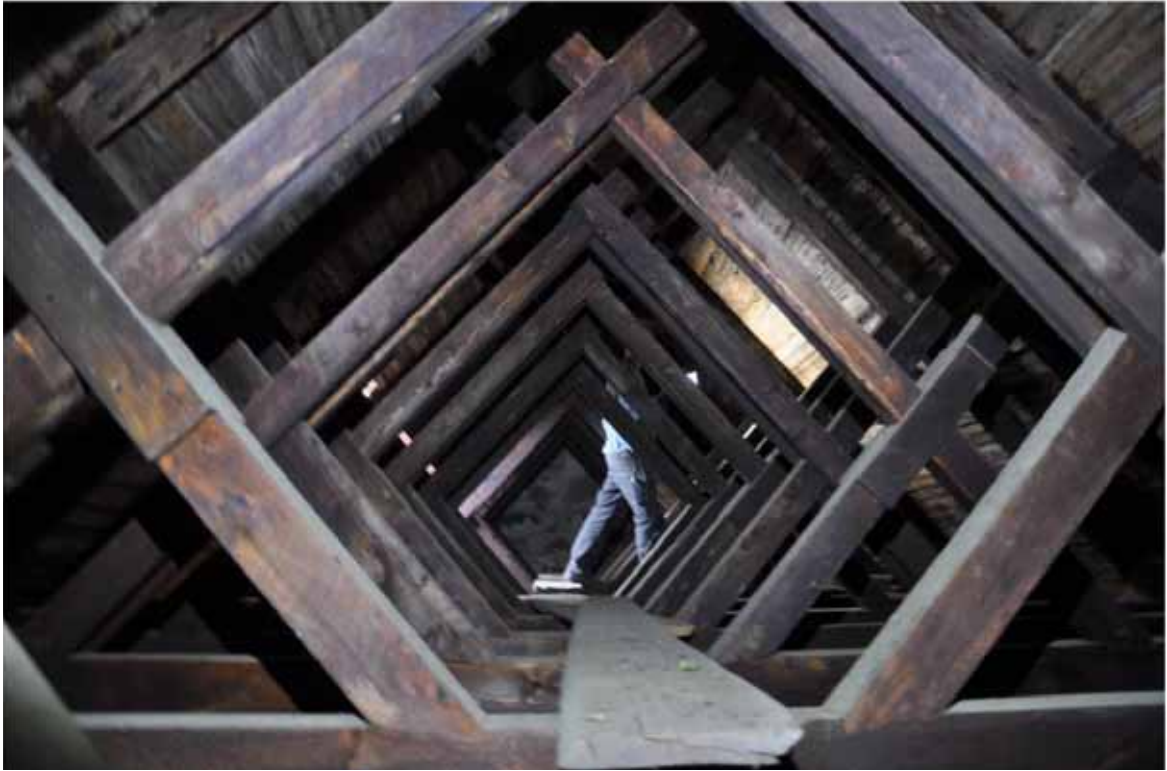
Takstolsdelar från 1953, utformade som ett romanskt taklag med korsande stödben. Fotografi: Daniel Eriksson
