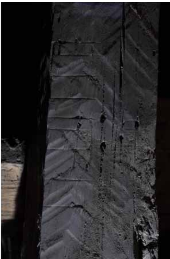
Här finns ett märksystem som verkar ovanligt konsekvent. Märkningen är utformad som raka streck, vinkelrätt från virkets ena kant. Det verkar som man har satt yxan mot bjälken och sedan slagit med klubba. Här syns nio sådana streck. Fotografier: Daniel Eriksson
