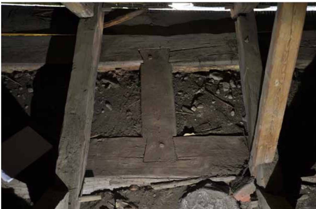
Yttre och inre remstycket är sammanfogade med varandra genom laxade kortlingar...
