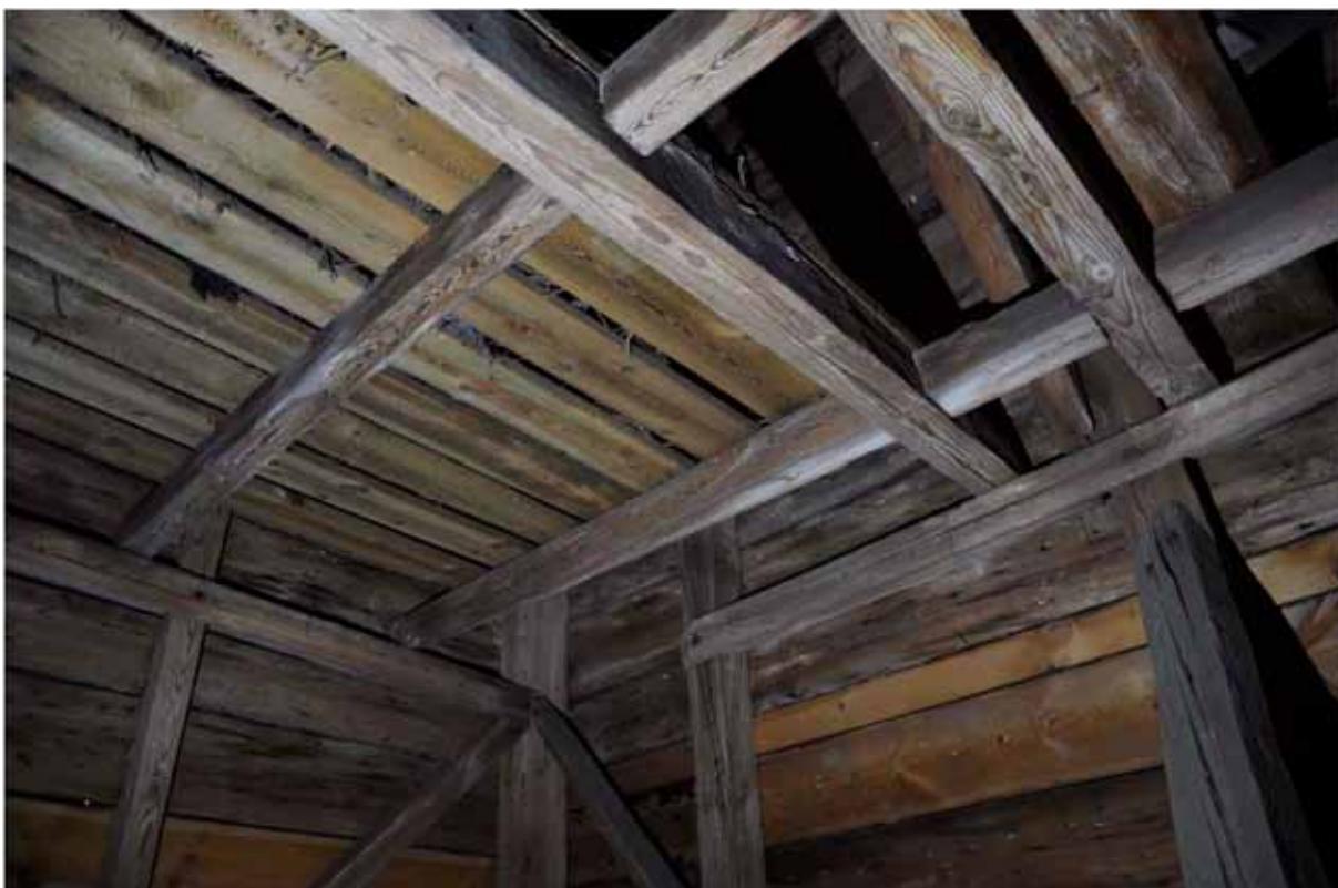
En bit upp i tornhuven finns ett bjälklag i lite klenare dimensioner. Detta bjälklag är ursprungligt. Syftet med bjälklaget måste utredas vidare. Är det endast en arbetsplattform eller är det en del i den bärande konstruktionen. Fotografi: Daniel Eriksson
