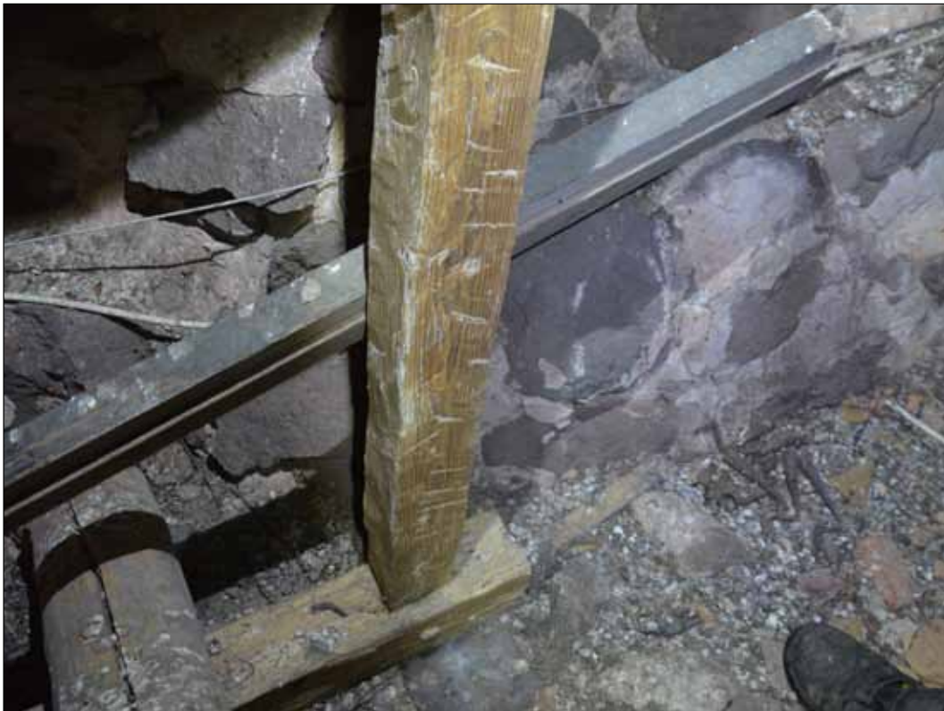
Det återanvända stödbenet i takstol nr 4 i söder har sprätthuggen yta (SLM D2018-0001).
