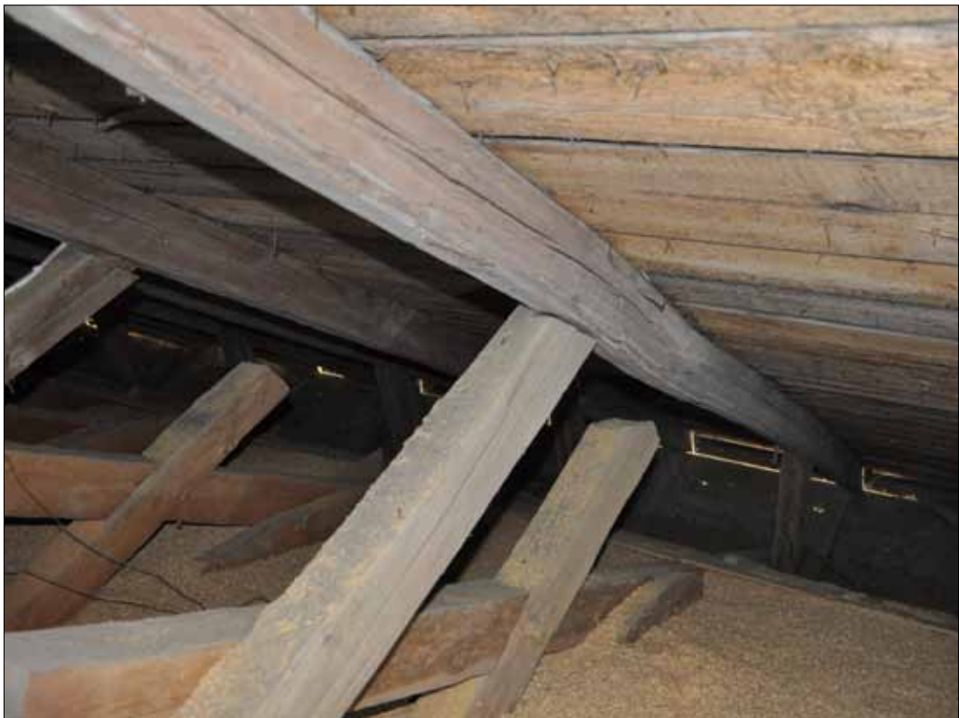
Notera det krokiga högbenet och att timmermannen har huggit med böjen både på över- och undersida. Bockkonstruktionen för 1754-års tunnvalv (SLM D2015-1371). Fotografi: Daniel Eriksson.
