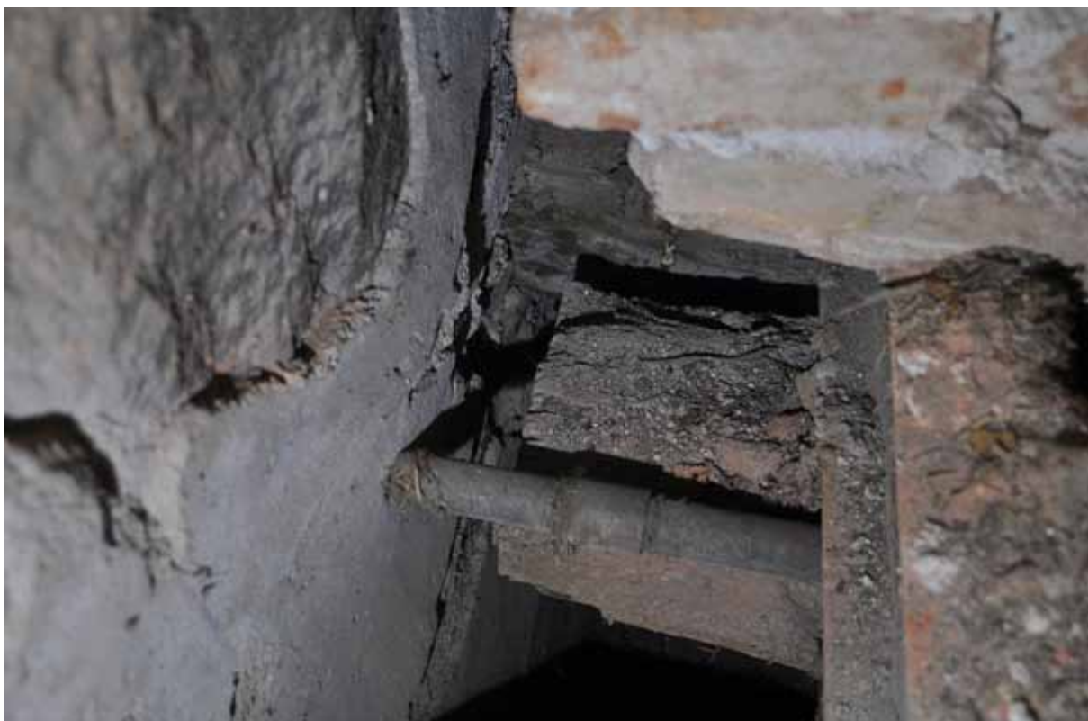
Styrbjälken har i sin östra ände ett rakt avslut strax innan muren. Fotografi: Daniel Eriksson
