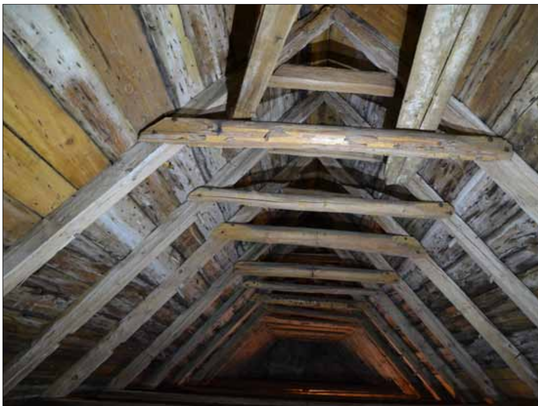
Långhusvinden sedd mot öster. Sprättthuggna högben med urtag för stödben och dymlingar för infästning av taktrö. Delar av taktrö är sprättthuggen och fastdymlad i högbenen (SLM D2015-1505).
