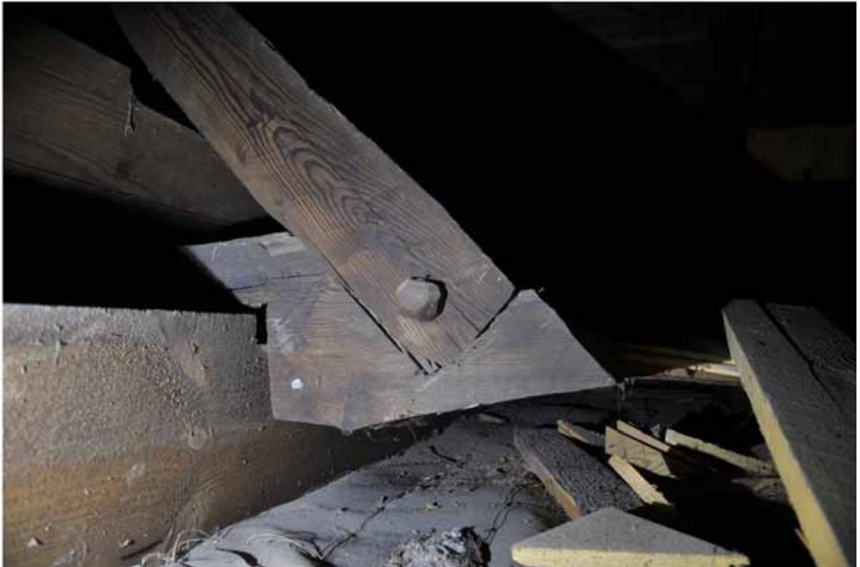
Knutpunkt bindbjälke högben med furudympling. Observera att takfotsbrädan varit uppvinklad. D.v.s. bindbjälkens undersida har ett lutande plan, vilket är ganska vanligt på romanska taklag.
