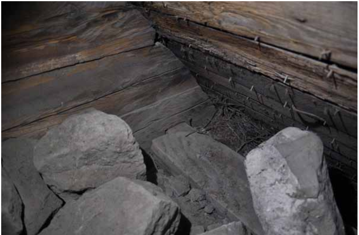
Röstets första stock greppar över remstycket på samma sätt som bindbjälkarna. Fotografi: Daniel Eriksson
