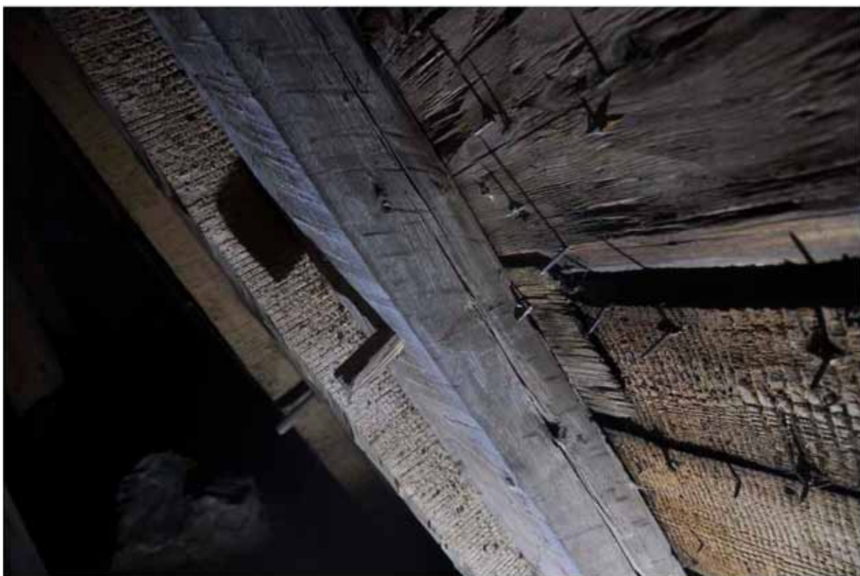
Högbenen mäter ca B:90mm H:105mm. Måtten är tagna långt ned nära takfot. Dymlingar för taktro. Fotografi: Daniel Eriksson
