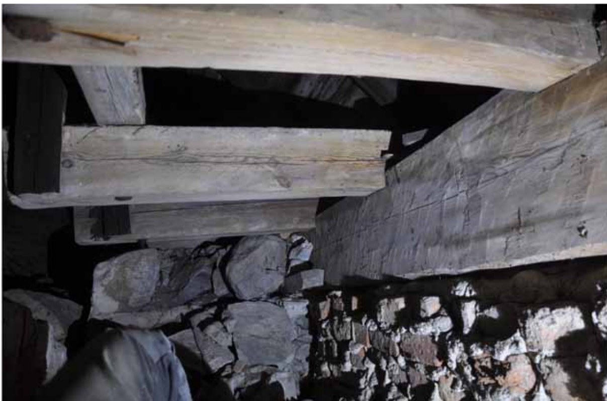
På södra sidan är ett parti av muren mer öppet och här kan man se konstruktionen från undersidan. Remstycket till höger, och de kapade bindbjälkarna på tvären i bild. Fotografi: Daniel Eriksson
