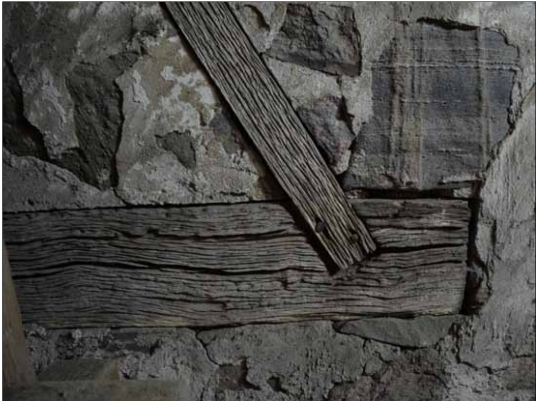
Långhusets västra gavelröste som före 1600-talets tillbyggnad mot väster var synligt. I gavelröset finns en inmurad takstol som bör vara 1200-tal. Takstolsvirket är väderbitet och stödbenen är spikade med smidd spik. (SLM D2015-1440).
