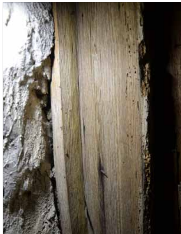
Detalj av L-format högben som ligger ovanpå västra gavelröstet (SLM D2015-1438).
