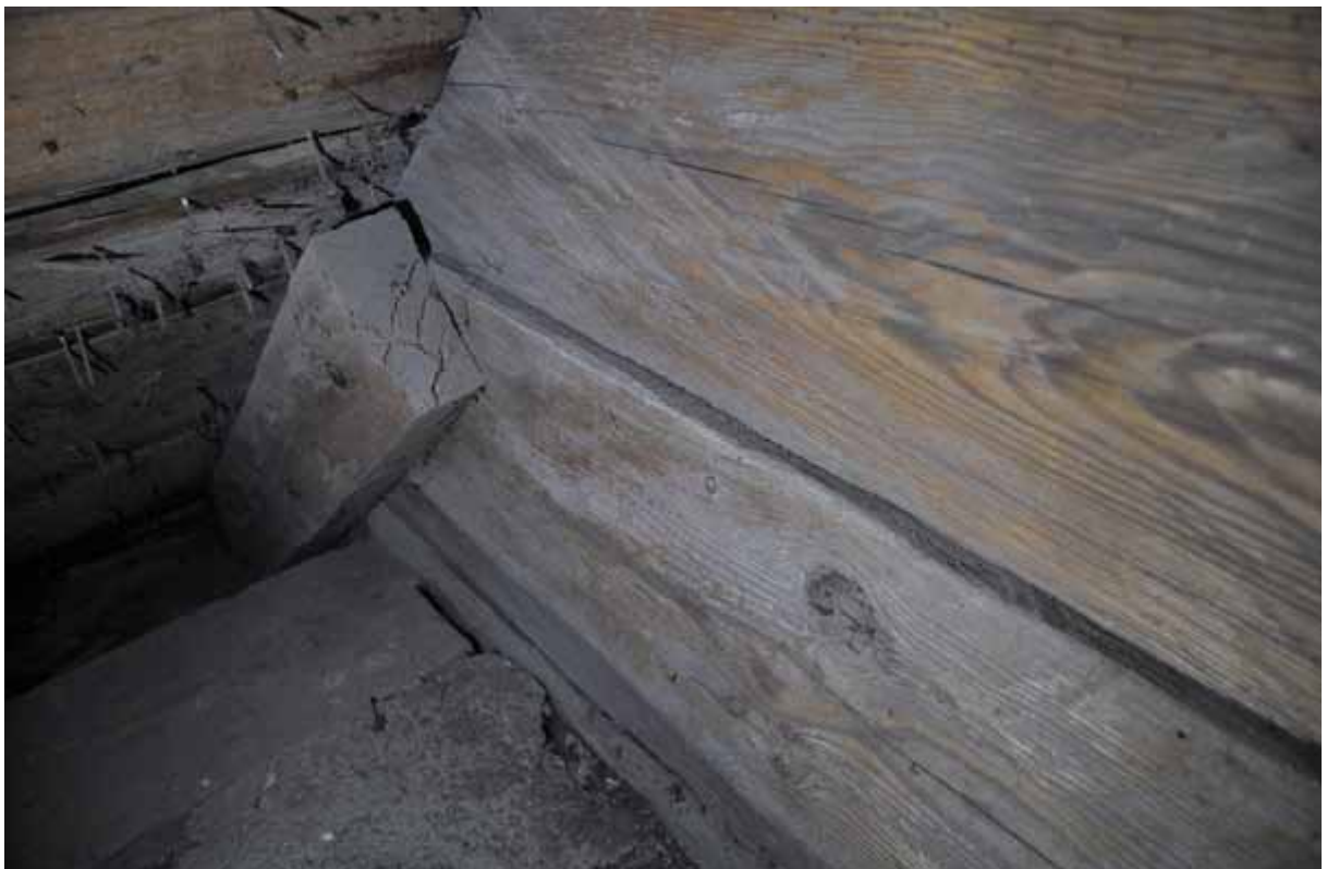
Vankant tycks finnas på andra stockens södra ände. Kan vara svåråtkomligt för dendrobörning p.g.a. taket. Fotografi: Daniel Eriksson
