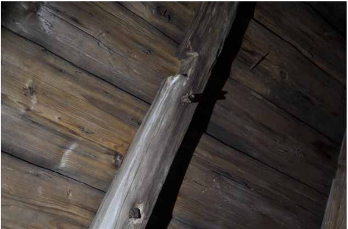
Även stödbenens infästning i högbenen har varit genomgående bladning med spik. Dymplingar för taktro finns fortfarande kvar. Ämnet till detta högben har troligen ej hållt måttet. Därför är undersidan helt obearbetad närmast nocken. Ganska ovanligt i romanska taklag. Fotografi: Daniel Eriksson
