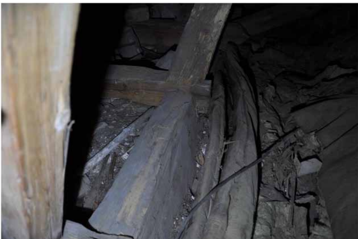
Remstyckena ser lite olika ut och det är svårt att veta vad som är ursprungligt. Här ses inre remstycket på norra sidan. Det är kraftigt trapetsformat i tvärsnittet och det gör att det känns ursprungligt. Det södra remstycket har en betydligt enklare utformning. Samtidigt går vissa av stickbjälkarna lite väl långt in genom tunnvalvet vilket är märkligt. Fotografi: Daniel Eriksson
