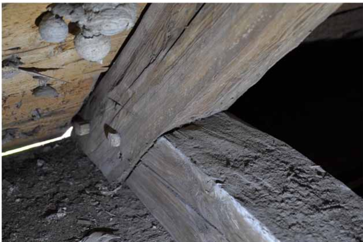
Knutpunkterna mellan högben och bindbjälkar är utförda som bladningar halvt-i-halvt.
