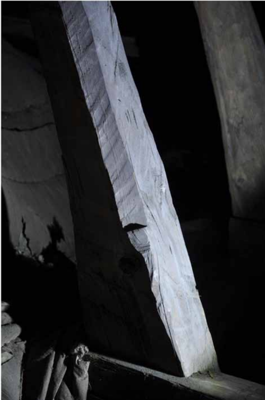
Takstol två och tre, räknat från öster i tunnvalvet, fasade kanter med dekoration på baksidan. Dock endast på västra sidan. Man får intrycket att man dekorerat här för att de varit synliga, men för vem? De kan inte varit synliga nedifrån kyrkorummet. Kanske från ett eventuellt tornkapell, men det är knappast troligt att man kunna se dem därifrån heller. Fotografi: Daniel Eriksson
