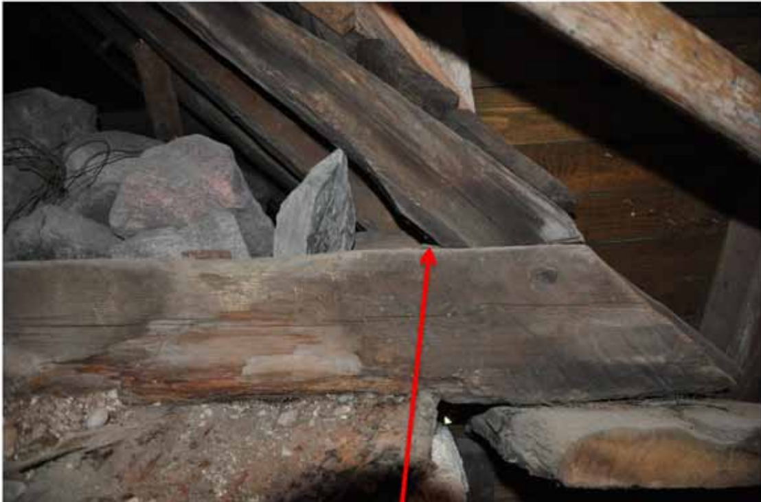
Högbenets ansvällning mot bindbjälken syns tydligt från sidan. Här finns vankant för dendroprovtagning. Bindbjälkens tvärsnitt är ca 210x150mm och den löper rakt genom remstyckets urtag, utan hak. Fotografi: Daniel Eriksson
