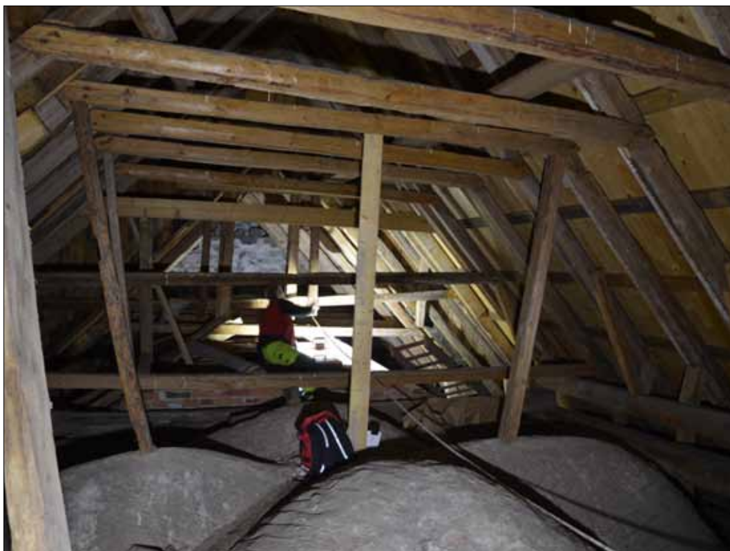
Långhusets taklag sett mot öster (SLM D2015-1450).
