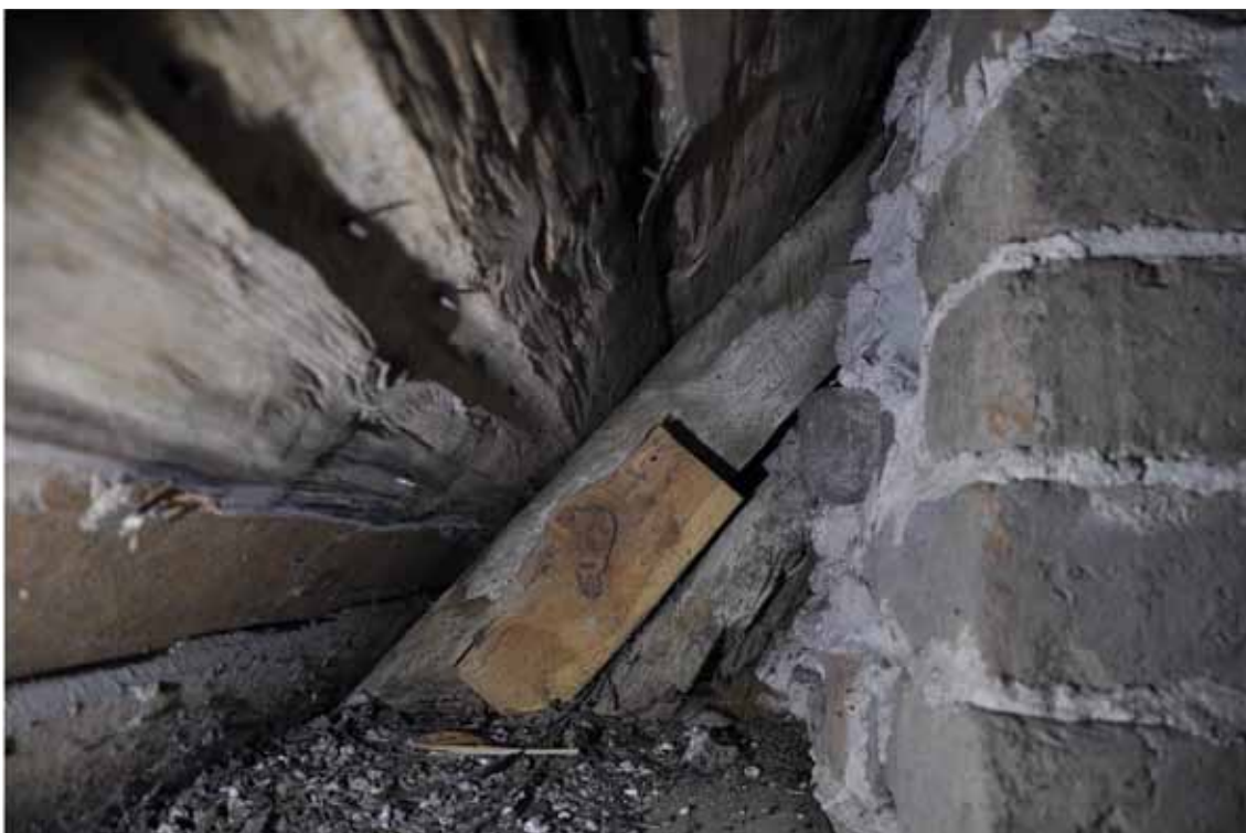
I det östra röstet finns troligen ett ursprungligt högben i ek. Ovanpå detta ligger ytterligare ett högben, även det i ek. Troligen är det en påsalning i samband med att man gjorde ett nytt taklag som då hamnade lite högre. Fotografi: Daniel Eriksson
