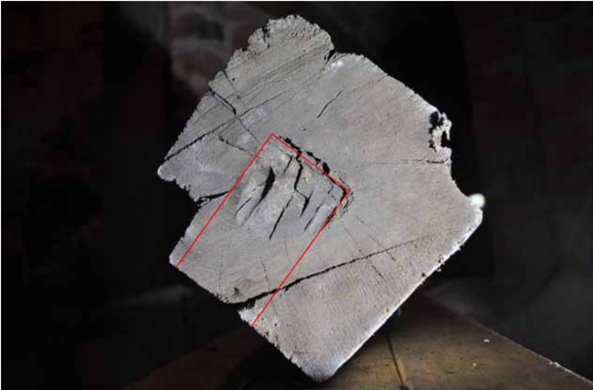
I ändträet kan man se spår av ett tapphål för ett högben/sparre. Tapphålen tycks vara förborrade med ett ganska litet borr. Fotografi: Daniel Eriksson
