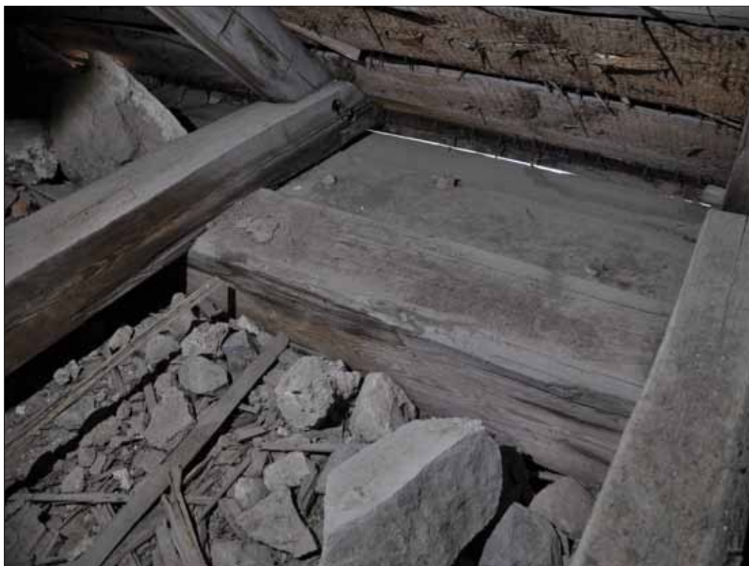
Yttre remstykke med vankant, lämplig för dendrodatering. Remstykke ca 23x24 cm. Knutpunkt tasshögben har rak bladning med stor dymling. Tass ca 13x20 cm. Högbenens dimension varierar mycket, medelvärde ca 10x16 cm (SLM D2015-1511) Foto: Daniel Eriksson.
