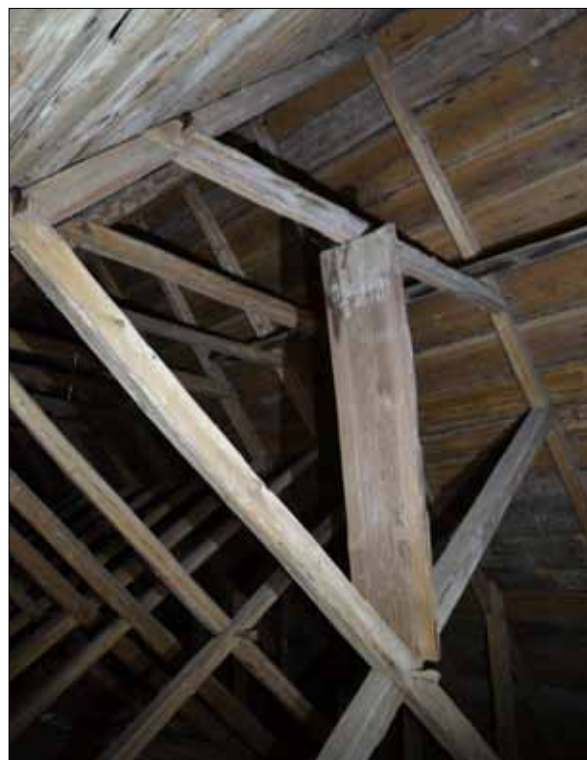
143 Långhusets taklag sett mot öster med saxspararnas möten och hanbjälkar dymlade med stora dymlingar (SLM D2015-1452).
