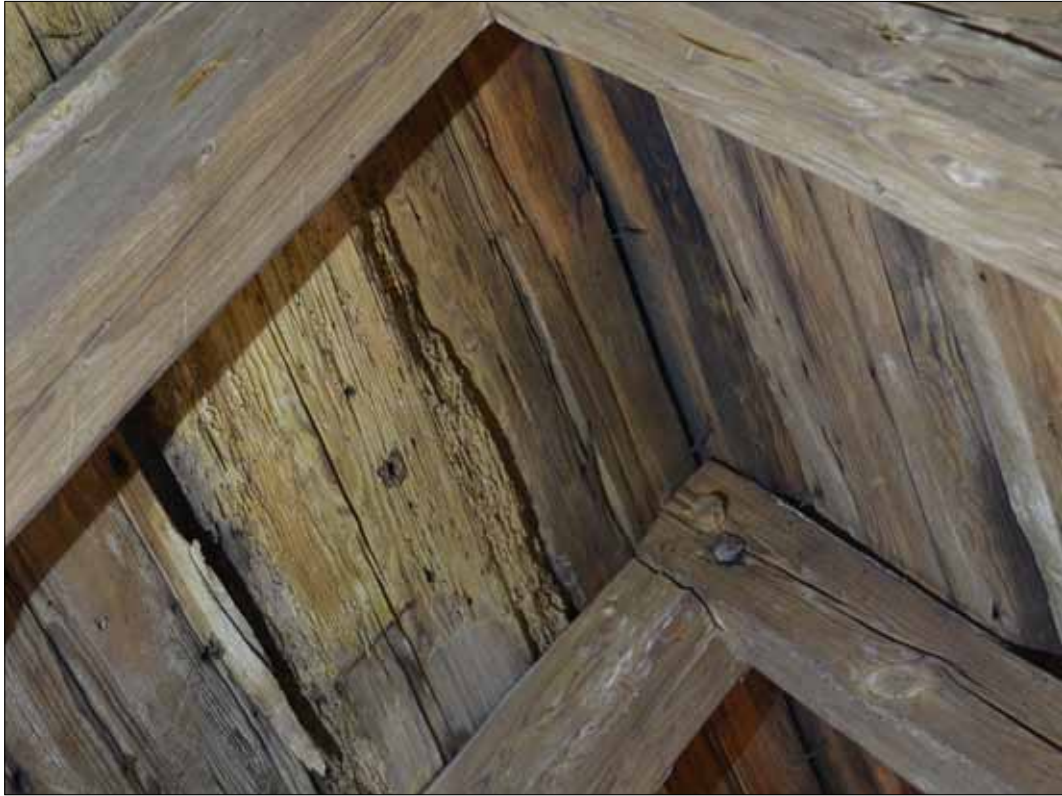
172 Nockmöte med smidd spik och dymling (SLM D2015-1471).
