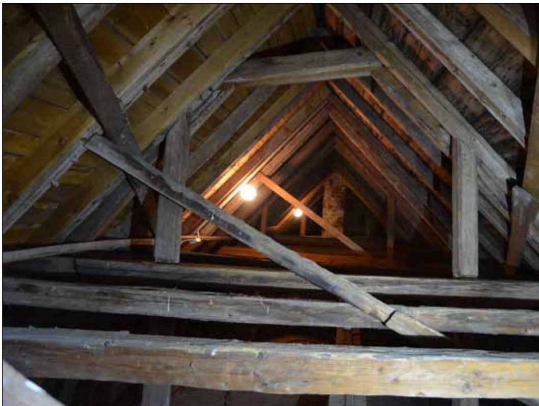
206 Långhusvinden sedd mot öster. Romanska högben med dymlingar för infästning av taktrö. (SLM D2015-1490).
