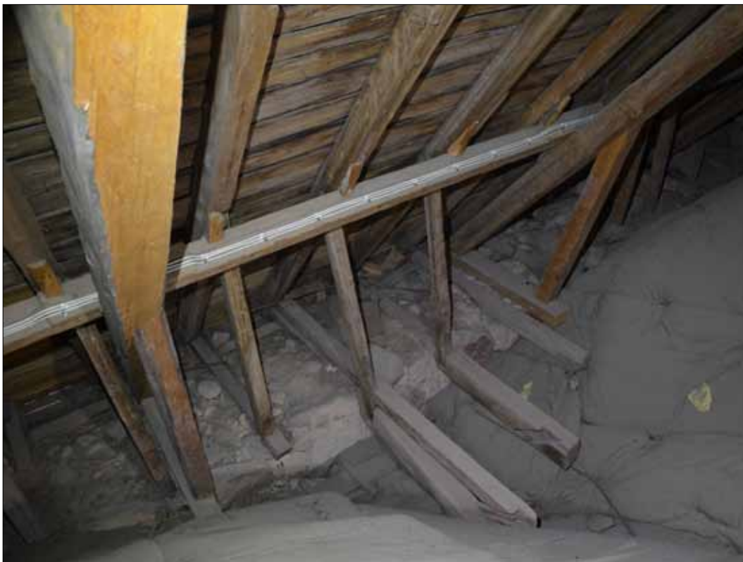
180 Avkapade bindbjälkar på norra sidan av långhusvinden (SLM D2015-1475).
