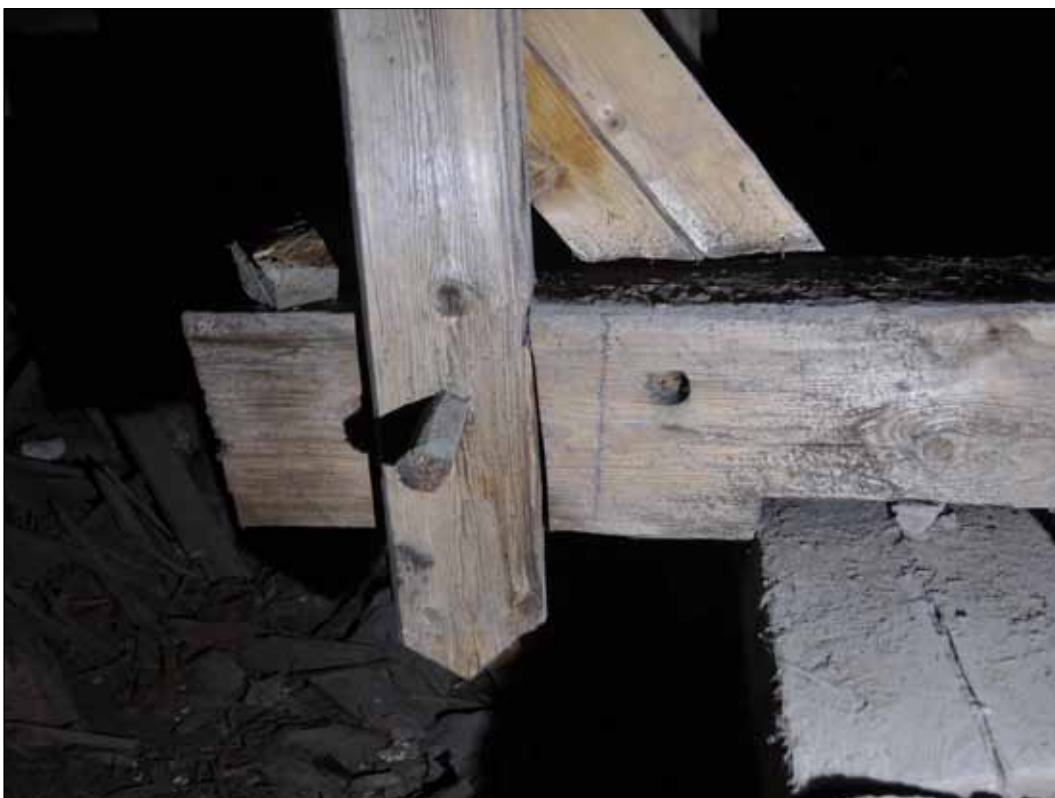
244 Rits och borrhål till höger om stödbenet. Tanken var tydligen att från början sätta stödbenet intill remstycket men av någon anledning ändrade man sig. En detalj som kan berätta något om processen vid tillverkning av en takstol (SLM D2015-1515). Foto: Daniel Eriksson
