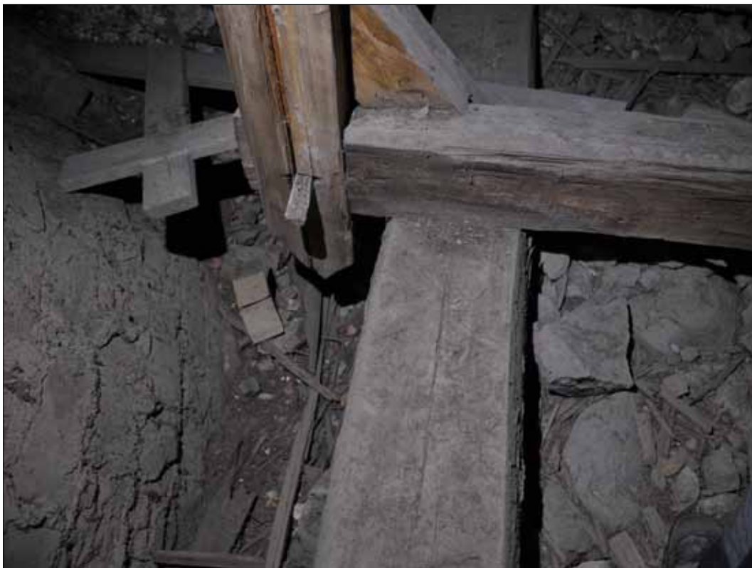
241 Mötet mellan stödben, tass och inre remstycke. Det inre remstycket har två sidor helt obearbetade (SLM D2015-1512). Foto: Daniel Eriksson.
