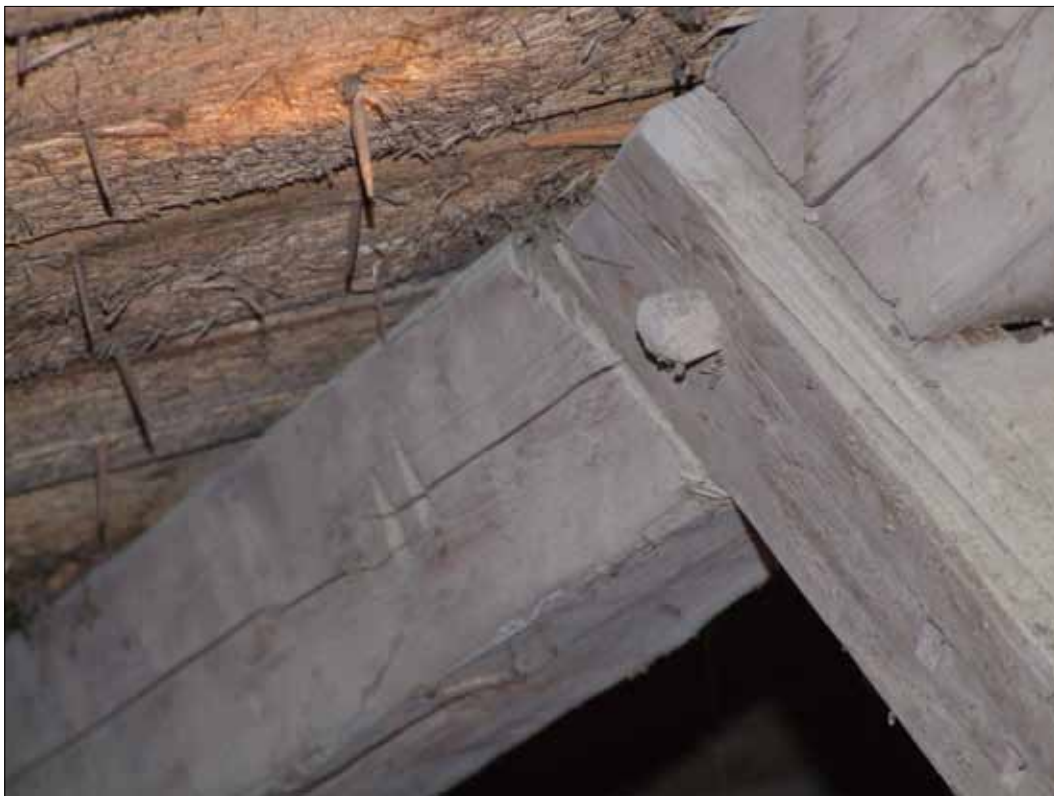
13 Takstolsdelarna är bilade och alla knutpunkter bladade halvt i halvt och dymlade samt har en enkel märkning. (SLM D2015-1370).
