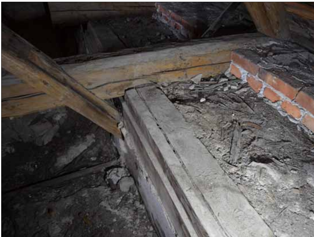
41 Inre remstycket med hylla in mot rummet (SLM D2015-1388).
