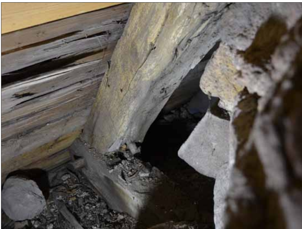
112 Högben och tass i anslutning till lpånghusets västgavel med sprättthuggen yta och fastdymlad spräck och bilad taktro (SLM D2015-1433).
