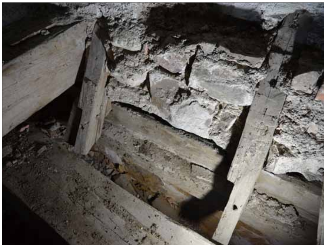
28 Rester av den tidigaste romanska modellen återfinns i långhusets södra mur, där sparrarna sticker ut utanför södra yttermuren, och som nu hamnar inne på Björksundskorets vind. (SLM D2015-1378).
