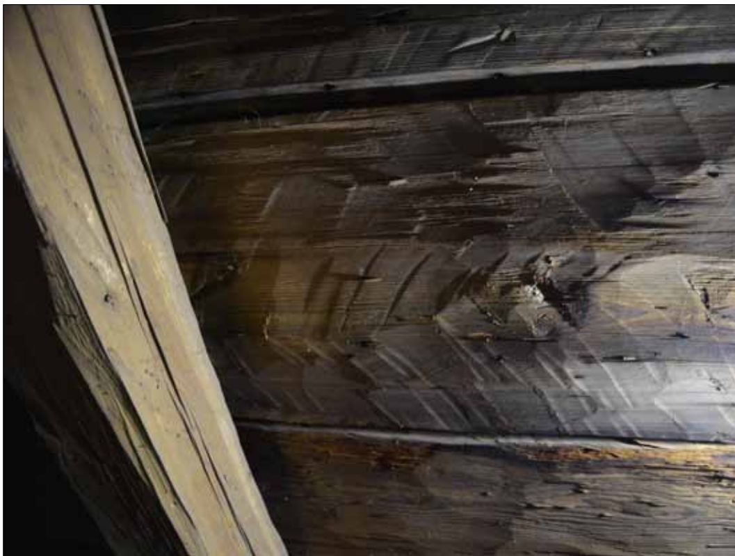
35 Vissa delar av taktron har en sprätthuggen yta. (SLM D2015-1383).
