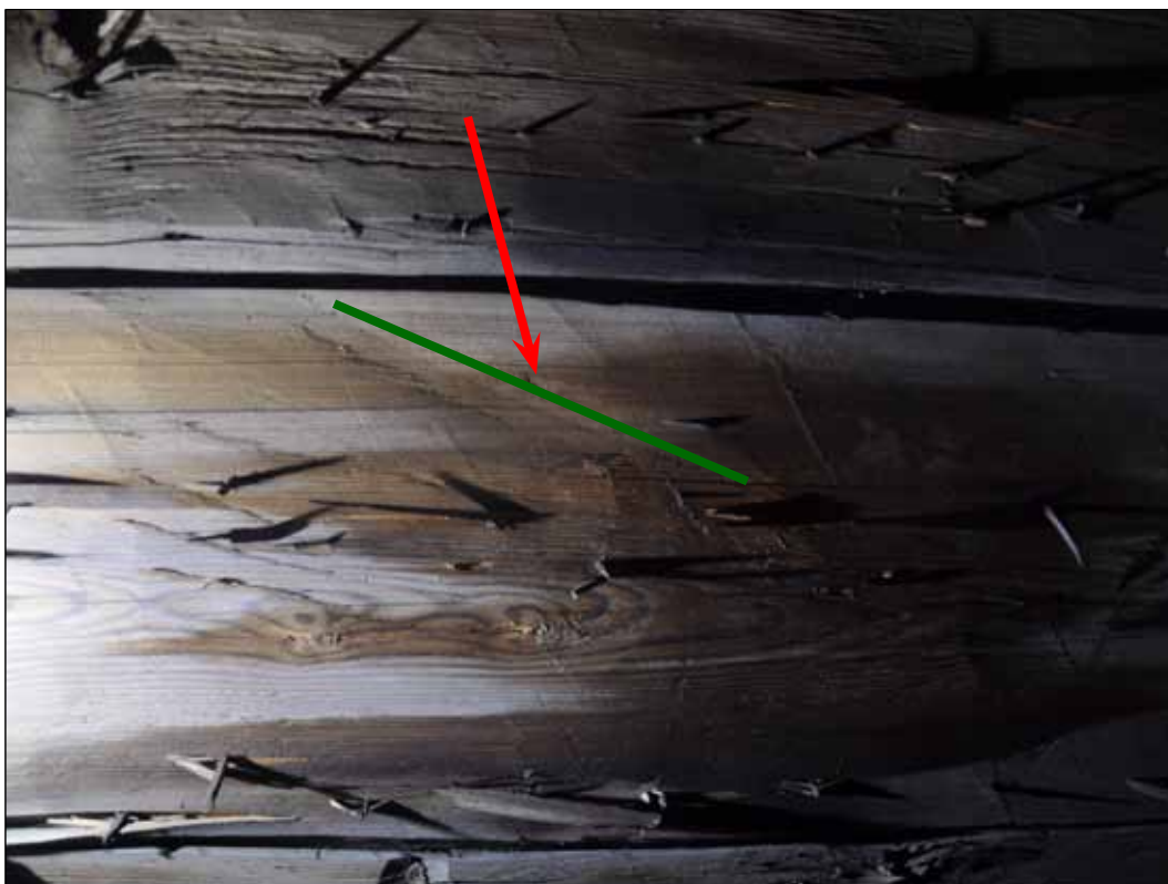
251 Taktro med spår av samma behuggnings teknik men spegelvänt. Taktron är med största sannolikhet samtida med taklaget. Det har alltså varit en vänster-och en högerhänt timmerman med samma typ av yxa eller en dubbelhänt timmerman (SLM D2015-1522). Foto: Daniel Eriksson.
