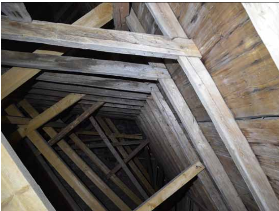
47 Mötet högben-hanbjälke är utfört som bladning med nacke (SLM D2015-1392).
