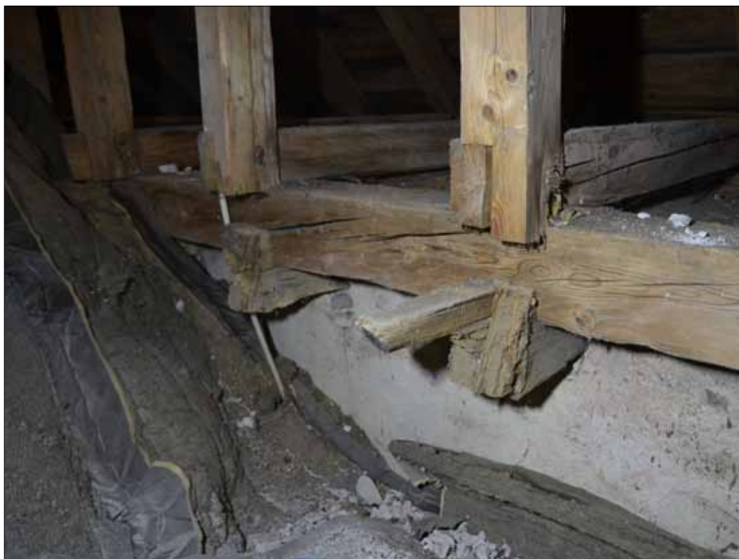
92 Takstolarna i långhuset vilar på dubbla remstycken som i sin tur vilar på resterna av den romanska takkonstruktionen. I bild syns de avkapade bindbjälkarna strax innanför det nuvarande inre remstycket och muren (SLM D2015-1420).
