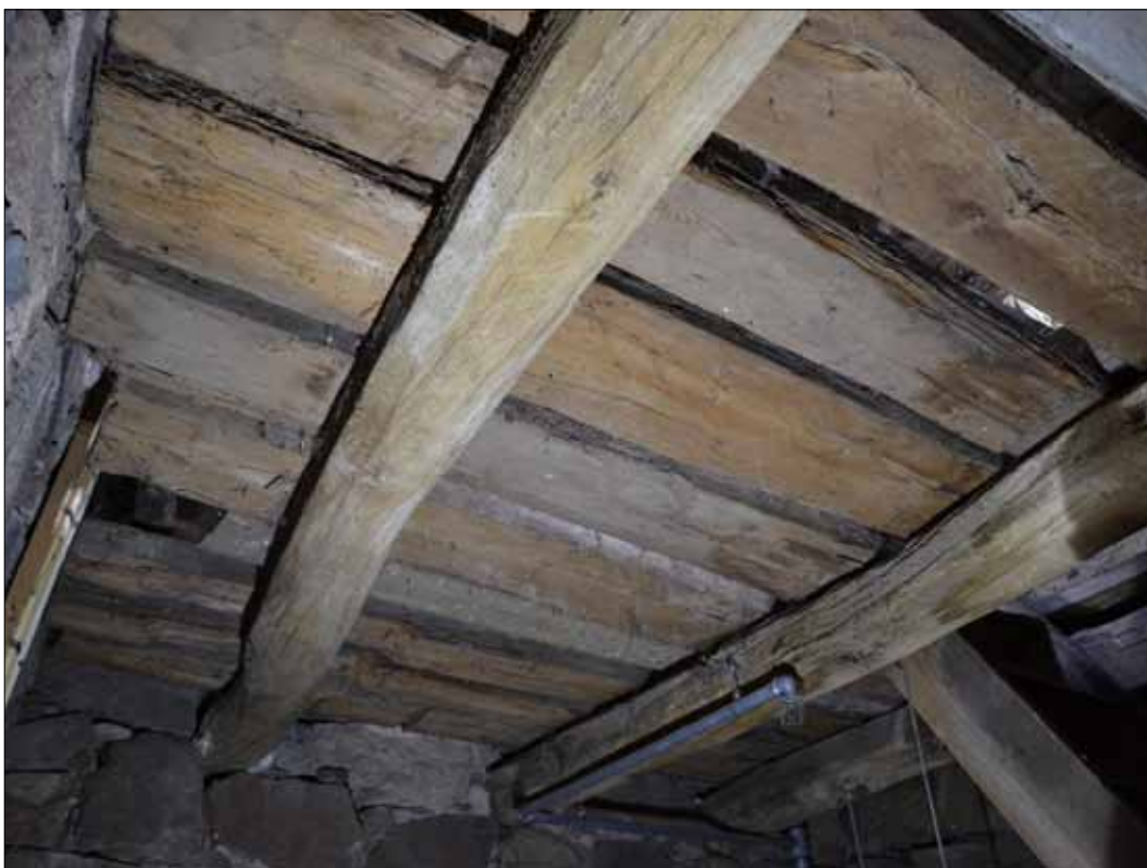
113 Bjälke som vid bearbetningen fått behålla sin krokvuxna form (SLM D2015-1434).
