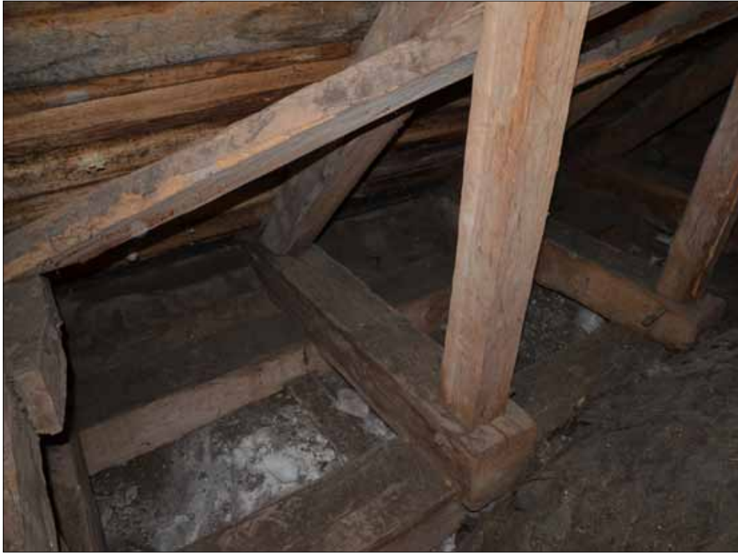
83 Dagens knäbockskonstruktion (SLM D2015-1418).
