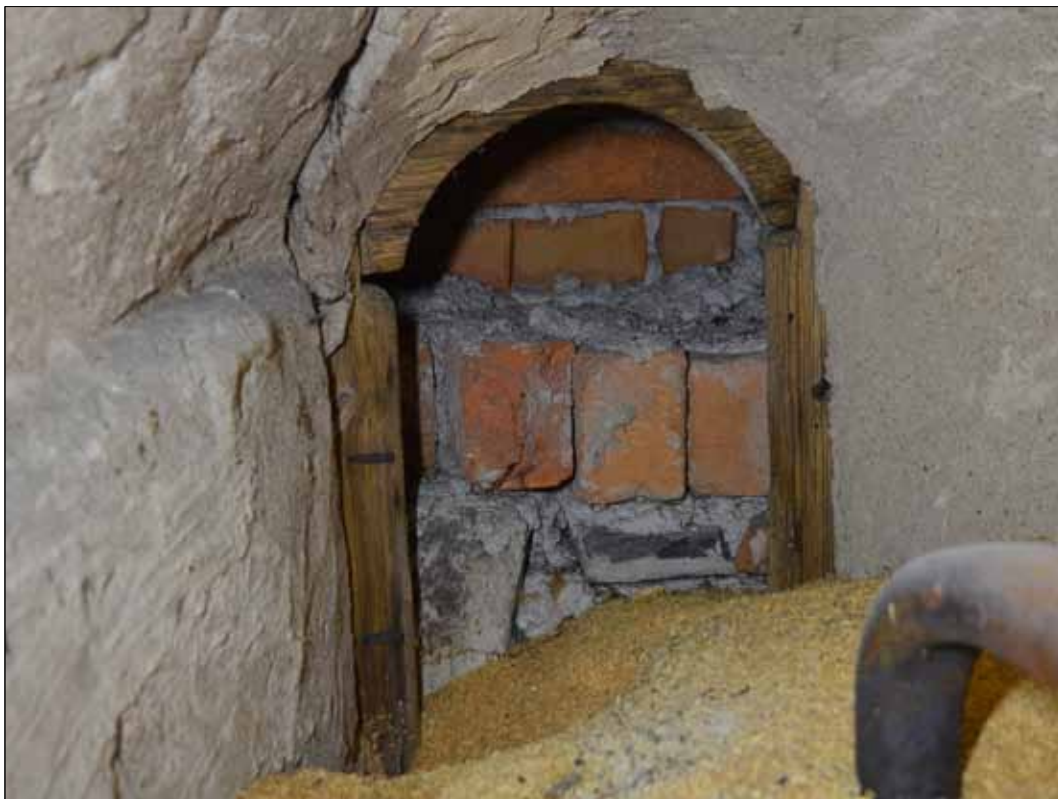
98 Romanskt fönster i långhusväggen på vapenhusets vind. (SLM D2015-1425).
