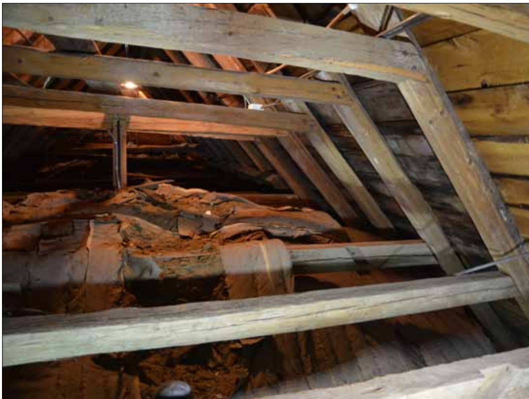
34 Långhusvindens 19 takstolar är eftermedeltida men delar från en romansk takkonstruktion har återanvänts vid uppsättningen (SLM D2015-1382).
