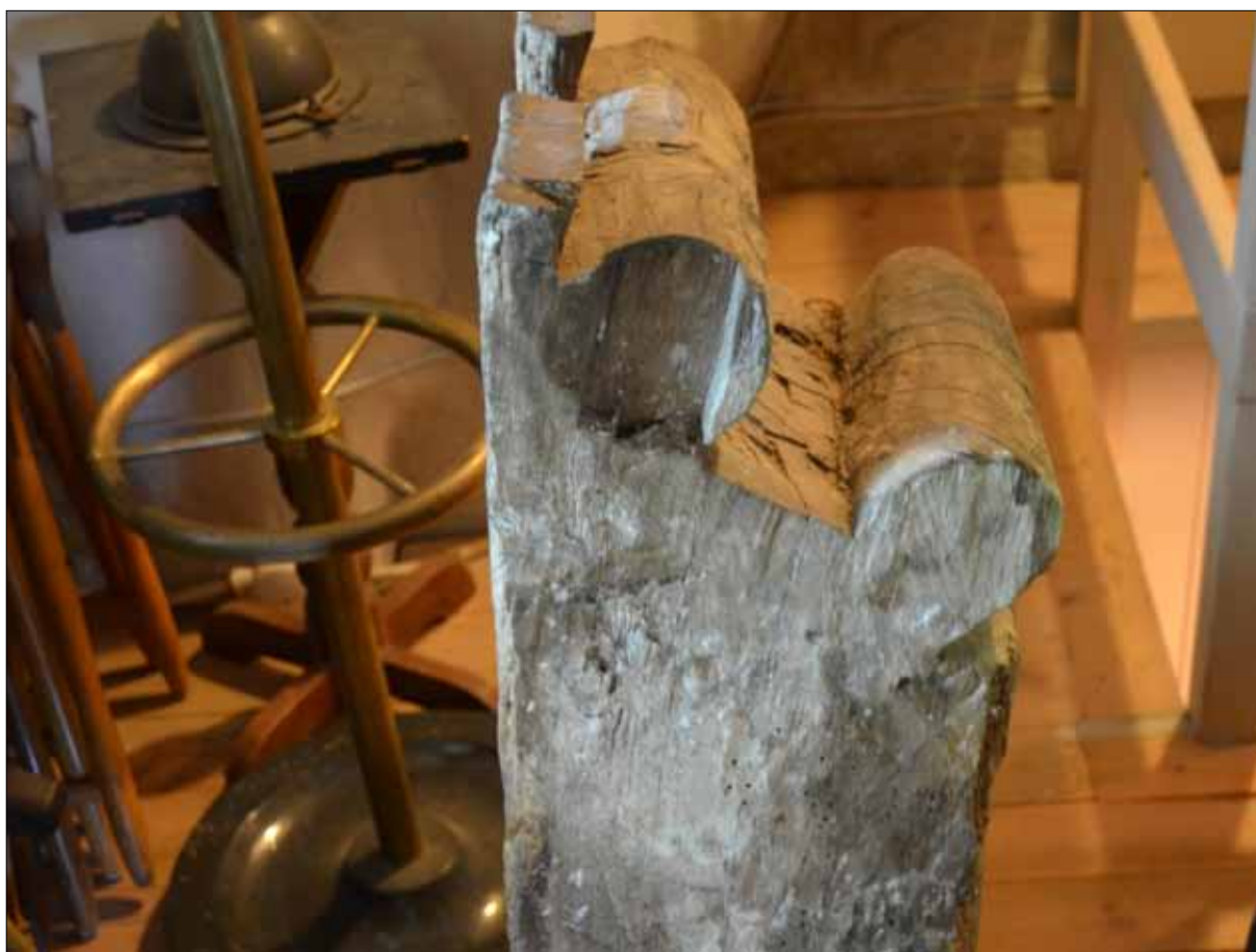
125 Detalj av nedplockad valvkonsole (SLM D2015-1442).
