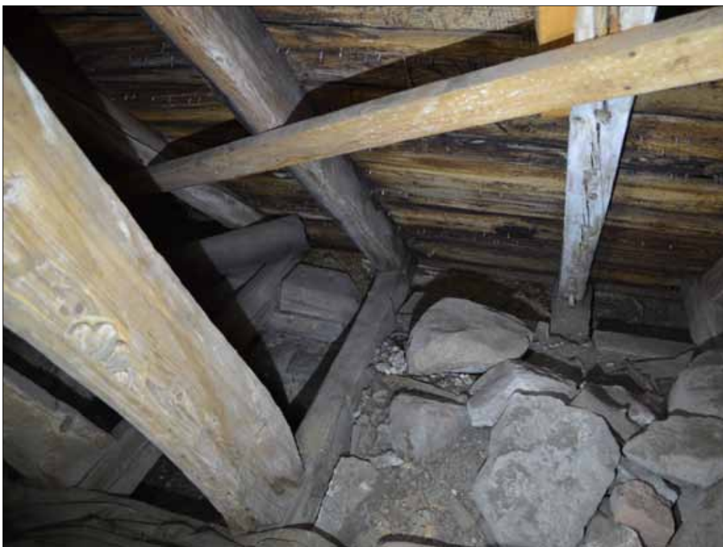
207 Sista högbenet i den romanska takkonstruktionen och första takstolen för tunnvalvet över långhusets södra murkrön (SLM D2015-1491).
