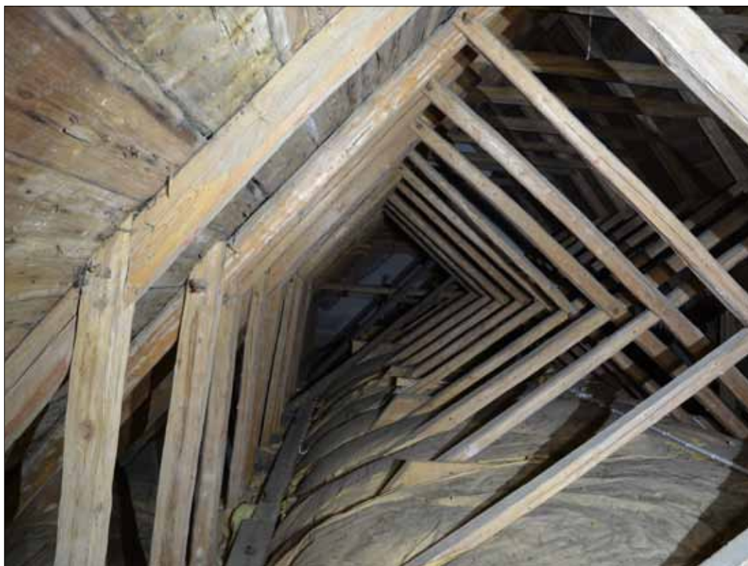
146 Möte stödben-högben med raka bladningar (SLM D2015-1454).
