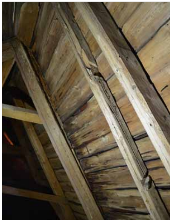
168 Sprätthugget äldre högben med urtag. Hela taktron spräckt, bilad och bördad (SLM D2015-1469).
