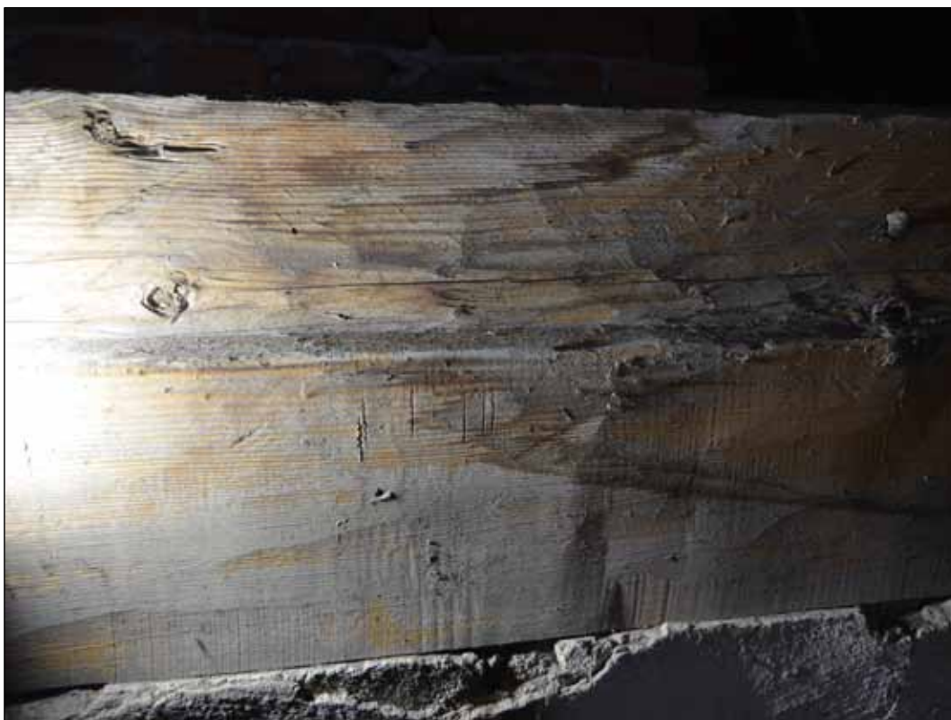
42 Inre remstycket har tydliga spår efter bearbetning med skave. (SLM D2015-1389).
