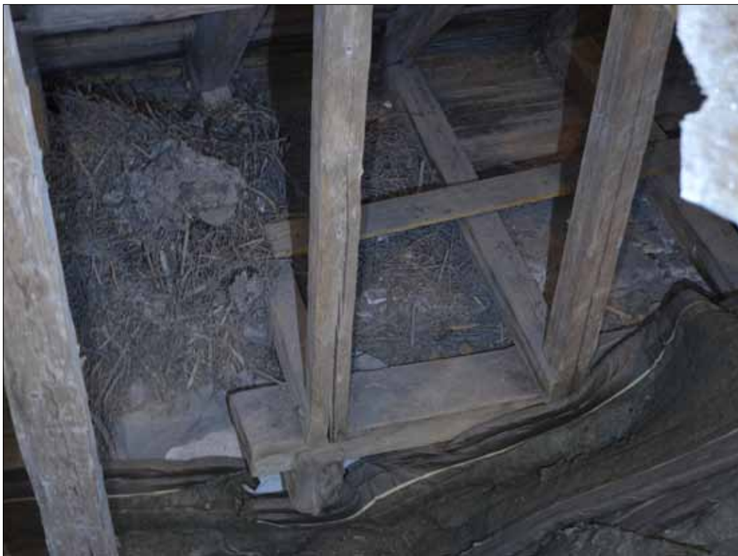
97 Inre remstyckets avslut mot 1700-talsutbyggnaden i väster (SLM D2015-1424).
