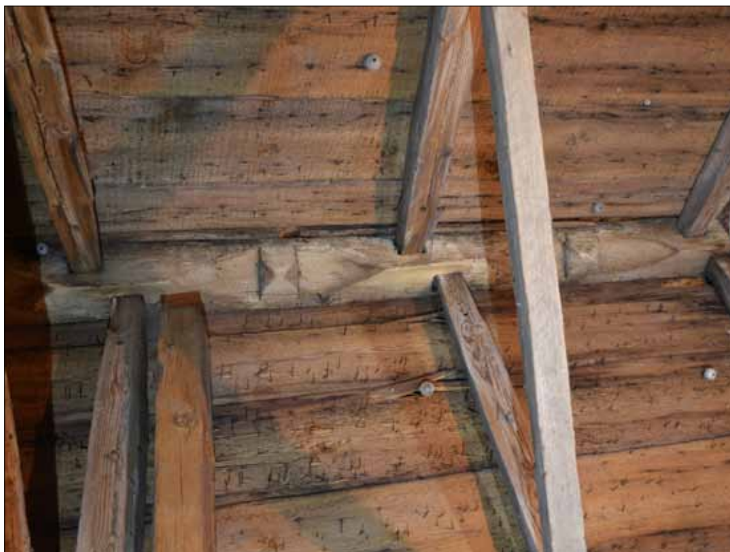
104 Över långhuset och koret står 22 takstolar. De första 11 takstolarna från väster är romanska med sprätthuggna högben som är infällda i en profilhuggennockås (SLM D2015-1427).
