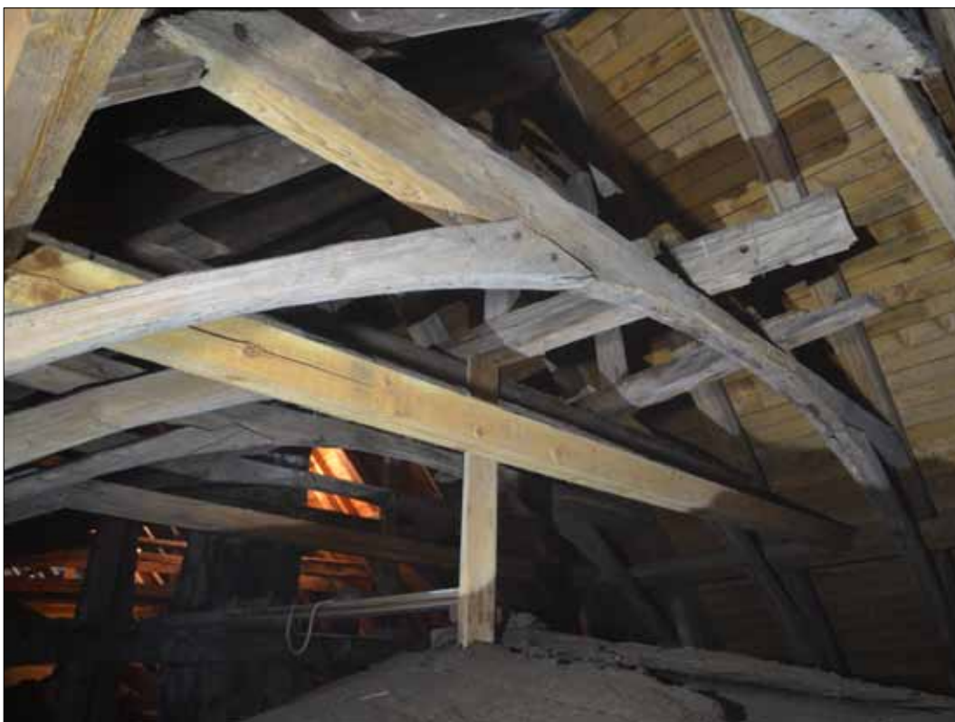
208 Tunnvalvstakstolen sedd mot öster. (SLM D2015-1492).
