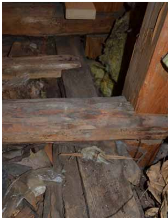
222 Över den norra muren finns ett inre remstycke av ek med hyllor på båda sidor och med urtag för bindbjälkar. (SLM D2015-1503).
