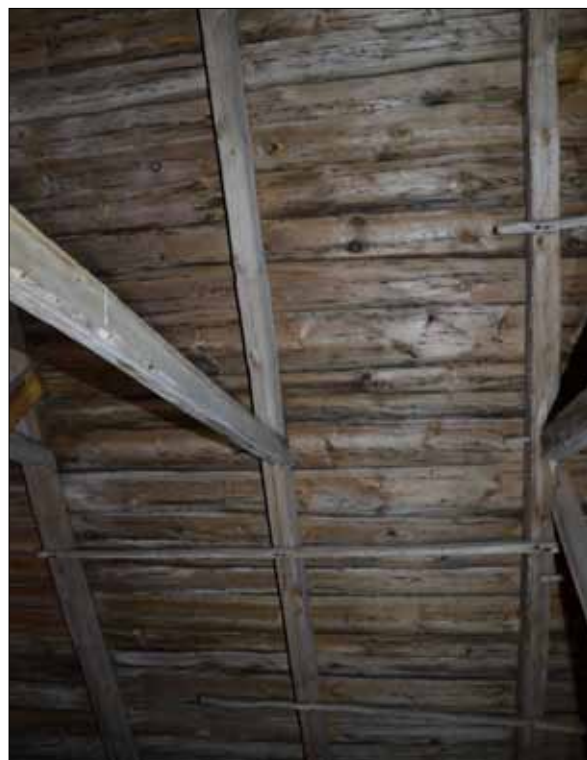
186 Norra takfallet på långhusvinden. Rikligt med sidoförstävningar av rundvirke (SLM D2015-1480).
