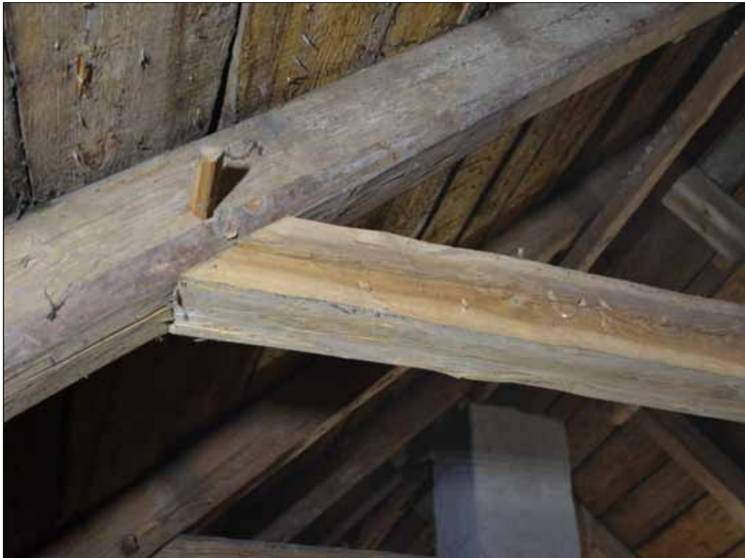
84 Timmermansmärkning i form av flaggor i mötet mellan högben och hanbjölke. (SLM D2015-1419).
