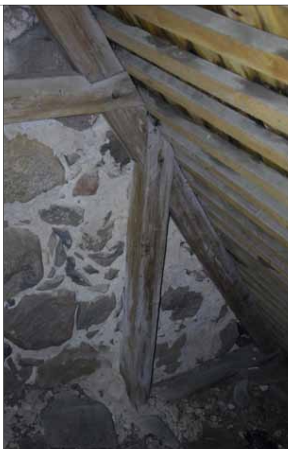
235 Knäbocken mot sakristians norra gavel, takstol nr1 (SLM D2015-1509).
