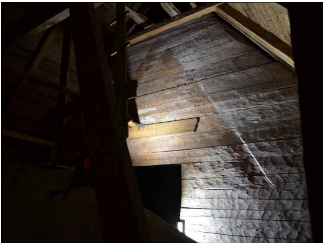
133 Det ursprungliga långhusets östra gavelröste är timrat. På röstets östra sida ser man det anslutande lägre och smalare äldre kortaket avteckna sig, för det norra takfallet har ett spår även huggits i timmerytan ( SLM D2015-1446).
