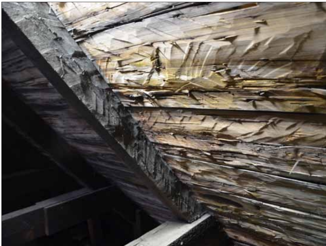
121 Trobrädorna är bilade och bördade, vissa brädor är sprätthuggna (SLM D2015-1439).
