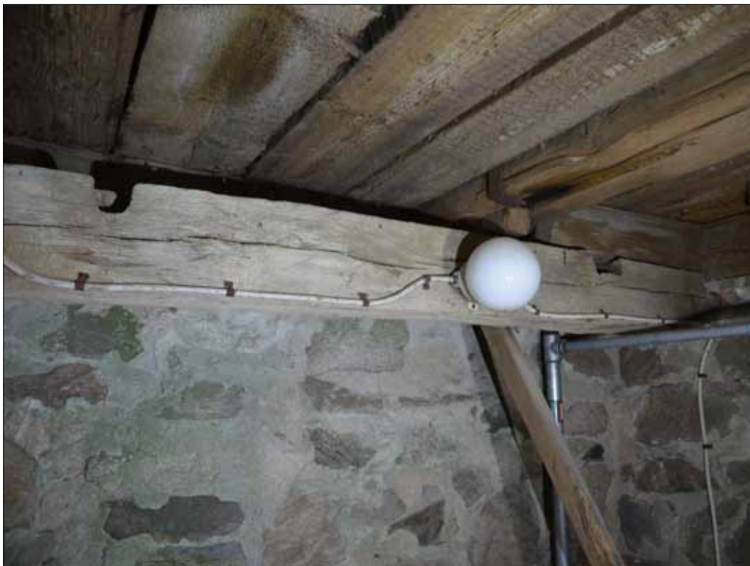
114 Bjälke med urtag för klockaxel (SLM D2015-1435).
