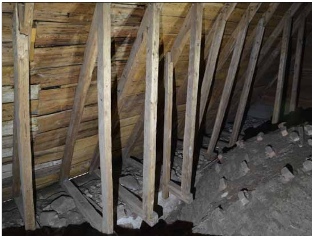
132 Takstolarna över långhusets västra del är av medeltida konstruktion men ombyggda efter valven som slogs 1609. Bindbjälkarna kapades då med yxa och på merparten av takstolarna ändrades även stödbenens vinkel för att ge plats åt valven (SLM D2015-1445).
