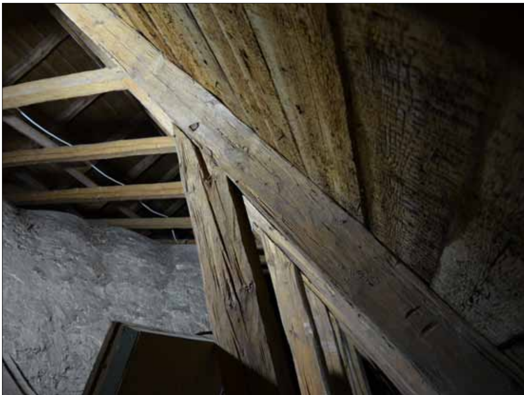
73 Enkel märkning i form av streck på högbenet (SLM D2015-1410).
