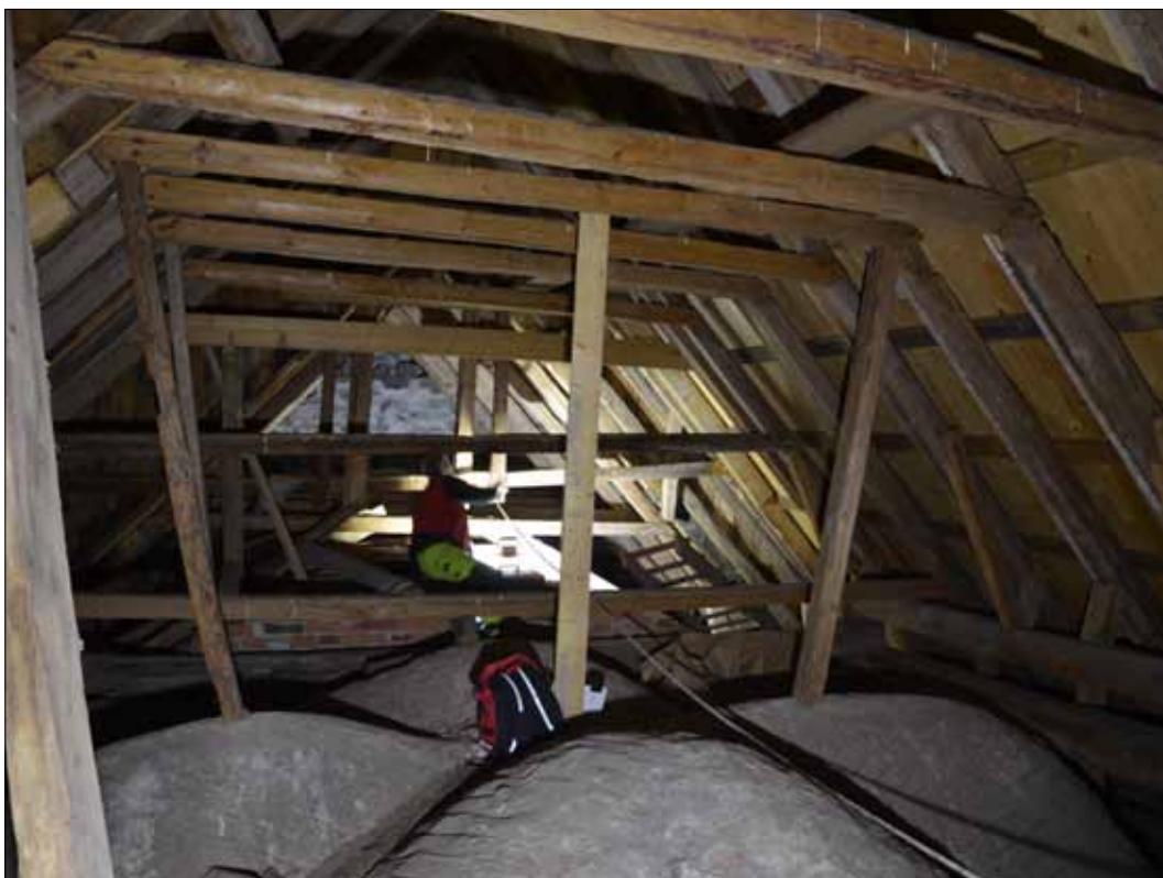
140 Långhusets taklag sett mot öster (SLM D2015-1450).
