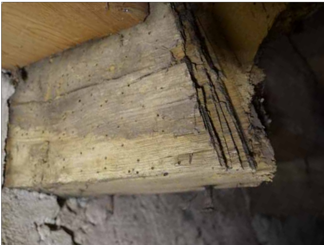
94 Avkapad bindbjälke med smidd spik från äldre plant innertak (SLM D2015-1421).
