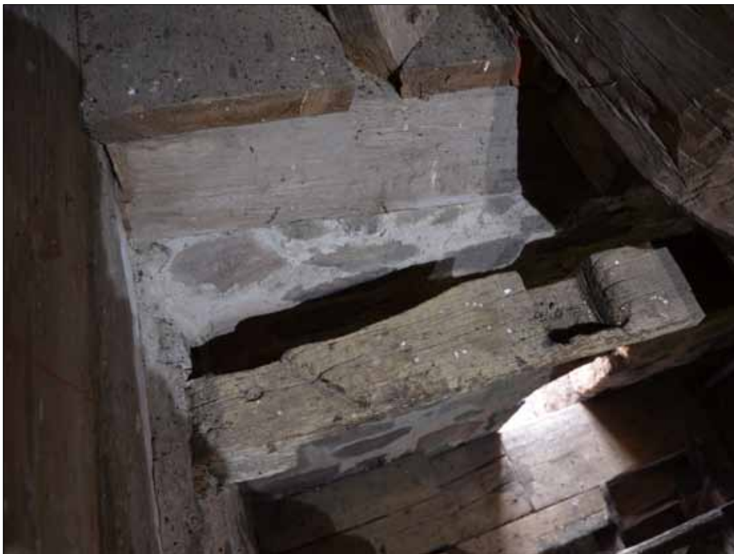
115 Bjälke med urtag vid uppgången till klockvåningen (SLM D2015-1436).
