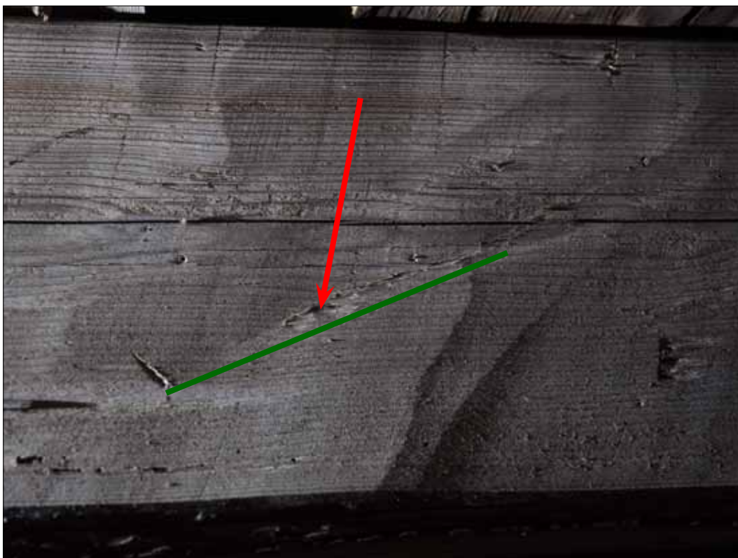
250 Exempel på huggspår från ett högben. Grön=yxans rörelseriktning i veden. Röd=eggens vinkel i förhållande till rörelseriktningen. Det ser ut som att timmermannen haft en yxa med överställt skaft och arbetat sig framåt (SLM D2015-1521). Foto: Daniel Eriksson.
