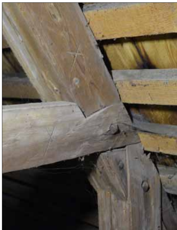
233 Timmermansmärken vid möte mellan hanbjälke och högben (SLM D2015-1508).
