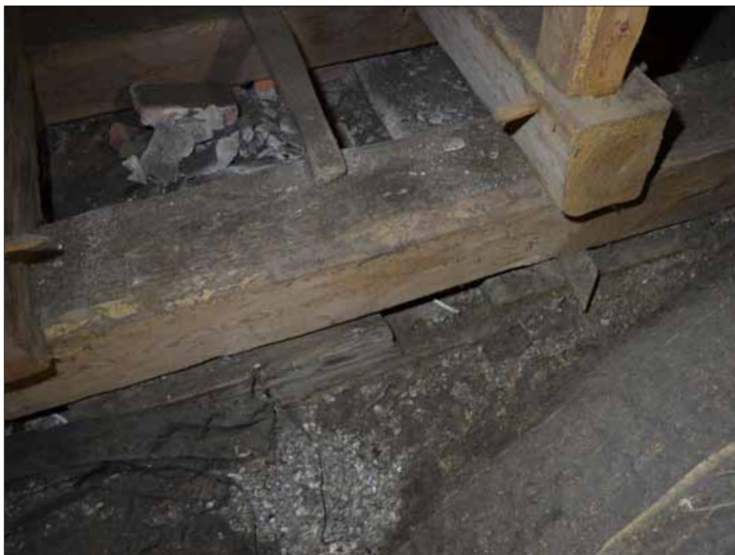
82 Dagens remstycke vilar delvis på äldre remstycke med hylla in mot kyrkorummet (SLM D2015-1417).
