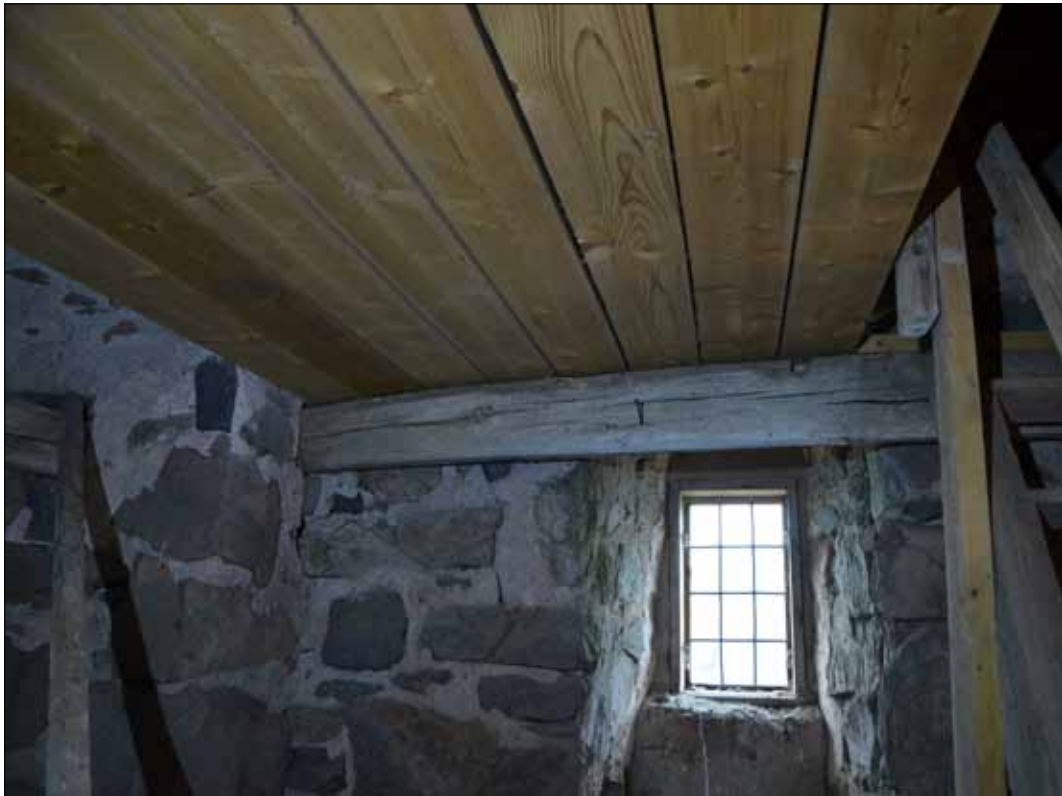
173 Bjälke i tornet med urtag för axel (SLM D2015-1472).
