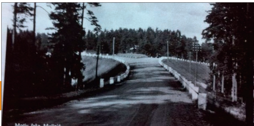
Infarten till Mullsjö söder ifrån mot viadukten.
