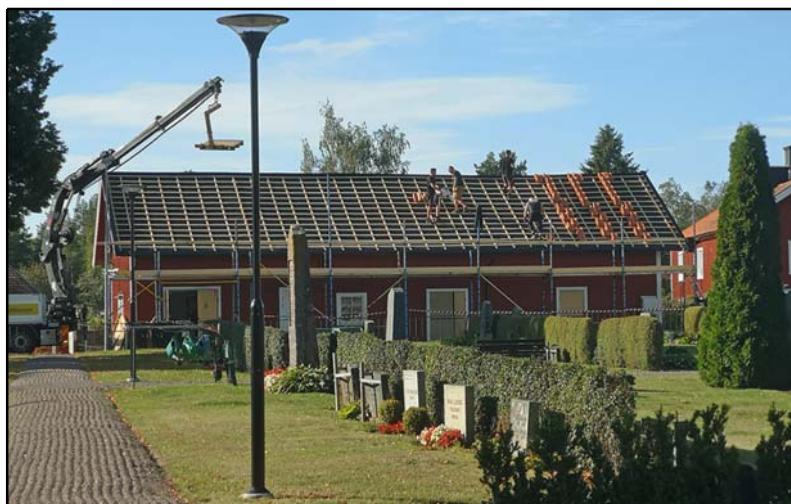
Takrenoveringen pågår för fullt av förrådsbyggnaden i Mogata. Foto: Kent Käfling
