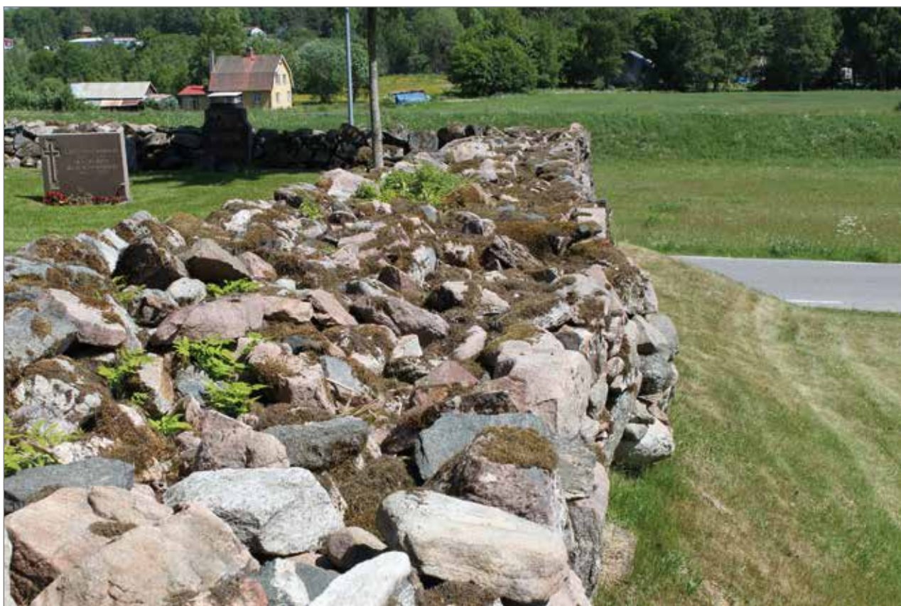
Delar av kyrkogårdsmuren har rasat på den sydöstra sidan. Foto Karin Lundberg.
