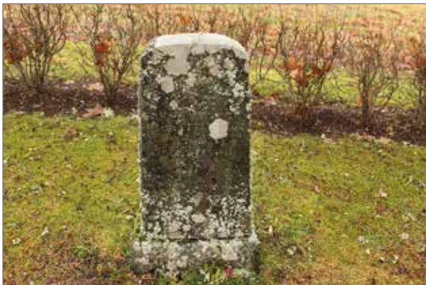
Kraftigt lavangripen sten gravnummer 46/G. Lavar som dessa är svåra att få bort på djupet utan att stenen skadas. Foto Karin Lundberg.
