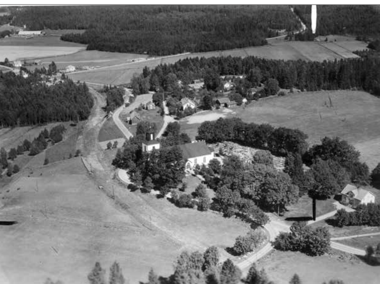
På flygfotot från 1947 över Gällstad så är väg 157 på gång att byggas.
