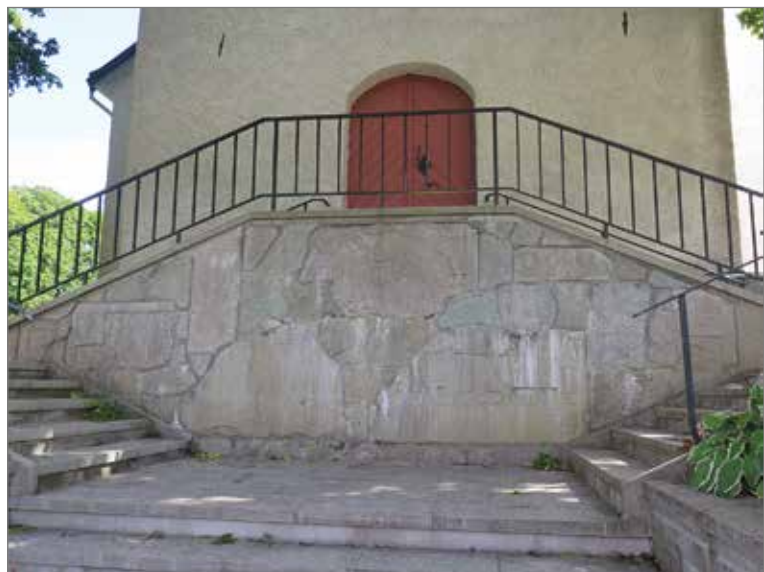
Gravhällar som är inmurade i trappan i väster
