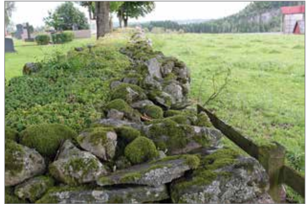
Några stenar ur muren på den sydvästra sidan har tryckts ut till följd av att trädens rotsystem trycker på. Foto: Karin Lundgren.
