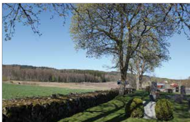
Kallmuren söder om Brunns kyrka härstammar sannolikt från slutet av 1800-talet. För att ändra eller renovera denna mur krävs tillstånd från Länsstyrelsen. Foto: Karin Lundberg.
