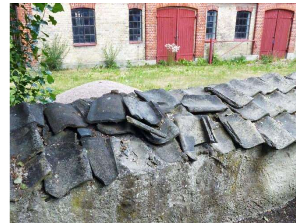
Skador i avtäckningen på norra muren.
