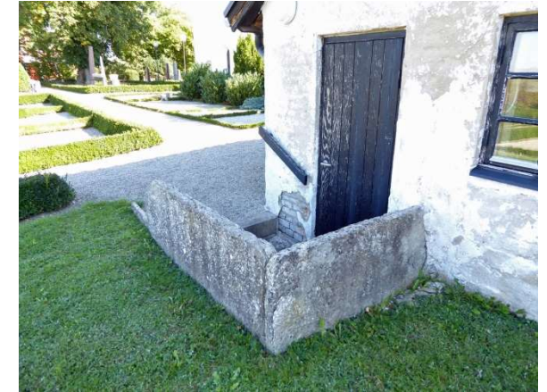
Äldre gravhällar vid redskapsbodens gavel, som också har problem med fukt och putsbortfall.
