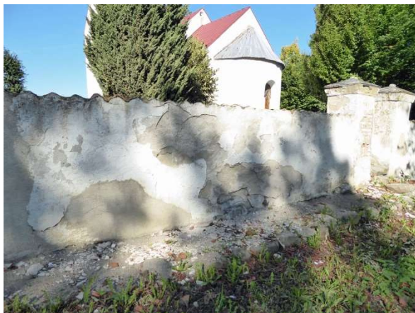
Problem på östra delen av kyrkogårdsmuren.
