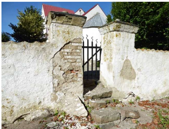
Östra grindpelarna bör ses över snarast.
