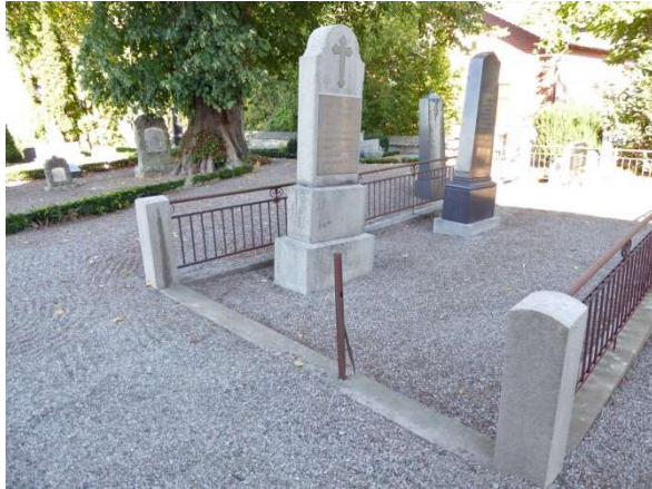
På gravplats VII:2 saknas en del av järnstaketet och resterande delar rostas.
