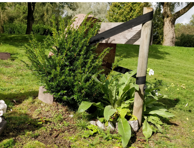
När gravstenens förankring inte lever upp till de krav som finns säkras de upp med hjälp av en päl och spännband. Därefter kontaktas gravrättsinnehavaren som uppmanas att åtgärda stenen.
