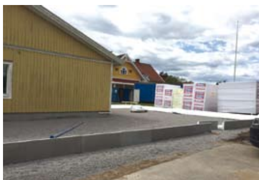
Senapskornets tillbyggnad har påbörjats.
