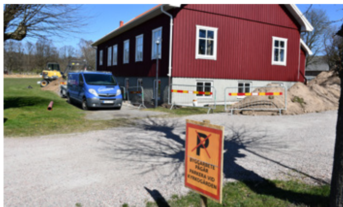
Ingen parkering vid församlingshemmet i Getinge medan renoveringsarbetet pågår.
