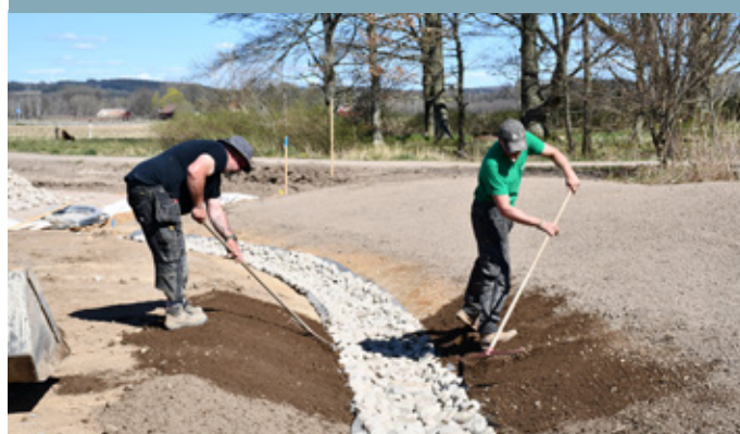
Anläggning av bäckfåra för dagvatten på den nya delen av Enslövs kyrkogård.
