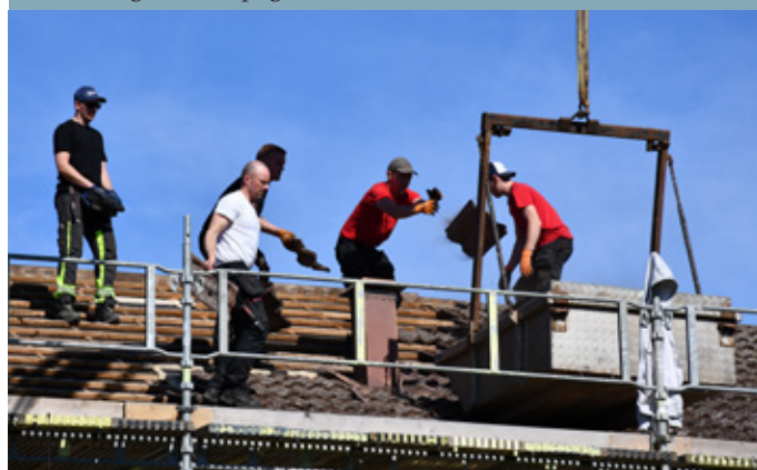
Bort med det gamla taket i Enslöv för att ge plats för det nya.
