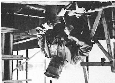
Arne Sjölén i arbete inne i det blivande trapphuset, som byggs till gamla Församlingshemmet.
