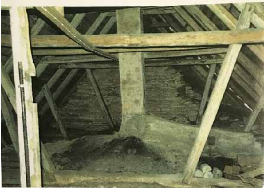
Långhusets taklag sett från väster. I grunden är det sannolikt senmedeltida, antingen samtida med valvslagningen eller utfört efter danskarnas härjning.
