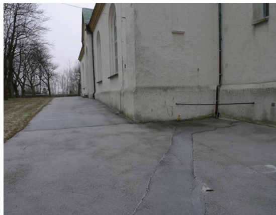
Ovan: Lappad asfaltsbeläggning.
