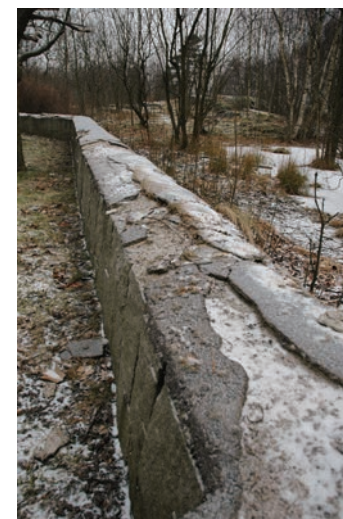
Överst: Äldsta muren kalvar kraftigt. Mellan: Sten faller ur vid smygväg mot öst. Nederst: Cement ovanpå granitmur kraftigt skadad.
