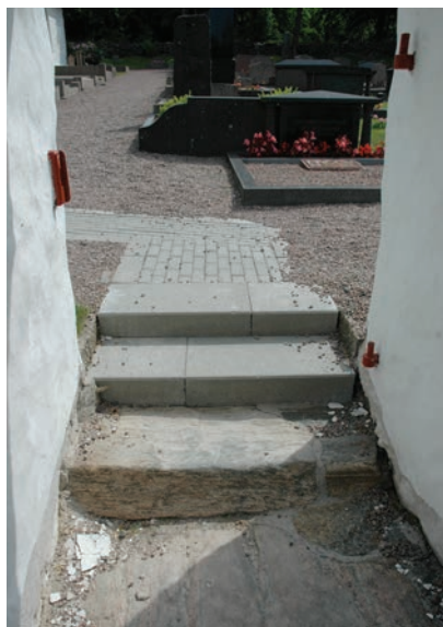
I trappan precis vid västra stigporten har ett trappsteg i granit kompletterats med två steg i betong.
