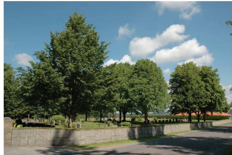
Muren längs landsvägen vid nya kyrkogården.
