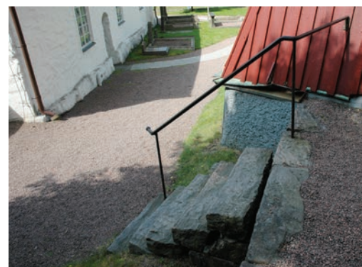
Delar av den naturstenstrappa som leder upp över muren i nordöstra hörnet, vid klockstapeln. Nedre delen är försedd med äldre smidesräcke, medan de två övre trappdelarna har fått ett nyare räcke i svartlackerad metall.
