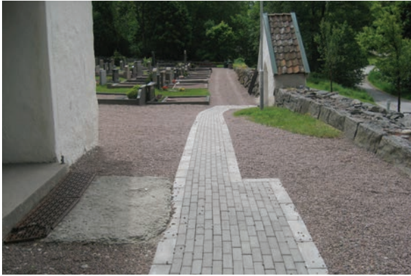
Stråket av markbetong som gjorts i grusytorna.
