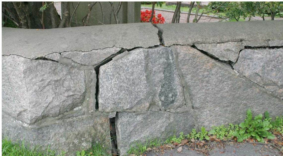
Det finns mindre sprickor i muren. Vid framtida utvecklingsarbete bör betongöverdraget avlägsnas.
