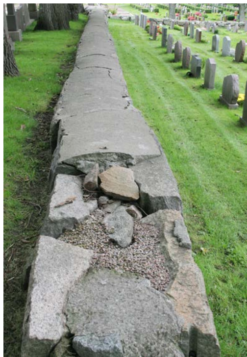
En skada i muren som sträcker sig längs den äldre kyrkogårdens västra del. Här finns även mindre sprickor i betongöverdraget.
