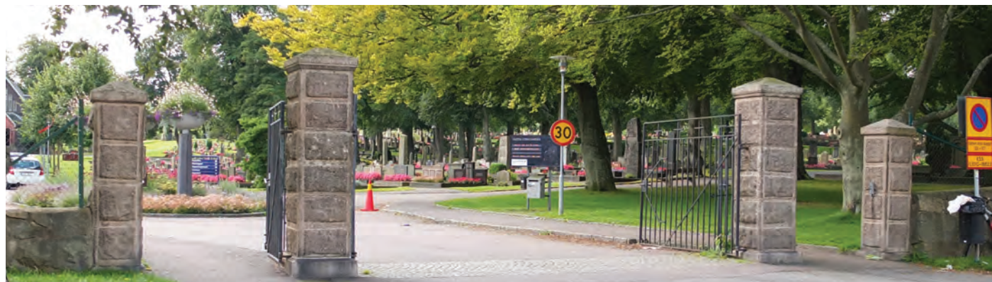
Figur 098. Huvudentrén till gamla delen är anlagd 1901, med dubbla grindstolpar.
