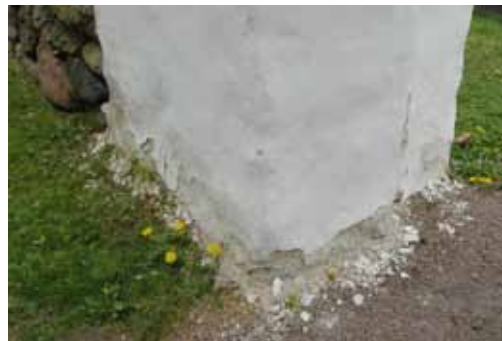
Puts- och färgbortfall på stigport.
