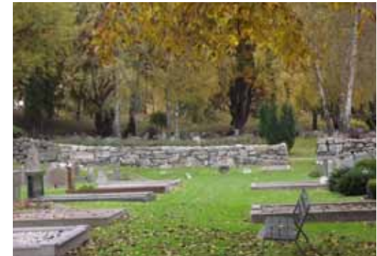
Delar av muren i norr är omlagd.
