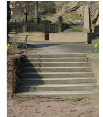
Trappa i natursten avgränsar stensmjöl och asfalt, nr 1 illustrationen.
