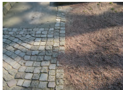
Materialmöte öster om kyrkan; asfalt, smågatsten och en grusstyp som bara finns här på kyrkogården.
