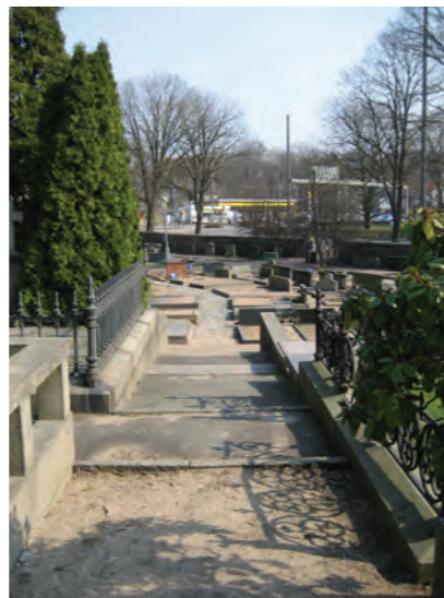
Gång med blandade beläggningsmaterial, stensmjöl och inslag av asfalt.
