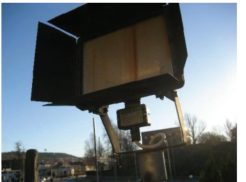
B + G och strålkastare bestyckas med 500 eller 1000W halogenglödlampa
