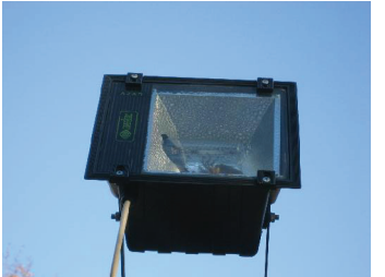
Strålkastare kan bestyckas med metallhalogen
