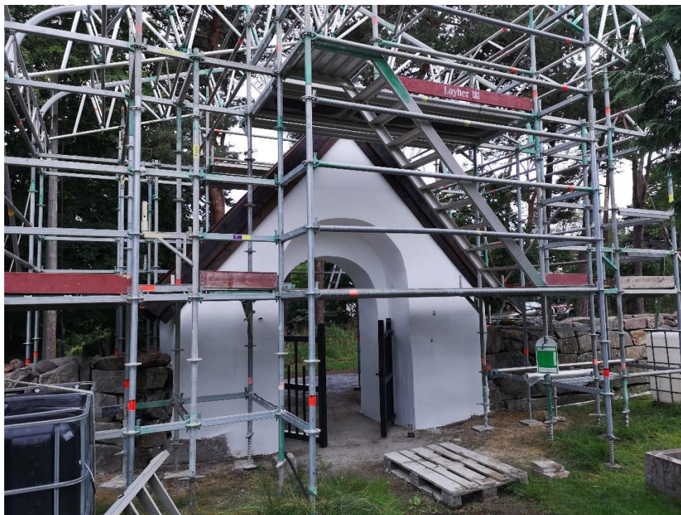
Efter färdigställande, före ställningsrivning.
