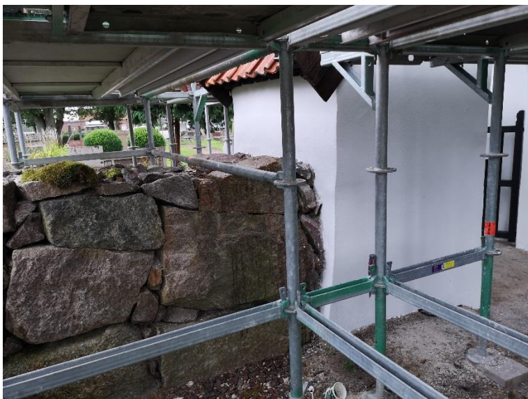
Anslutning mot befintlig kyrkogårdsmur.
