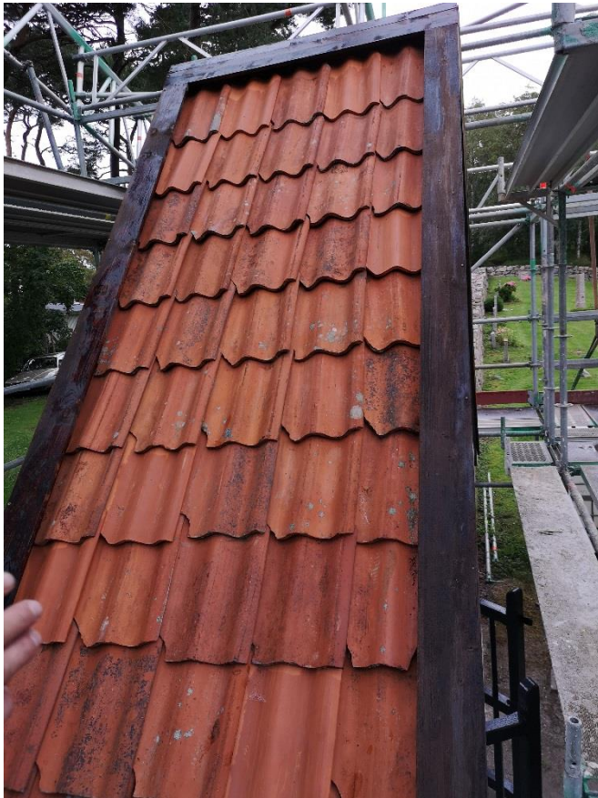
Omlagd avtäckning samt tjärade vindskivor.
