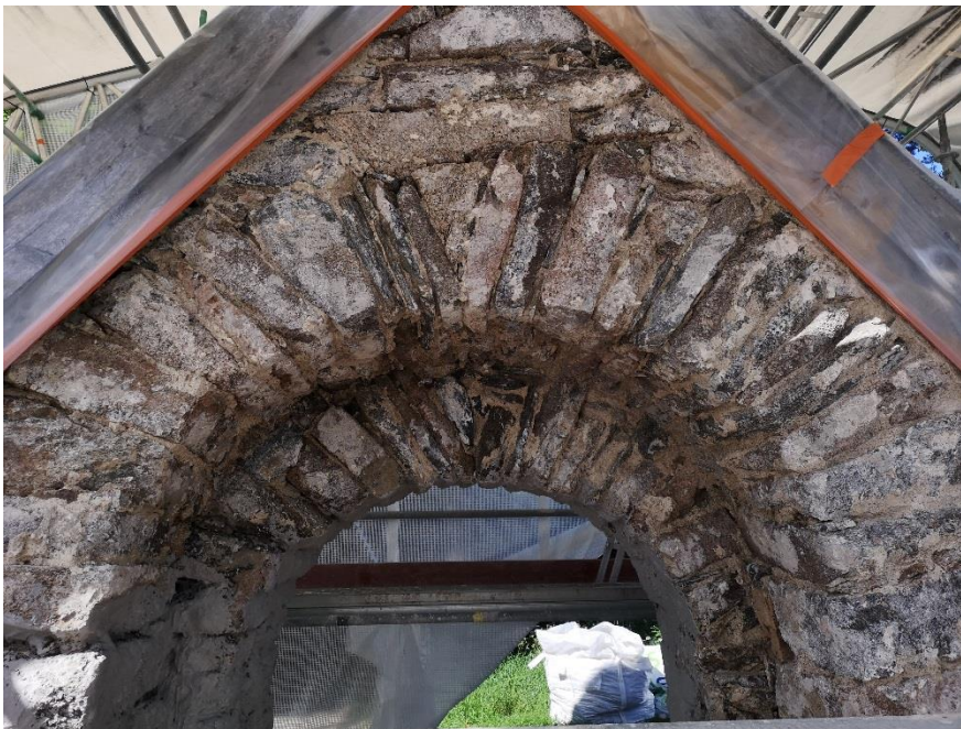
Frilagt murverk efter rivning av puts.
