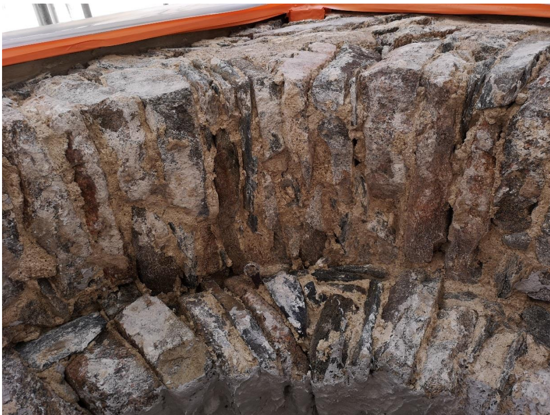
Valv efter friläggning. Murverken var generellt i bra skick.
