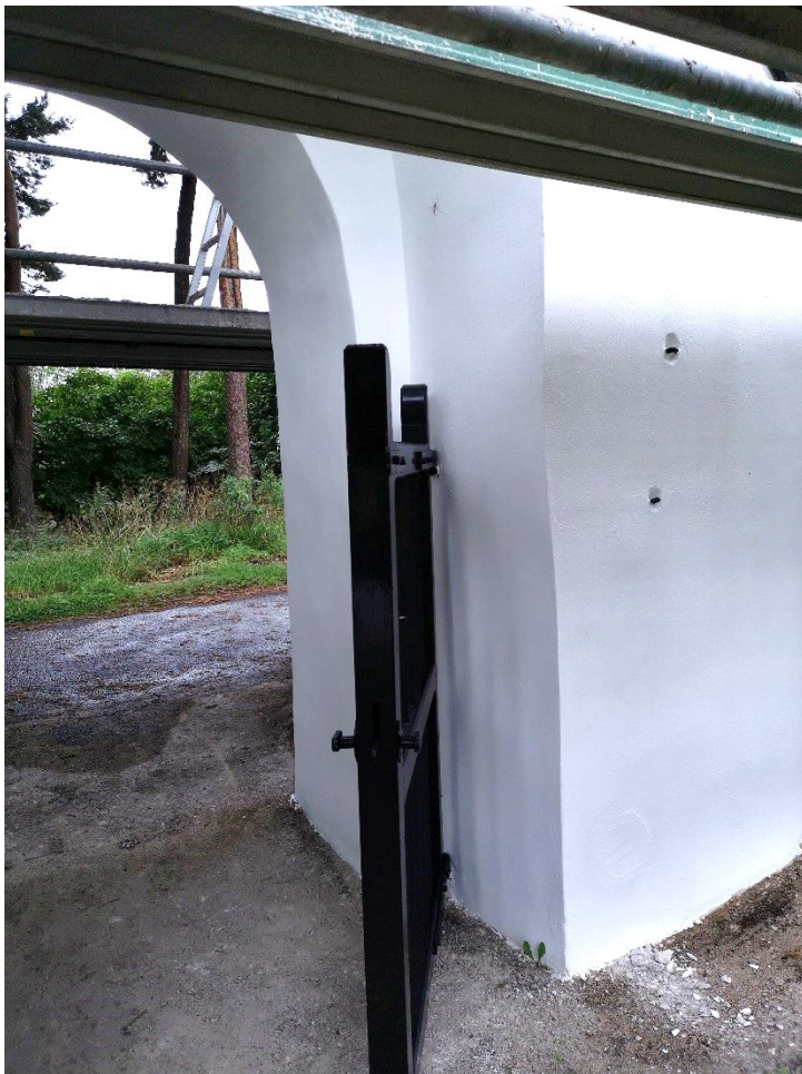
Efter färdigställande men före ställningsrivning.
