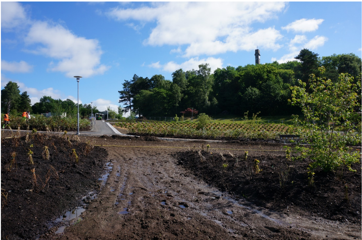
Foto taget med utblick över nordöstra delen av området, då stora delar av planteringsarbetet var klart. Arbetet med vägar var vid tillfället pågående.
