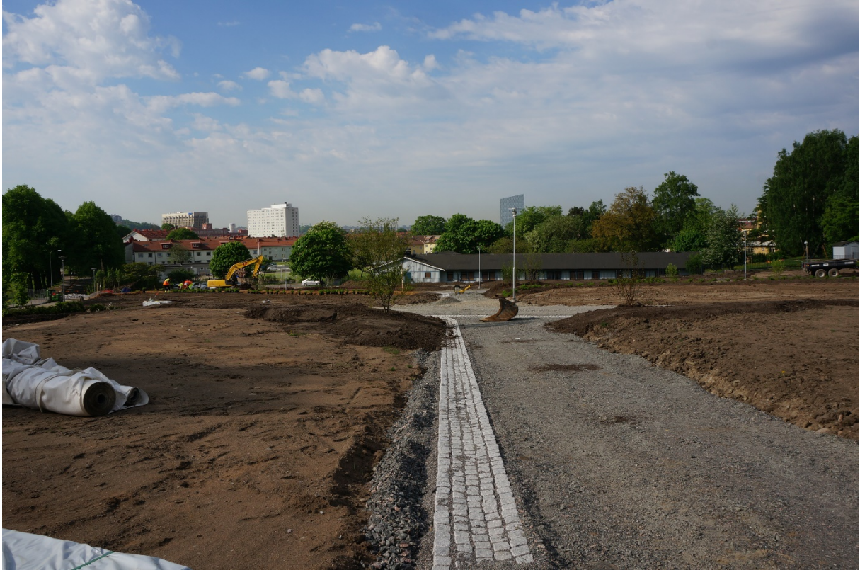
Utblick mot sydväst, vägar och gravfält anläggs. Vägar kantas med smågatsten.
