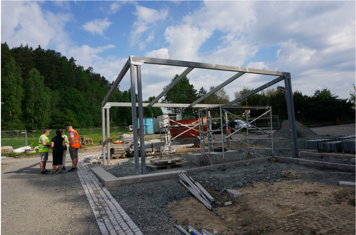
Ceremoniplatsen med skärmtaket under uppförande.
