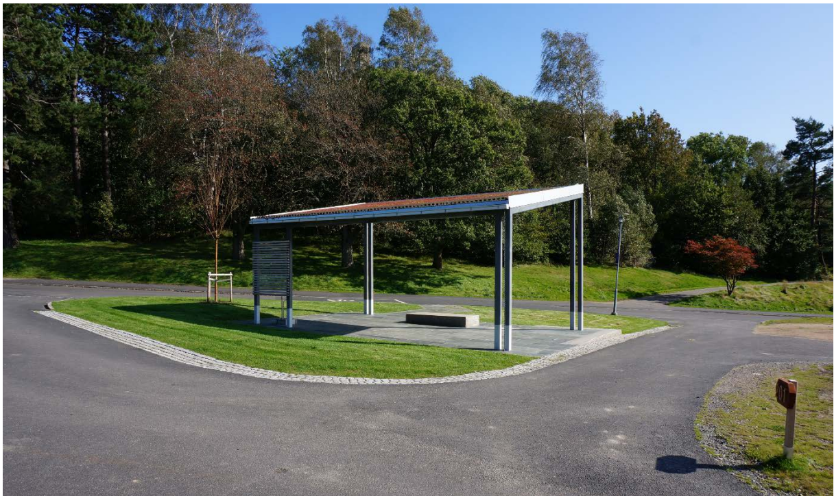
Det färdigställda skärmtaket, från nordväst. Takets sedumtäckning är synlig från denna vinkel.
