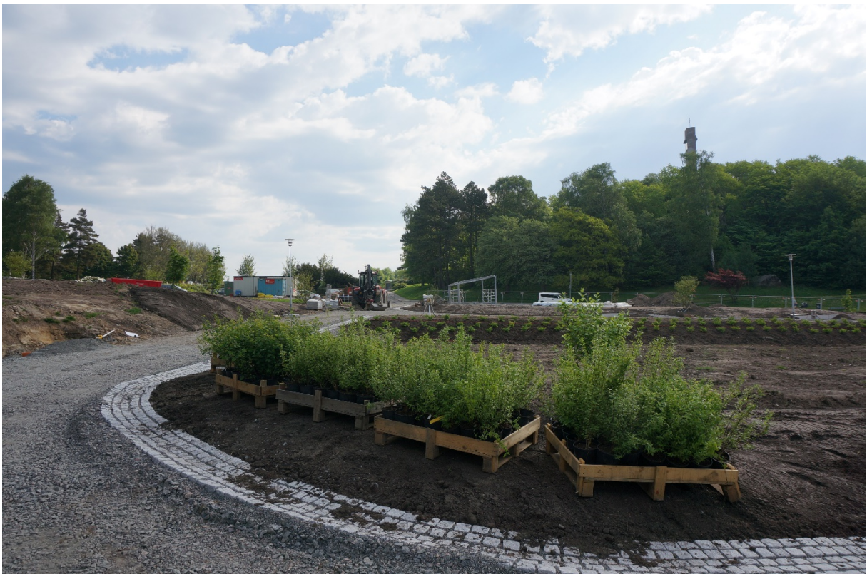
Områdets västra delar under uppförande. Plantering av buskar och anläggning av vägar pågår.
