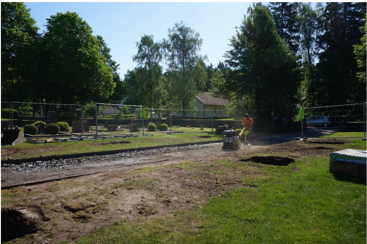
Arbetet med att anlägga gången upp mot platsen för lapidariet pågår.
