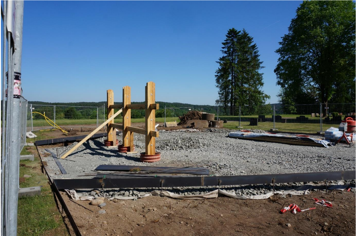
Platsen för lapidariet, under uppförande. Delar av träkonstruktionen är uppförd.
