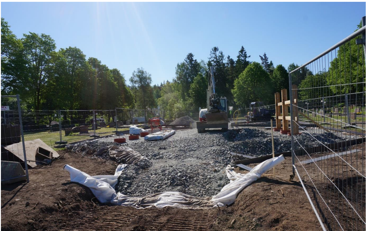
Platsen för lapidariet anläggs, grundas med dränerande material. Delar av konstruktionen är synlig till höger i bild.
