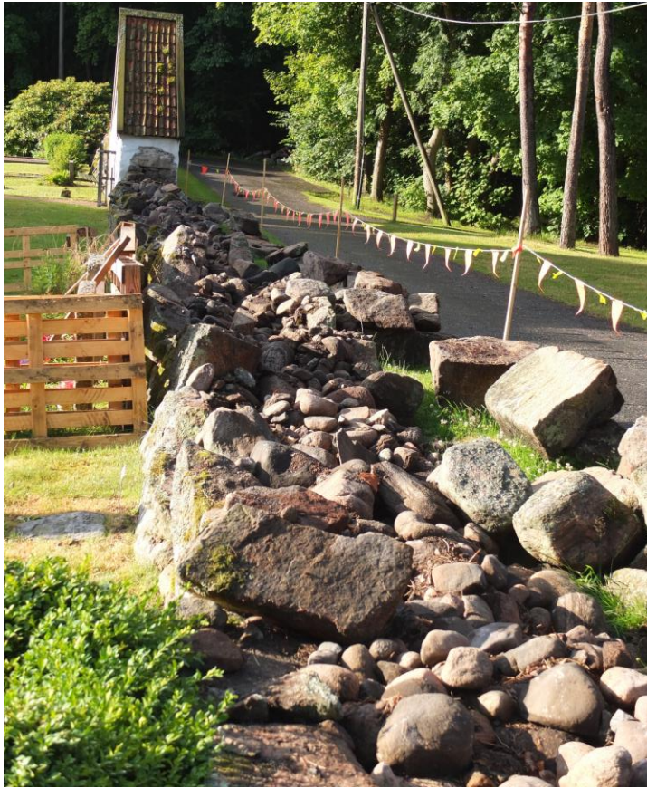
Den nordvästra delen av muren är riven, stora stenar läggs åt sidan och murens fyllnad rensas ur.
