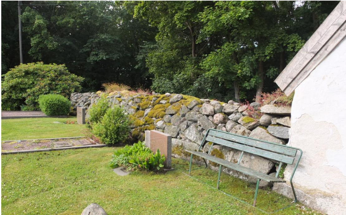
Sydvästra delen av muren före åtgärd, genomförd 2016.
