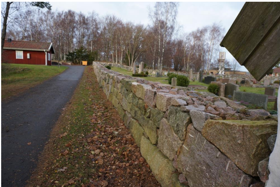
Den nordvästra delen av muren är färdigställd. Spår av klyvning finns med på bildens högra hörn. Detta ska åtgärdas under våren 2017.
