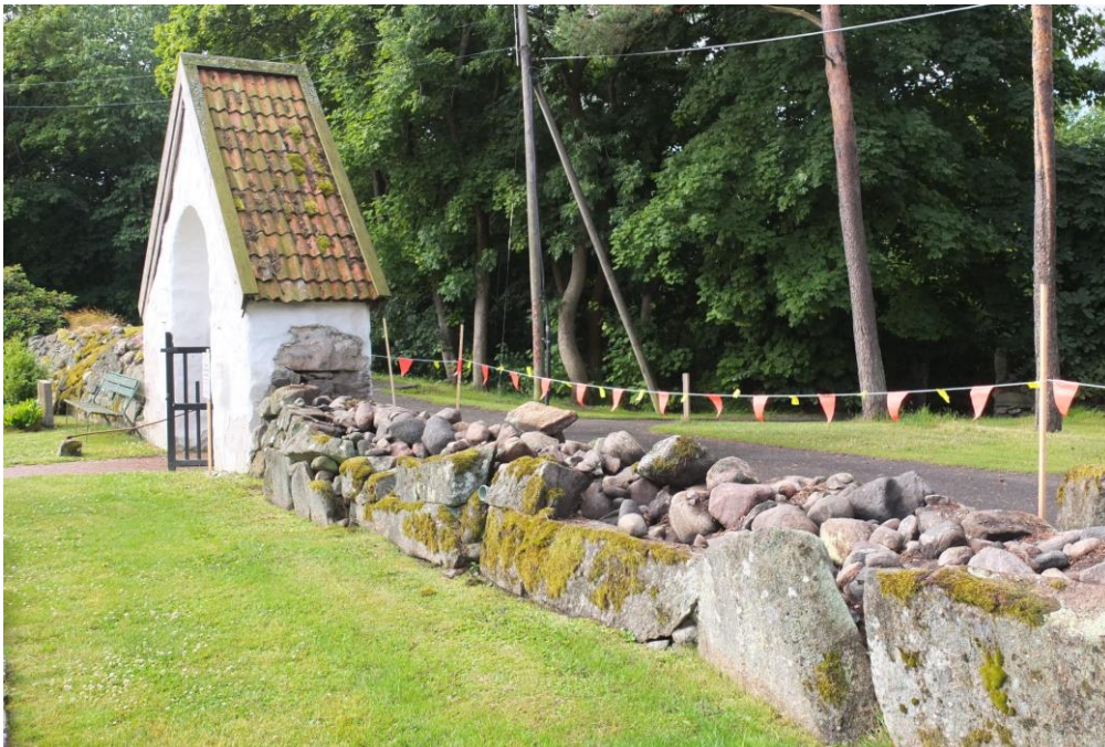
Delar av den nordvästra delen av muren är riven inför åtgärder. På bilden syns stora stenar som efter åtgärd använts för återuppbyggnaden av muren. Man har dock varit tvungen att lägga dem ner för att åstadkomma bra stabilitet.
