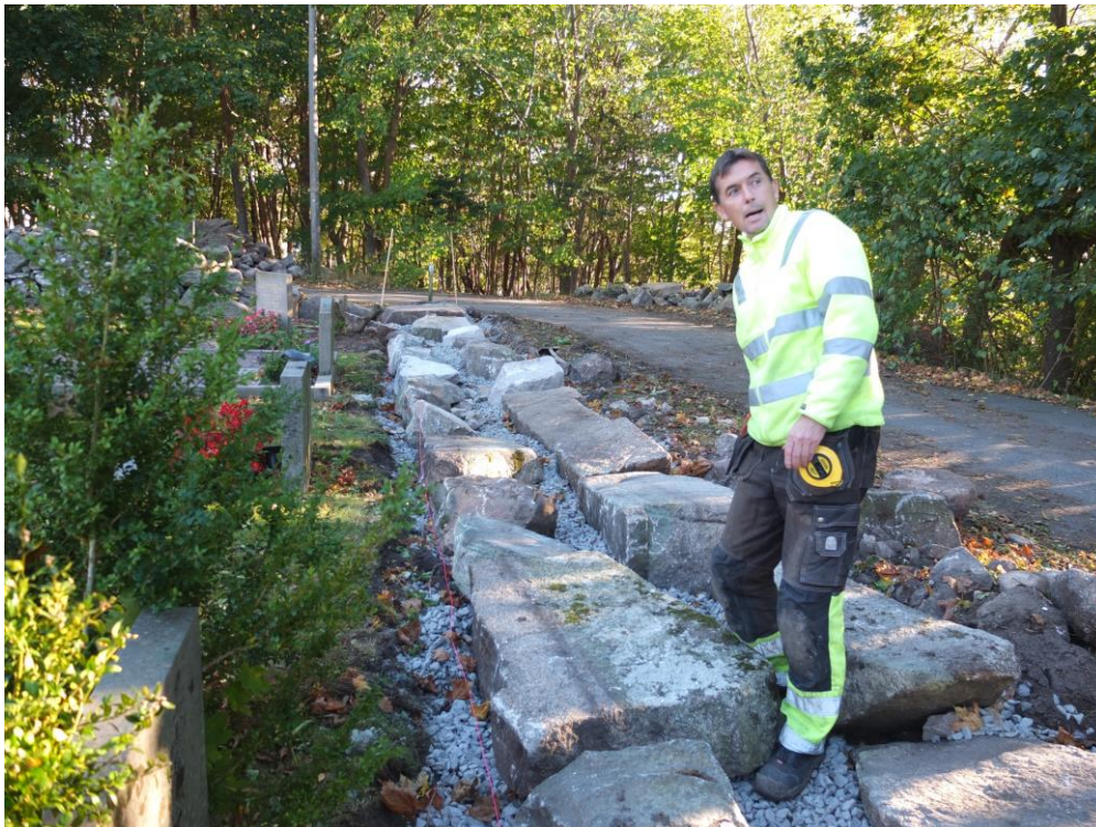
Den sydvästra delen av muren har rivits, underlaget har dränerats med stenmaterial i dimensionen 16/32.
