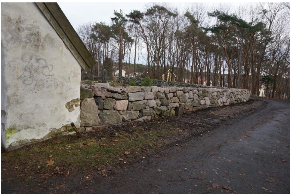
Den sydvästra delen av muren färdigställdes i november 2016.
