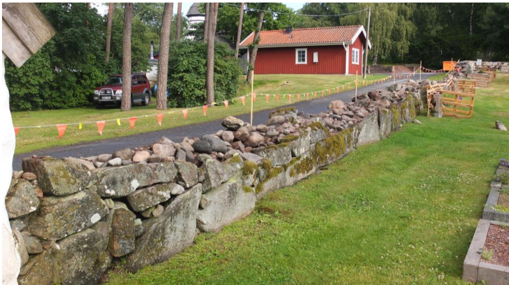
Den nordvästra delen av muren är delvis nedmonterad.
