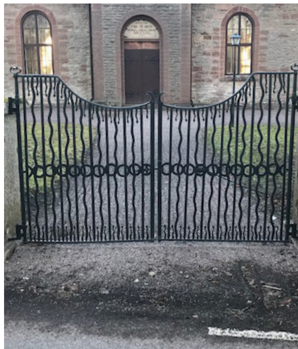
Grind och stolpe renoverades vid Medelplana kyrka.
