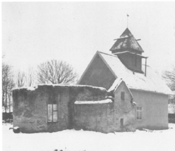
Kyrkan sedd från sydost under rivningen 1888. Foto: Sanfrid Welin, Skaraborgs länsmuseum
