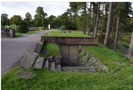
Den f.d. bårkällaren byggdes 1942.
