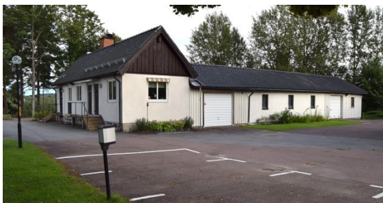
Personalbyggnaden uppfördes 1959 och har tillbyggt och sammanbyggt med ett garage.
