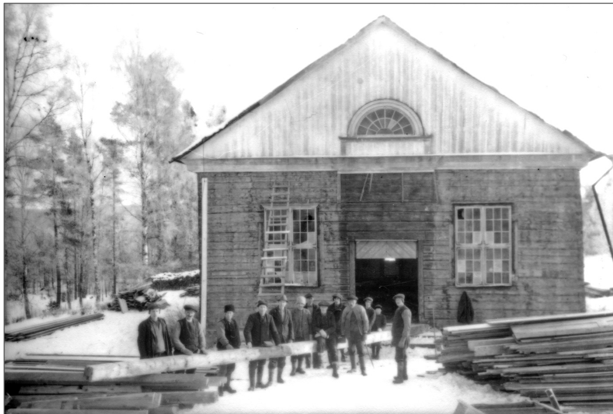
Bild tagen i början av år 1922, under pågående rivning av den gamla träkyrkan, uppförd i liggande timmer. Fotograf Einar Börjeson. Älvsbacka hembygdsförening.
