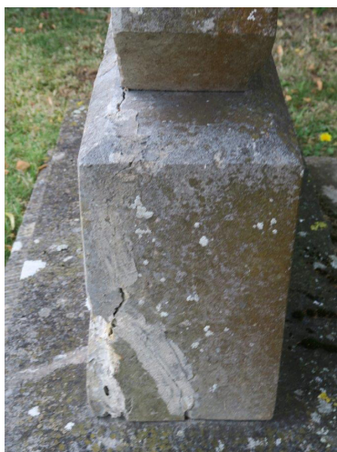
Exempel på skador på vårdar av kalksten. Till vänster har rostande dubb sprängt sönder en sockel. Till höger har vatten trängt in i sprickor och på vintern frusit och sprängt bort bitar av stenytan med följd att inskriptioner på sikt kan gå helt förlorade.
