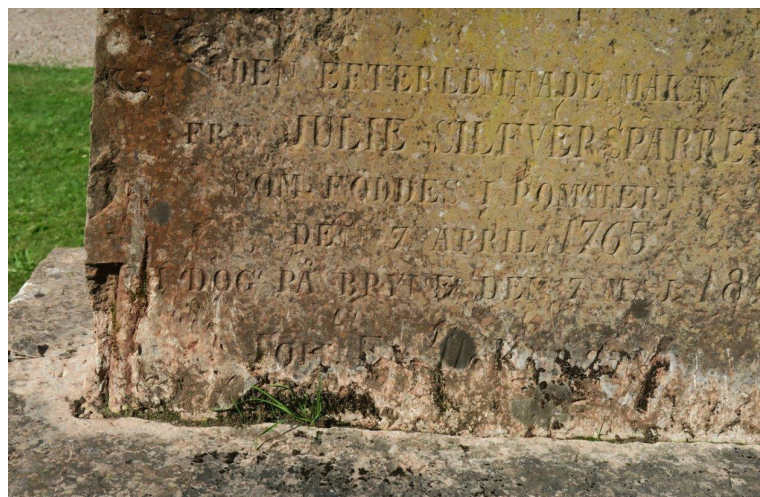
Exempel på skador på vårdar av kalksten. Till vänster har rostande dubb sprängt sönder en sockel. Till höger har vatten trängt in i sprickor och på vintern frusit och sprängt bort bitar av stenytan med följd att inskriptioner på sikt kan gå helt förlorade.
