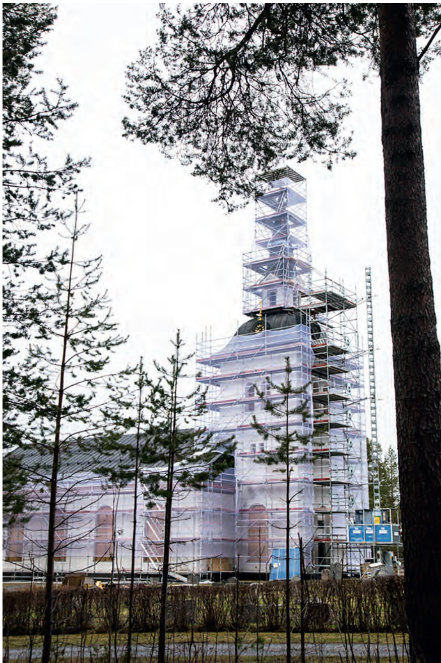
Hotagens kyrka får en ansiktslyftning, en renovering som kommer pågå hela sommaren.
