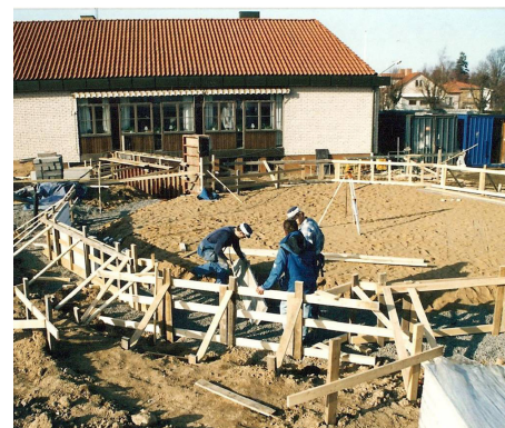
När kyrkan byggdes 1993.
