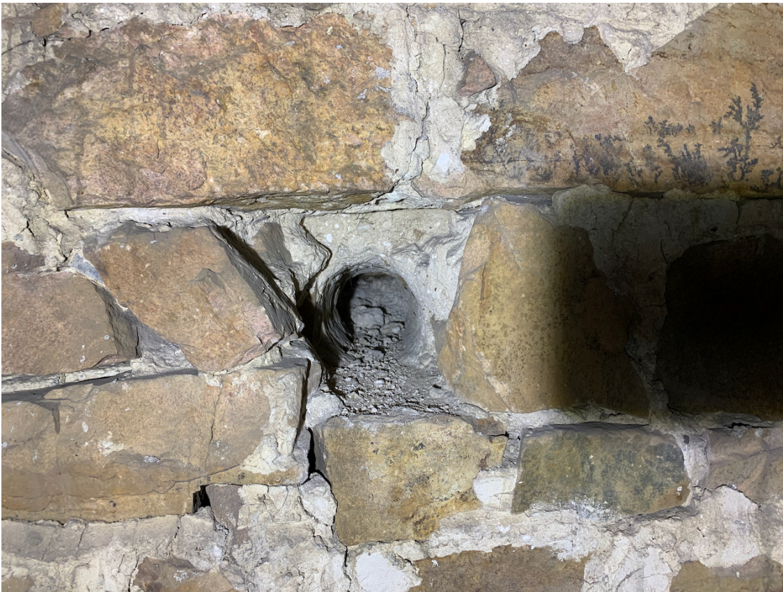
På södra sidoskeppet in i muren mot långhuset förekommer hål efter byggnadställningen i trä som använts vid arbetena.
