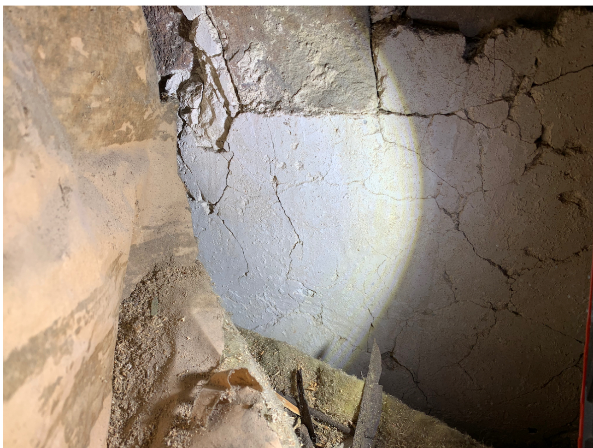
Enskiktspåts på det södra sidoskeppet.
