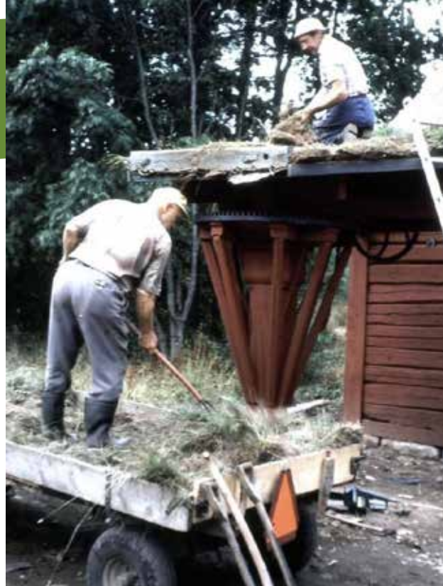
Kärt barn har många namn: Mulås, jordträ, stoppbräda, täckesbord m.fl. Här ser vi Möbel-Folke Johansson och Mauritz Adolfsson i Gunnarsbo i färd med att lägga dit mulåsen till det torvtäckta taket på tröskverksvandringen i Mullsjö Hembygdspark.
