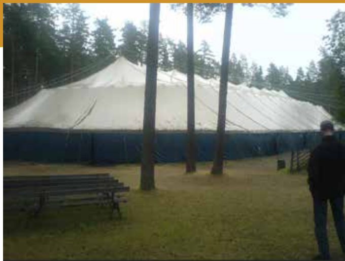
2008 var sista året som tältet användes. Stora sprickor hade gjort att det regnade in. Foto: Mattias Klarén.
