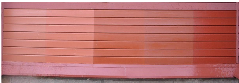
Provmålningar på fasaden visar olika färgfabrikat av linoljefärg samt olika nyanser av röd fasadfärg. Färdig provyta, 180911.
