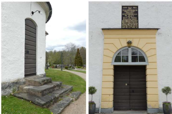
Till vänster visas korngången i öster. Ingången är numera igensatt invändigt. T:n av trappstenarna utgörs av en äldre gravbäll. Till höger visas kyrkans västport vars utformning är intaget sedan 1834.
