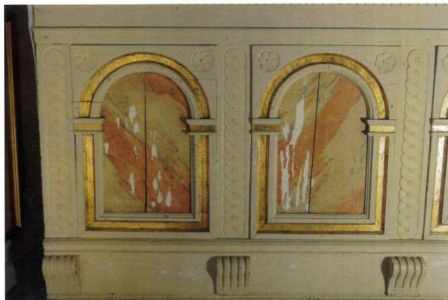
Detalj efter nedfästning av uppskalningar och uppspackling av lakuner.
