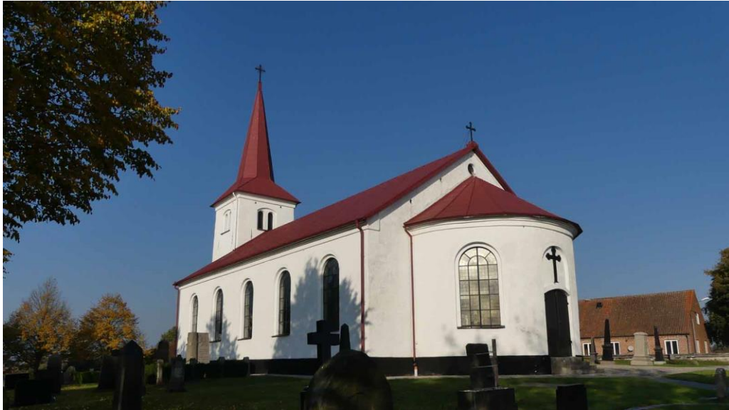
Kyrkan sedd från sydost.
