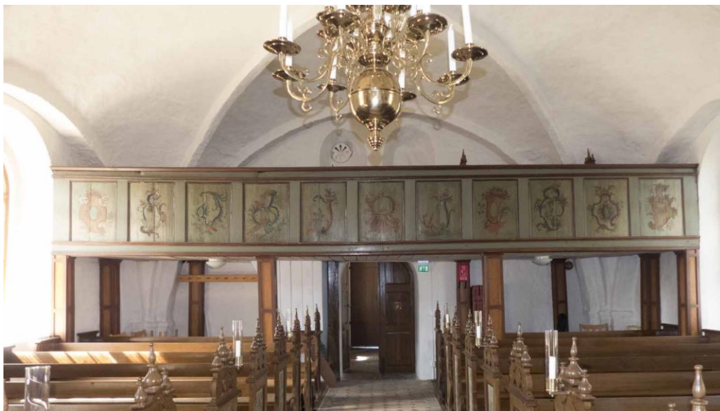
Långhuset sett mot väster. Läktaren har anor från 1700-talet men byggdes om 1932. Ovanför läktarbarriären syns de inre mursmygarna till två av kyrkan ursprungliga fönsteröppningar.
