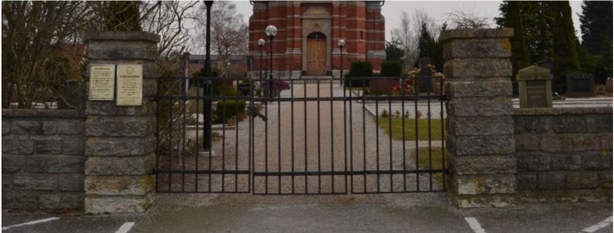
Huvudentrén mot väster har en gånggrind och en vikbar körgrind av svartmålat stål och grindstolpar av kalksten.
