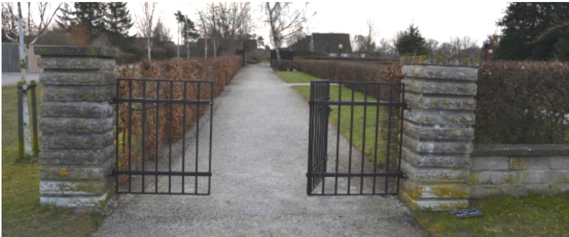
Den nordöstra entrén leder in till en grusgång med avenbokshäckar. Entrén har en gånggrind och en vikbar körgrind med grindstolpar av kalksten.
